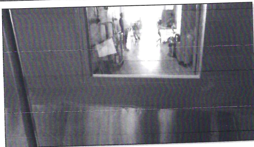
FOTO N°03 - 12/09/2023: Se observa el deterioro en puertas recubiertas con INOX 3mm , el área de Emergencia
