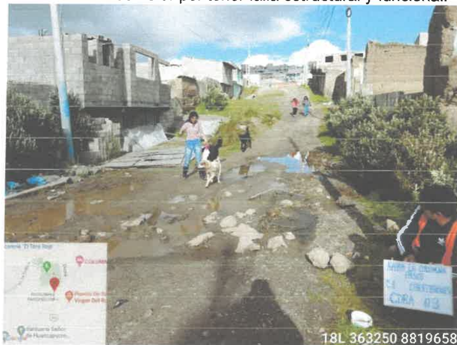
Fotografía N°03- fin de Ca. Libertadores Cdra03. Se aprecia los daños a la superficie de rodadura por falta de pendientes.
