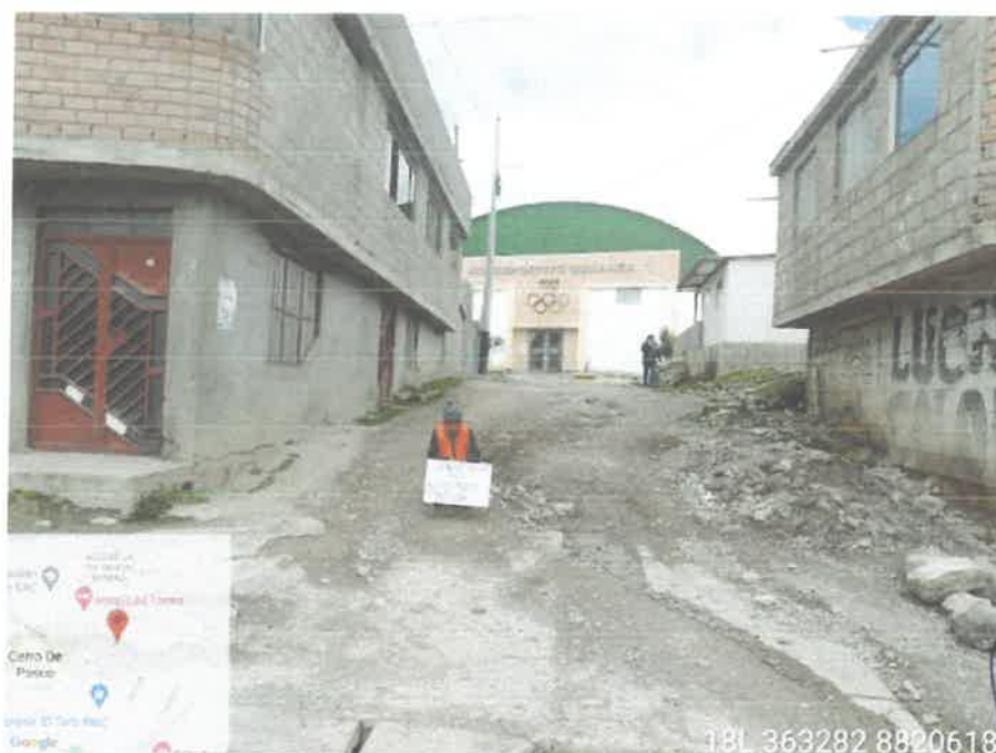
Fotografía N°16.- FIN de Av. Luis Aguilar Cdra08. Se aprecia el daño de la superficie de rodadura con la falta de cunetas pluviales.
