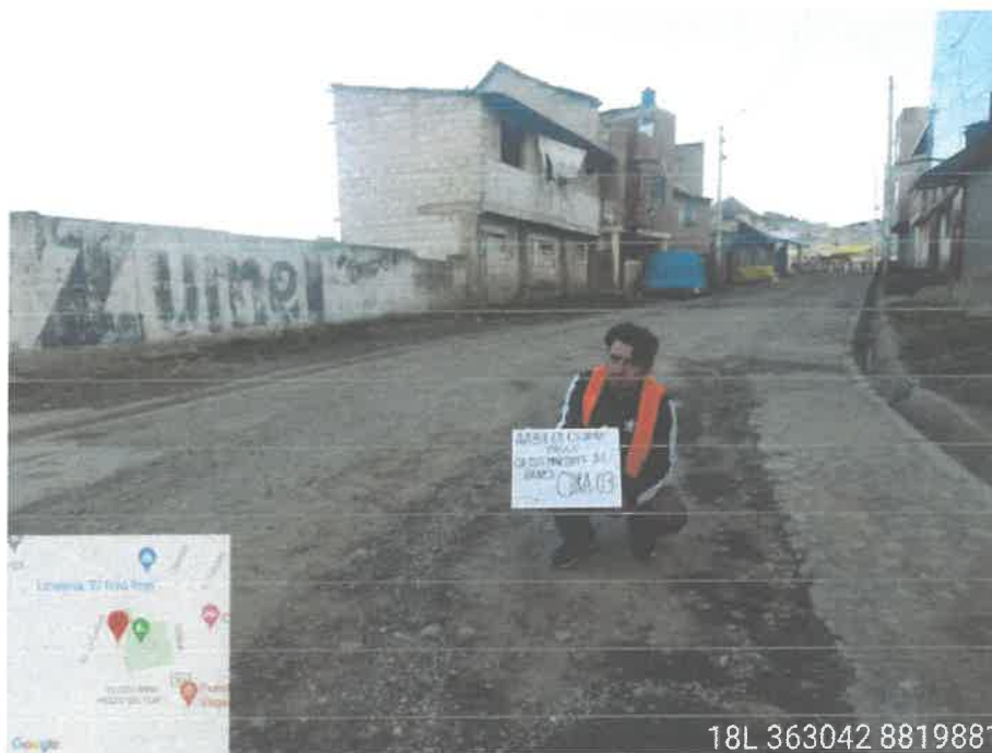
Fotografía N°01.- FIN de Ca. Los Mártires de Ranca Cdra03, se aprecia el pavimento existente de sección variable a demoler por falla estructural y funcional.
