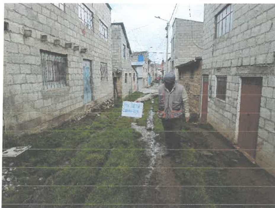
Fotografía N°08.- MITAD de Psj. Lucanas Cdra03. Se aprecia la sección reducida y los daños de las aguas pluviales a la superficie de rodadura.
