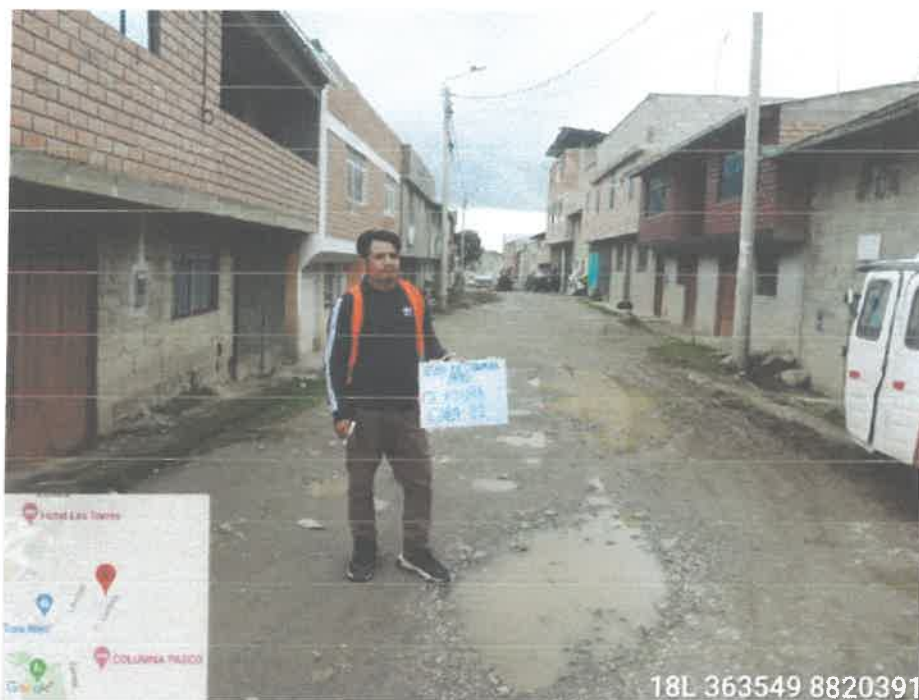
Fotografía N°11.- inicio de Ca. Piura Cdra02, se observa falta de pendiente en la superficie de rodadura.
