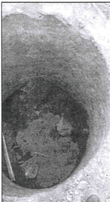
Fuente: Expediente técnico: VISTA DE LOS BUZONES EN MAL ESTADO
