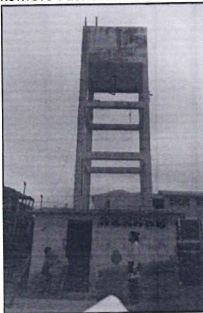
Fotografía N°04: TANQUE ELEVADO EXISTENTE SE ENCUENTRA AL INTERIOR DEL INSTITUTO Y ESTÁ DETERIORADO E INOPERATIVO
