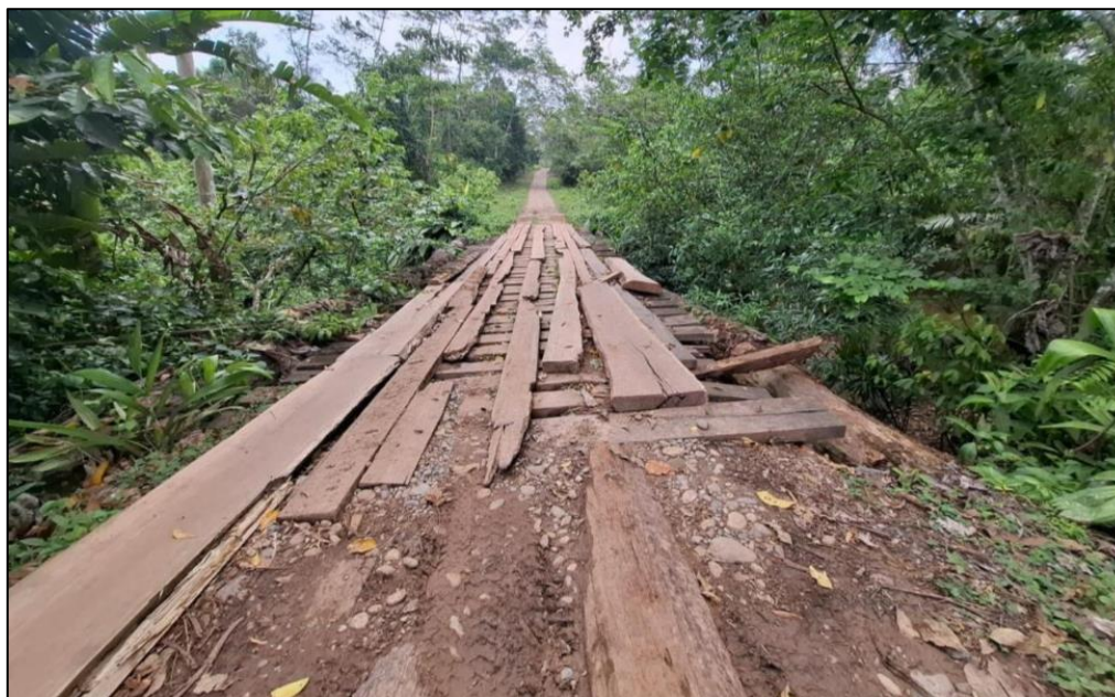
Figura N°7. Puente Alto Galicia de madera existente en malas condiciones
