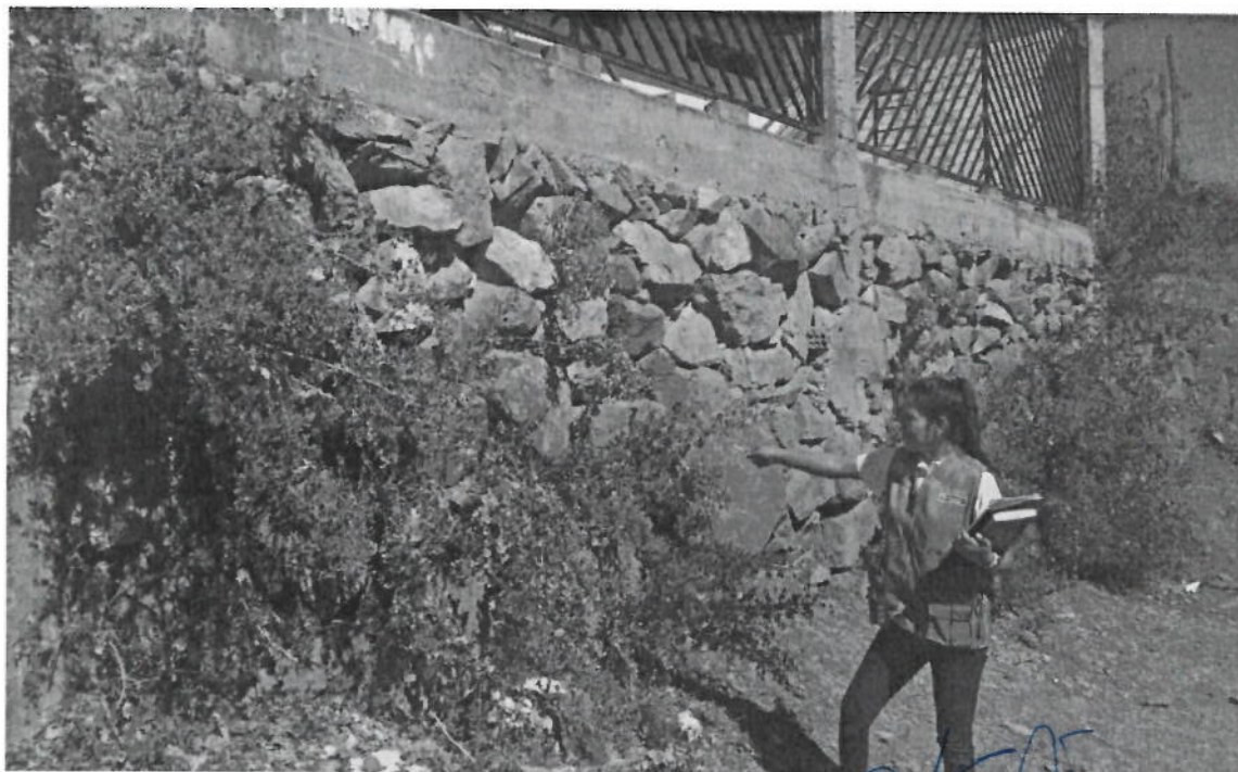
Foto N° 04: Se observa la carga del relleno que existe al lado del pabellón 7, donde a su vez no está construido adecuadamente el muro de mampostería de piedra
