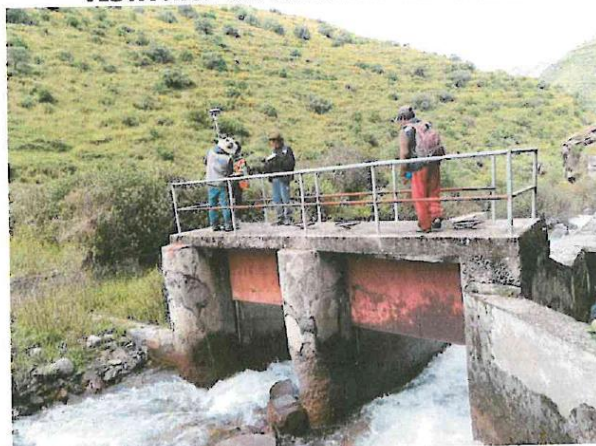
Se observa el mal estado de la bocatoma
