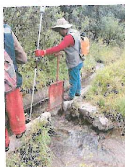
Compuerta metalica para canal en estado regular de conservacion, continuidad del canal de conduccion desaparecidas CAMARAS DE CARGA
