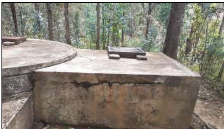
Foto N° 06 y 07: Tapas metálicas oxidadas
