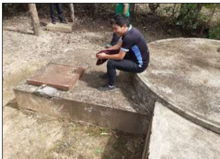
Foto N° 06 y 07: Tapas metálicas oxidadas
