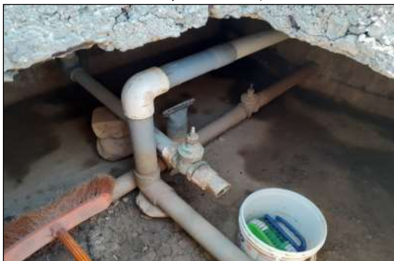
Foto N° 08: Cajas de válvulas inoperativas
