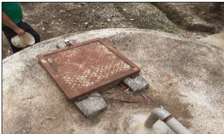
Foto N° 08: Cajas de válvulas inoperativas
