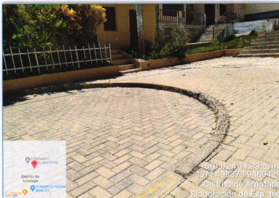
Fotografía N°02: Sardinel peraltado en estado de deterioro, por lo que se propone su demolición y reposición del mismo, según detalle de planos
