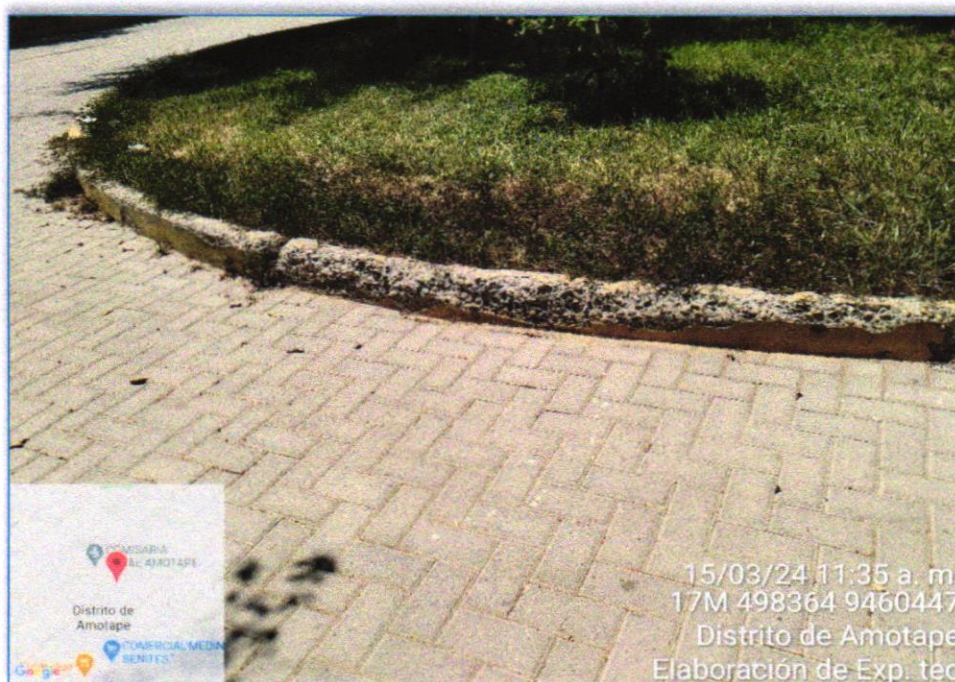
Fotografía N°04: Tal como se aprecia en la fotografía se visualiza el sardinel sumergido en malas condiciones, por lo que se propone su demolición y reparación.
