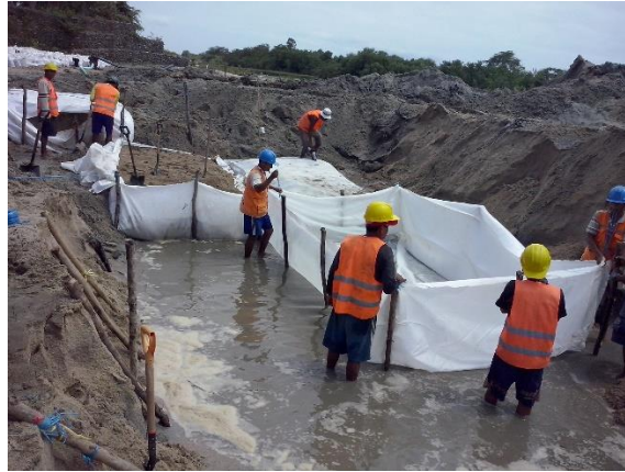
Figura 3 Habilitado de la Bolsas de Geotextil tejido de alta Resistencia vacía con estacas de Madera
