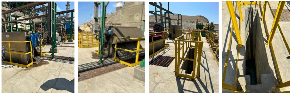
Reja de Desbaste, Tamiz Rotativo y Puntos para Bloqueo con ataguías.
