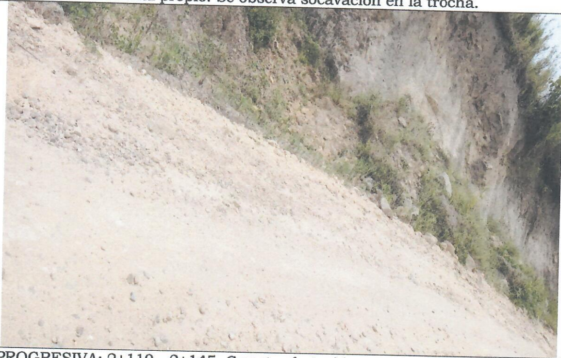
PROGRESIVA: 2+110 - 2+145. Cuneta obstruida por material de derrumbre. Se observa socavación en la trocha.
