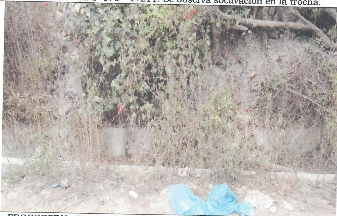
PROGRESIVA: 1+760 - 2+960. Cuneta obstruida debido a colmatación y maleza.
