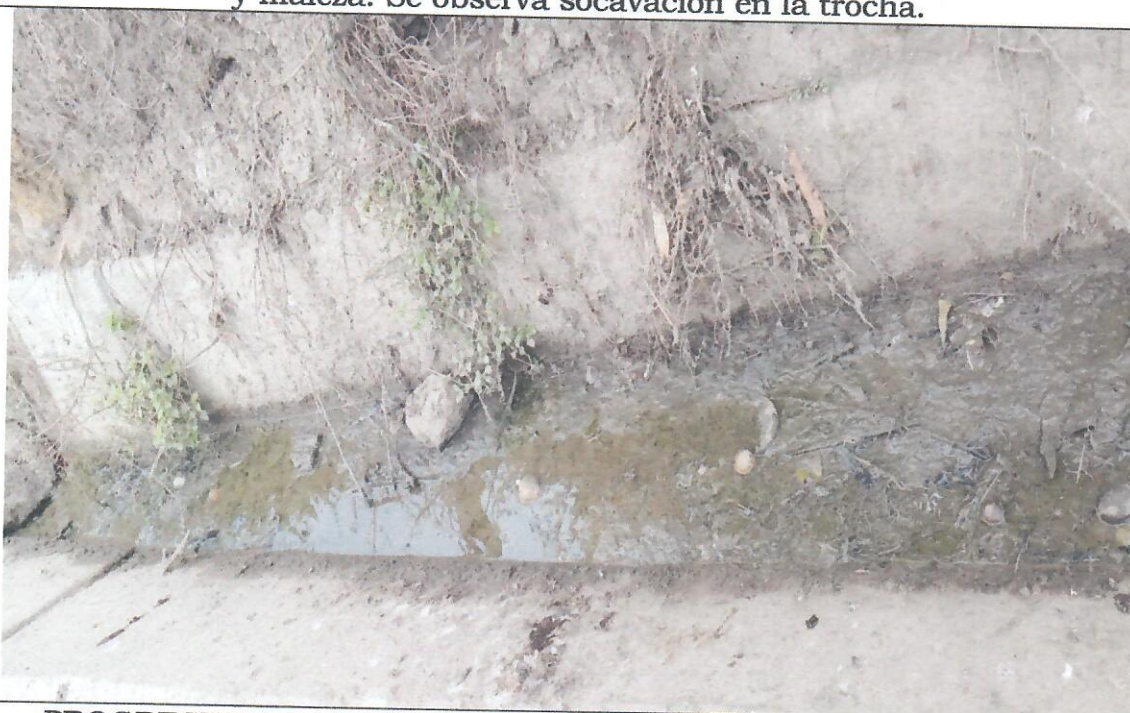
PROGRESIVA: 2+960 - 3+260. Cuneta obstruida por maleza y aguas residuales.
