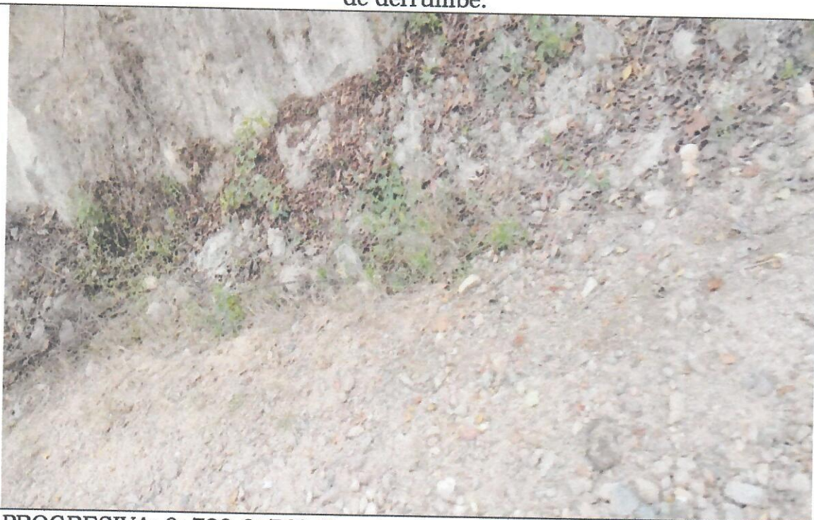
PROGRESIVA: 0+720-0+760. Cuneta obstruida por material de derrumbe y malezas. Se observa erosión de la trocha.
