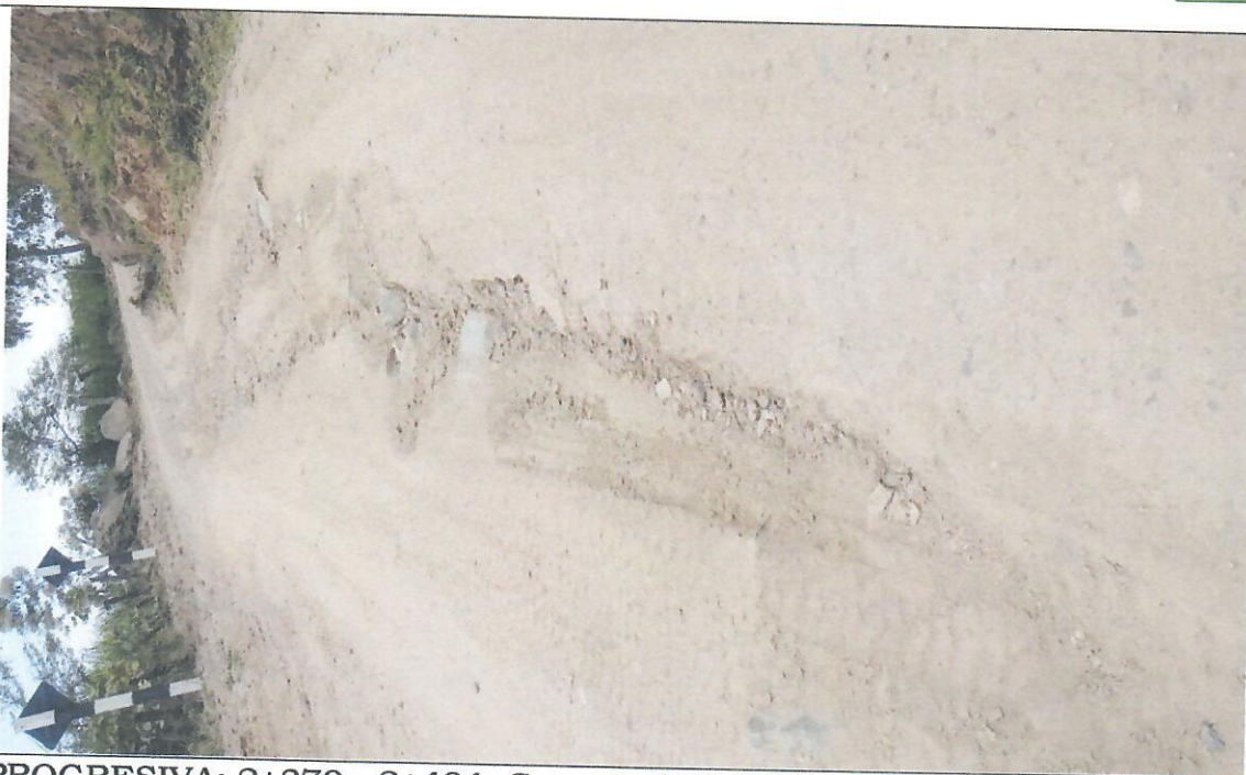
PROGRESIVA: 2+370 - 2+404. Cuneta obstruida por material de derrumbre y maleza. Se observa socavación en la trocha.
