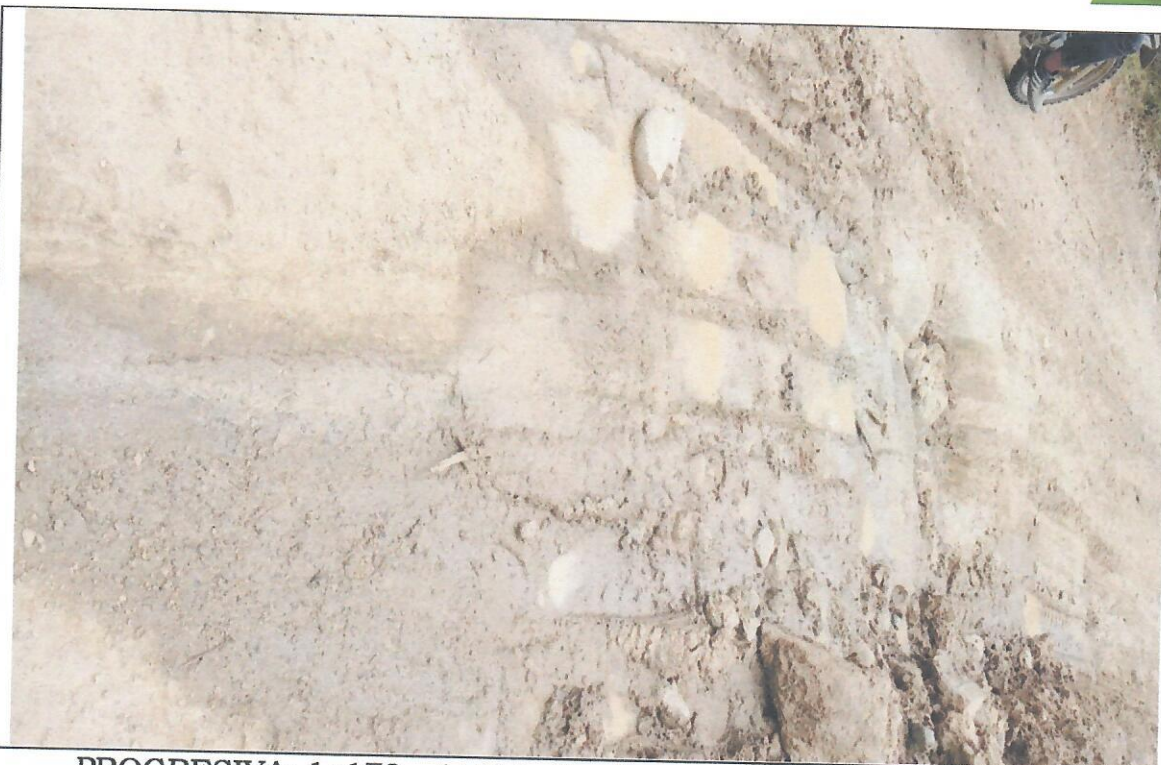
PROGRESIVA: 1+170 - 1+211. Se observa socavación en la trocha.
