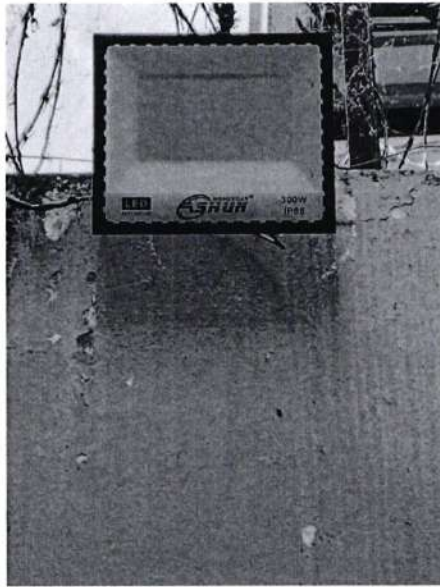
Imagen 33. REFLECTORES LED 200W, 22000 lm, 6500 K
