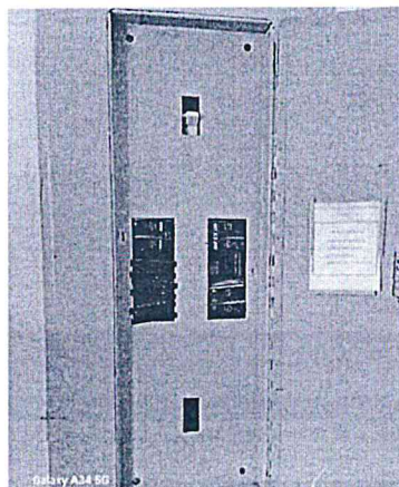
Imagen 26. SUBTABLERO DE TALLERES TD, 220V, 60Hz, 3F
