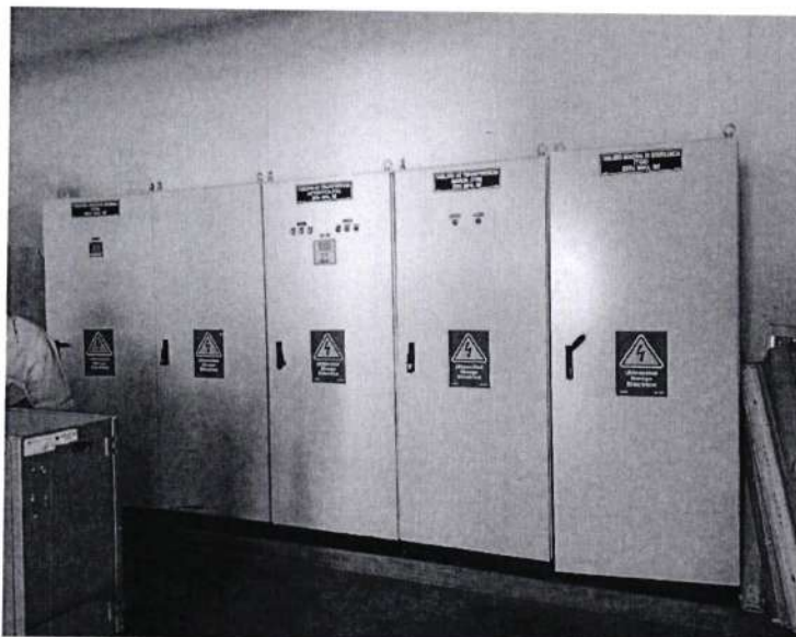
Imagen 6. Tablero general (TGN), tablero de transferencia automática (TTA), tablero de transferencia manual (TTM) y tablero general de emergencia
