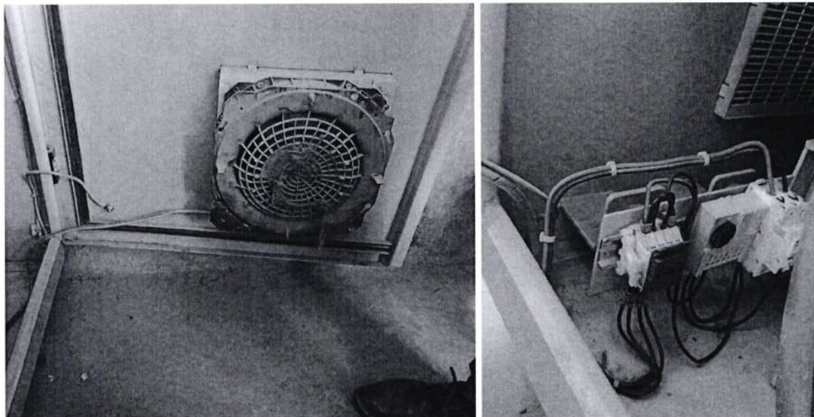
Imagen 19. Sistema de Ventilación del Transformador Seco 315 Kva.
