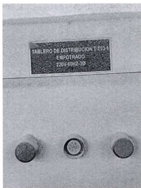
Imagen 24. SUBTABLERO DE TALLERES T-T03-01, 220V, 60Hz, 3F
