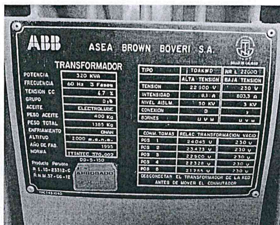
Imagen 3. Celda de transformación (Transformador 320kVA, 22.9/0.23kV, 60Hz, ONAN)
