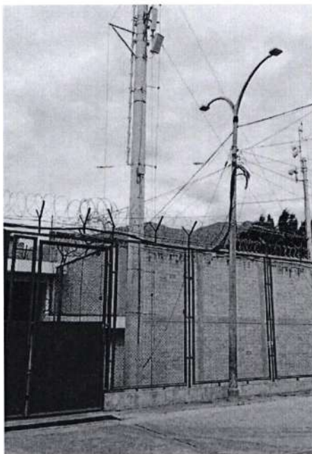
Imagen 29. LUMINARIA CON LAMPARA LED 150W,220V, 19 500 lm, 130 lm/W, 6 500 K
