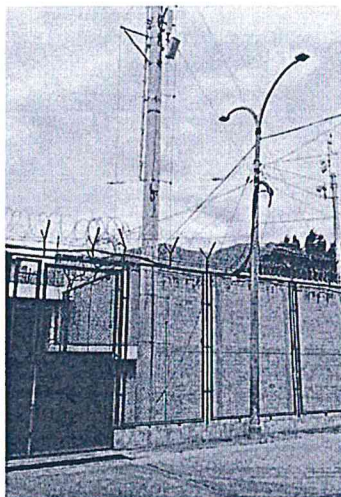
Imagen 29. LUMINARIA CON LAMPARA LED 150W,220V, 19 500 lm, 130 lm/W, 6 500 K
