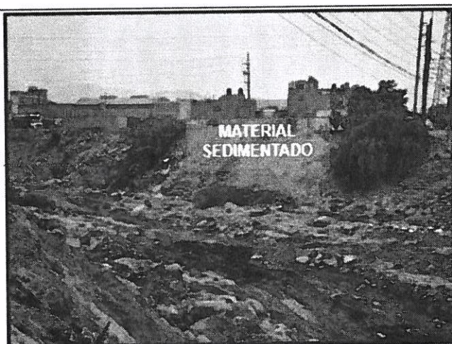
FIGURA N° 02: MATERIAL COLMATADO EN EL CAUCE DE LA QUEBRADA HUAYCOLORO, CON UNA PROFUNDIDAD APROX. 1.50M. ESTO PROVOCA QUE DESBORDAMIENTO DE LA QUEBRADA SEA MAS INMINENTE.
