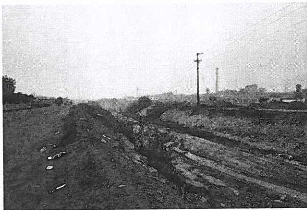
IMAGEN N° 05: TRAMO CRITICO, CON PRESENCIA DE MATERIAL ORGANICO Y RESIDUALES Y MATERIAL SEDIMENTADO, MARGEN DERECHO Y MARGEN IZQUIERDA. - PROVINCIA DE LIMA, DEPARTAMENTO DE LIMA.
