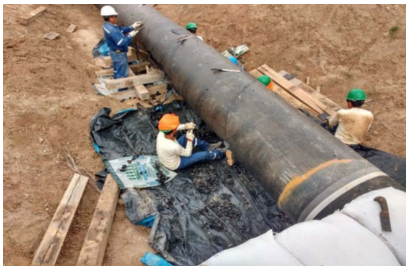
Gráfico N° 7 – Retiro de Poliken, actividad previa a la limpieza mecánica
