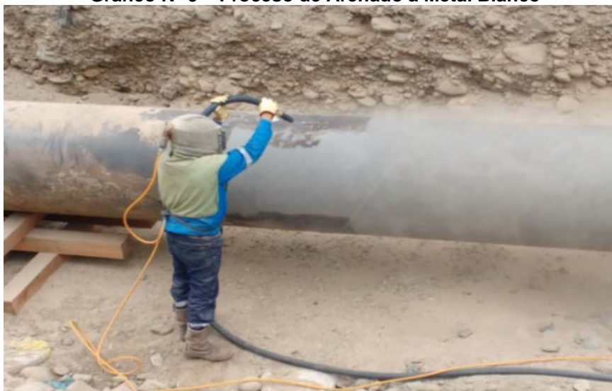
Gráfico N° 9 – Proceso de Arenado a Metal Blanco
