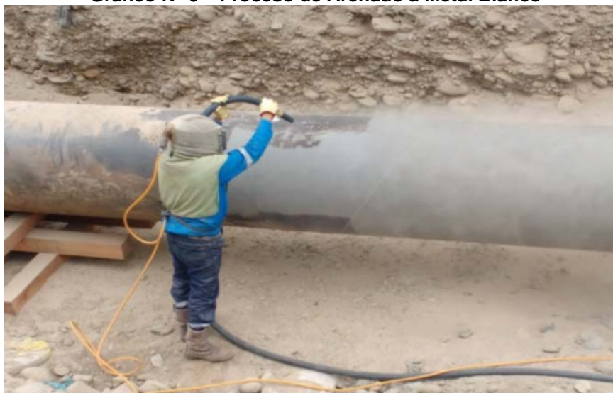
Gráfico N° 6 – Proceso de Arenado a Metal Blanco
