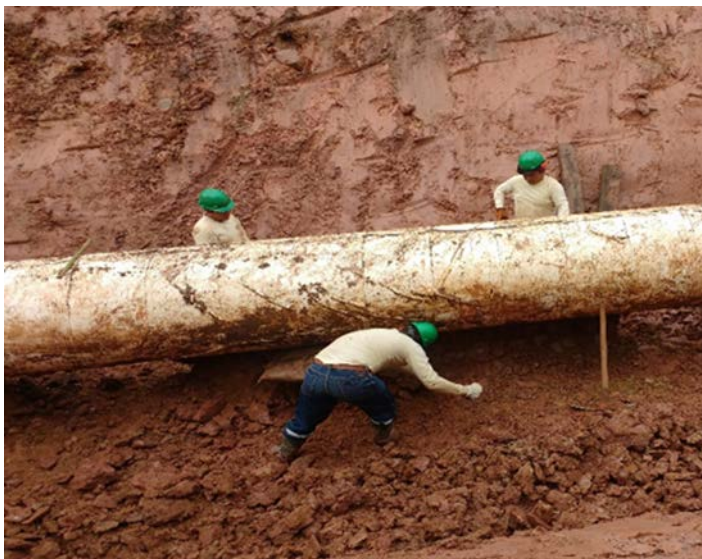
Gráfico N° 2.: Excavación manual, para liberar la tubería
