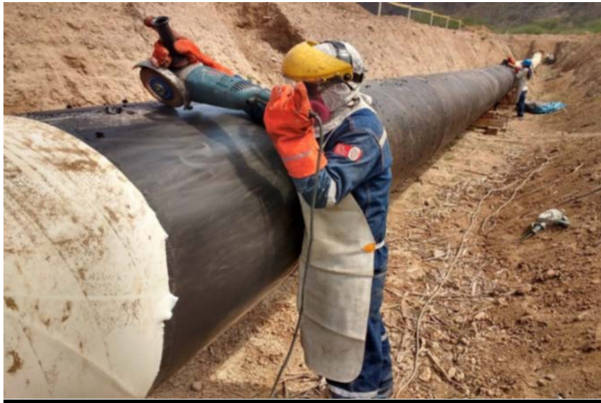
Gráfico N° 8 – Limpieza mecánica con amoladora, del ONP
