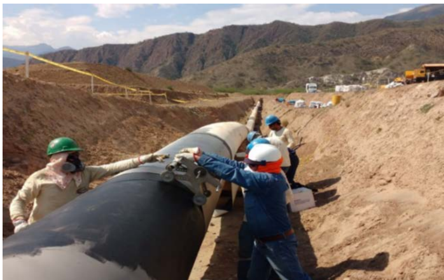
Gráfico N° 10 – Colocación de Polyguard
