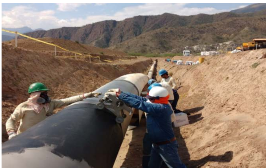
Gráfico N° 7 – Colocación de Polyguard
