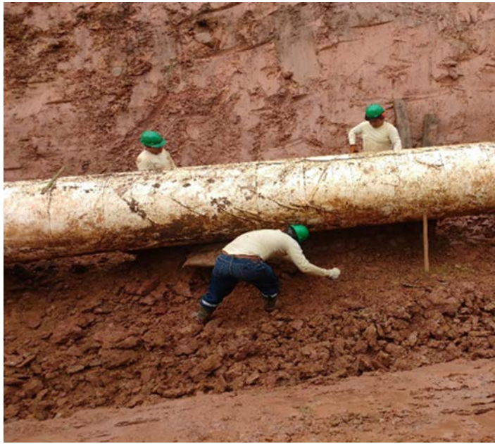
Gráfico N° 5.: Excavación manual, para liberar la tubería
