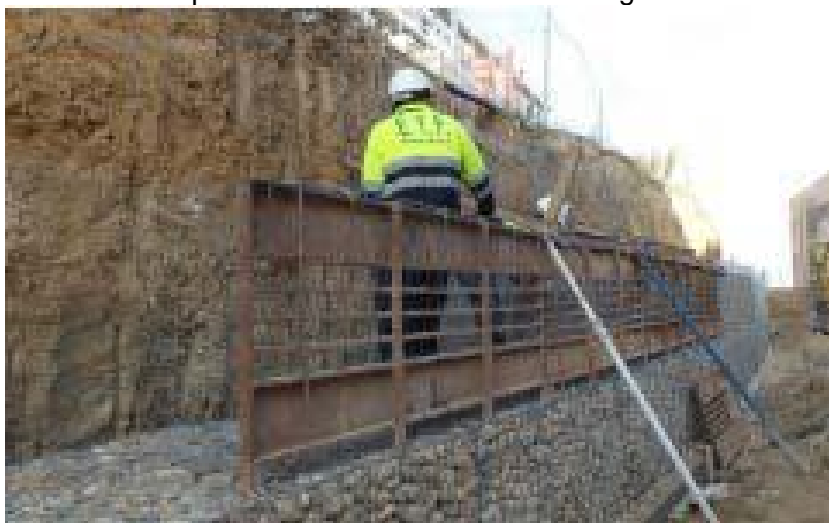
Esquema del encofrado exterior del gavión
