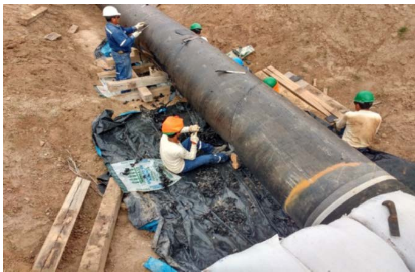
Gráfico N° 5 – Limpieza mecánica con amoladora, del ONP
