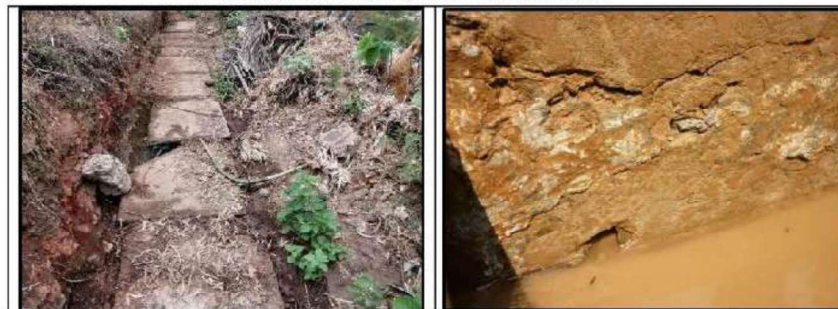
Ilustración 8: Vista fotográfica del Tramo de canal entre presedimentadores y caseta, se observa el deterioro de las tapas y de los muros del canal.
