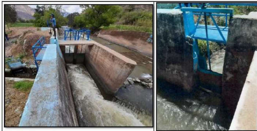
Ilustración 4: Vista fotográfica de la Captación y la ventana de ingreso
