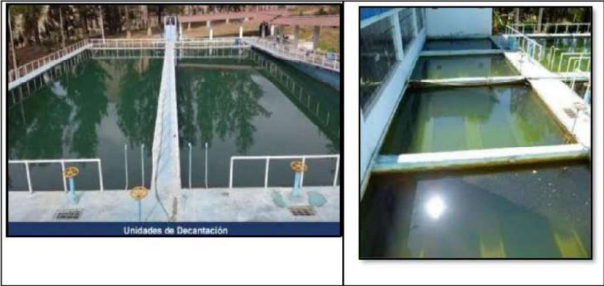
Ilustración 14: Vista fotográfica del Decantador y la batería de 4 Filtros en la Planta N° 01
