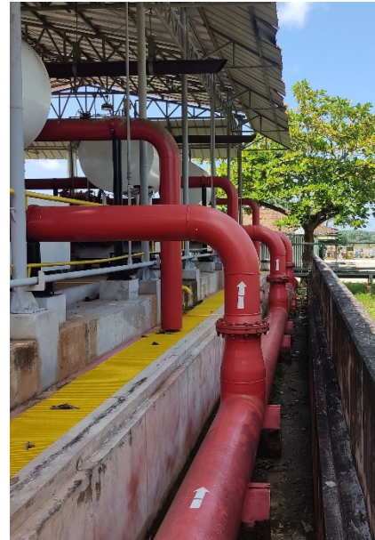
Motobomba Contraincendios y Línea de Succión.
