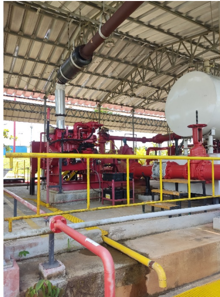
Motobomba Contraincendios y Línea de Succión.
