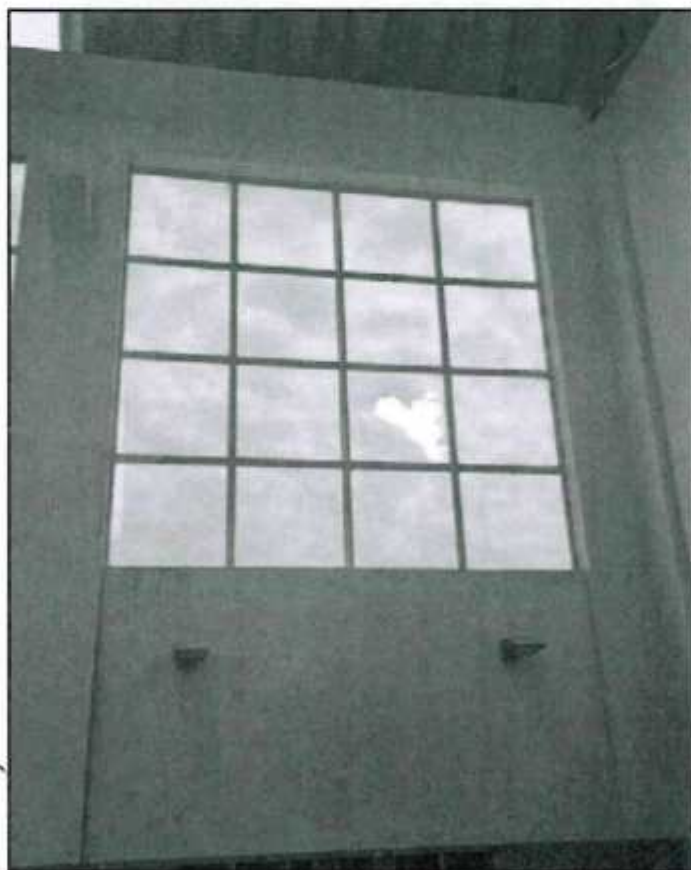
REEMPLAZO DE VIDRIO LAMINADO 1.10 x 0.90 m:
