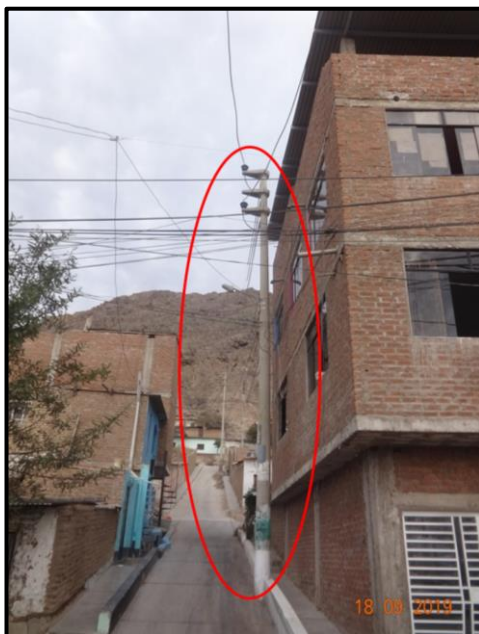
Figuras N° 06 Poste de media y baja tensión, expuestos a impacto vehicular
