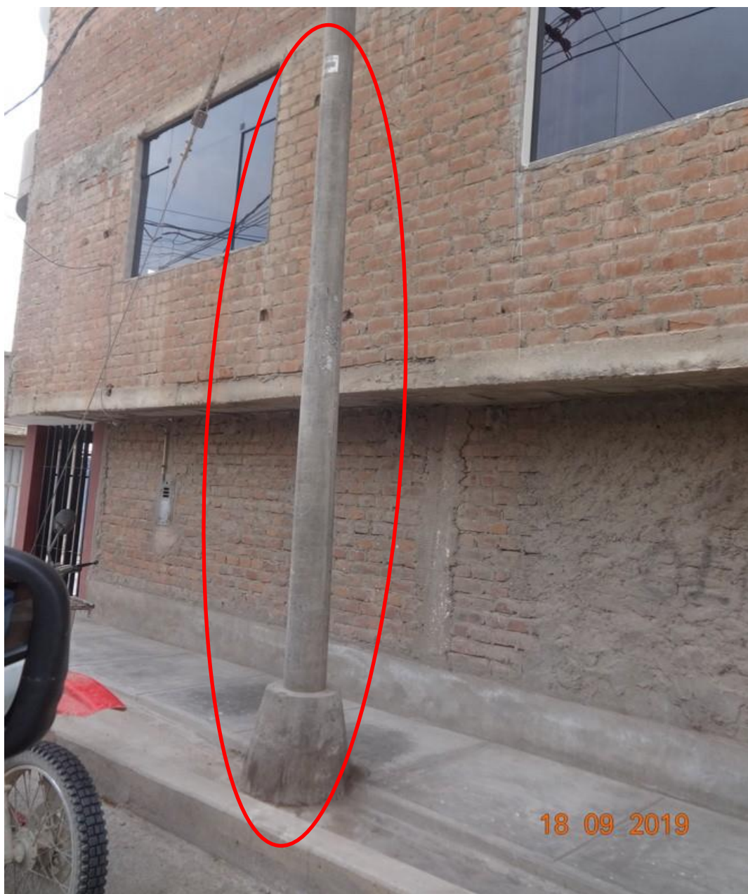
Poste de concreto de baja tensión deteriorada.
