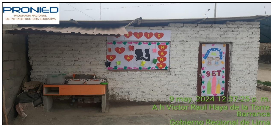
Imagen N°09: Aula de color blanco que requiere instalación de ventanas con rejas de seguridad y cambio de cobertura.
