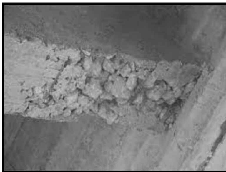
Imagen N° 03: (Se visualiza en la siguiente imagen cangrejeras en toda la longitud de la viga del puente existente, por lo que ya no se recomienda el tránsito de vehículos por riesgo al colapso)
