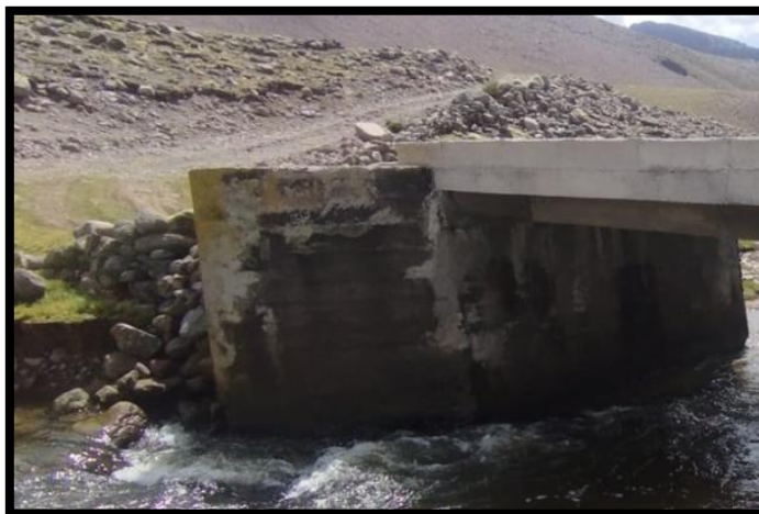
Imagen N° 01: (En la presente imagen se puede observar la estructura en deterioro) El Puente se presenta en condición precaria, la subestructura del estribo del puente existente con daño severo en el base ocasionado por la socavación del río.
