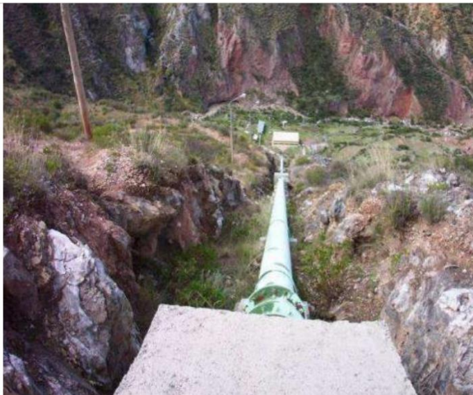
Tubería forzada, desde la cámara de carga
