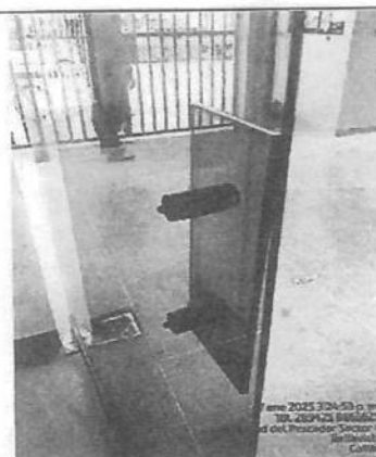
Foto 3. Reparación, ajuste y suministro de accesorios para jaladeras de las mamparas.
