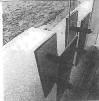
Foto 6. Reparación, ajuste y suministro de accesorios para jaladeras de las mamparas.
