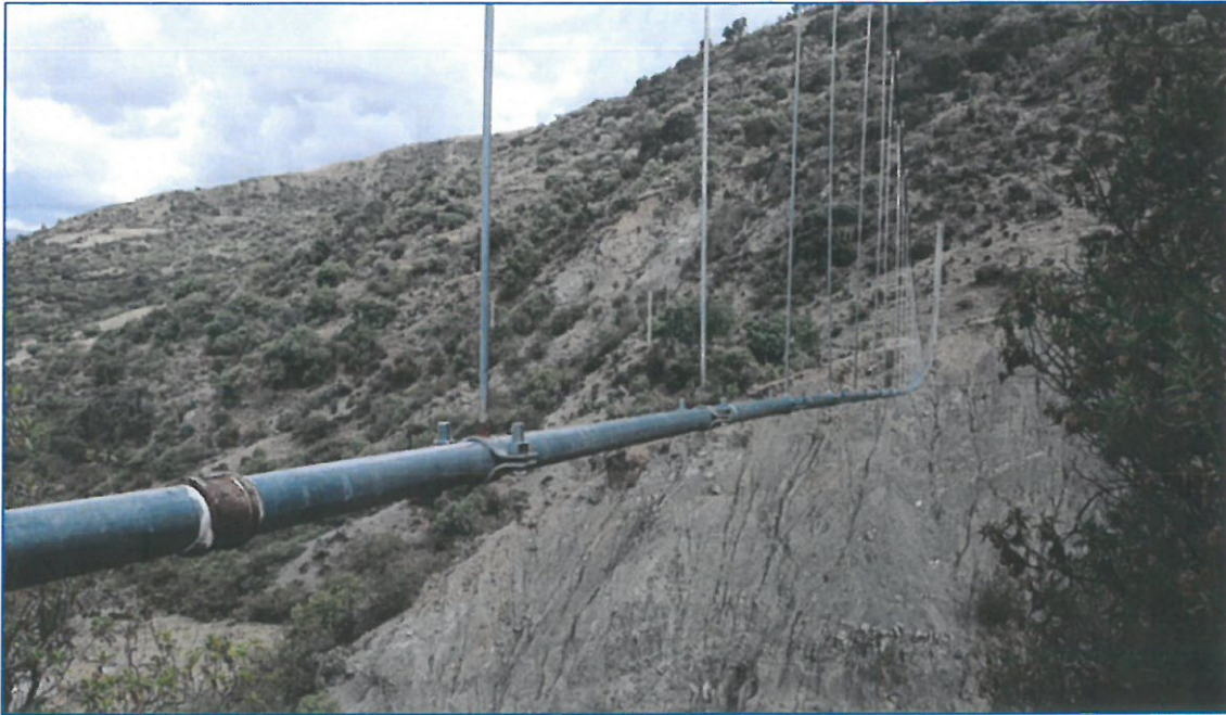
Imagen N° 2.19: Tubería metálica oxidado en Cruce Aéreo N° 01 sistema II localidad de Ccochancay.
