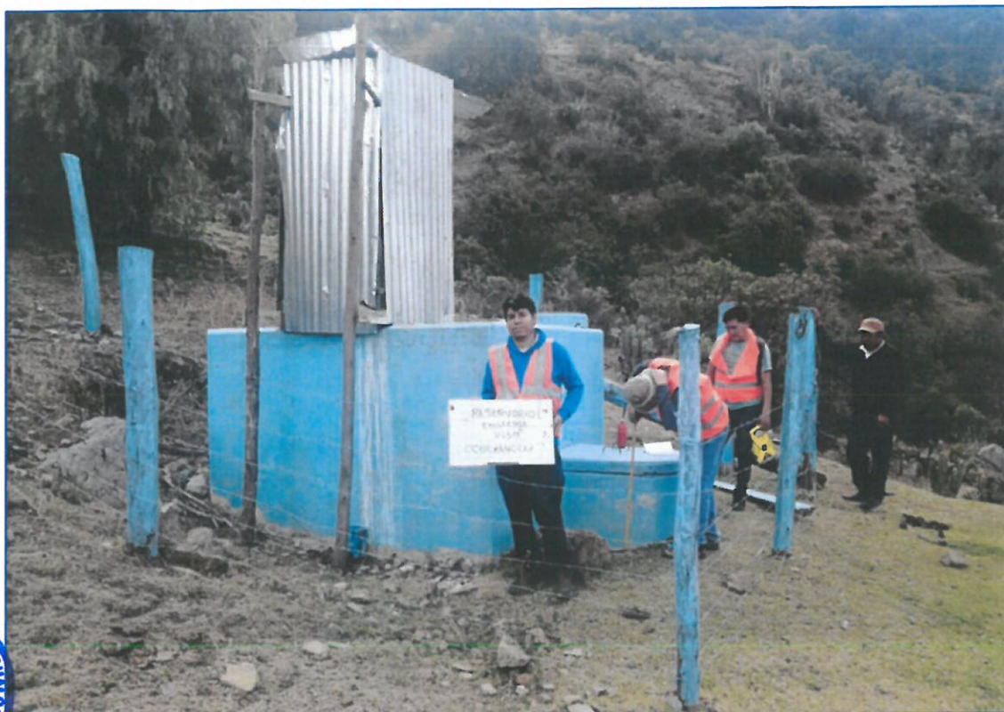
Imagen N° 2.25: Reservorio existente V=5.0 m3 sistema I localidad de Ccochancay.
