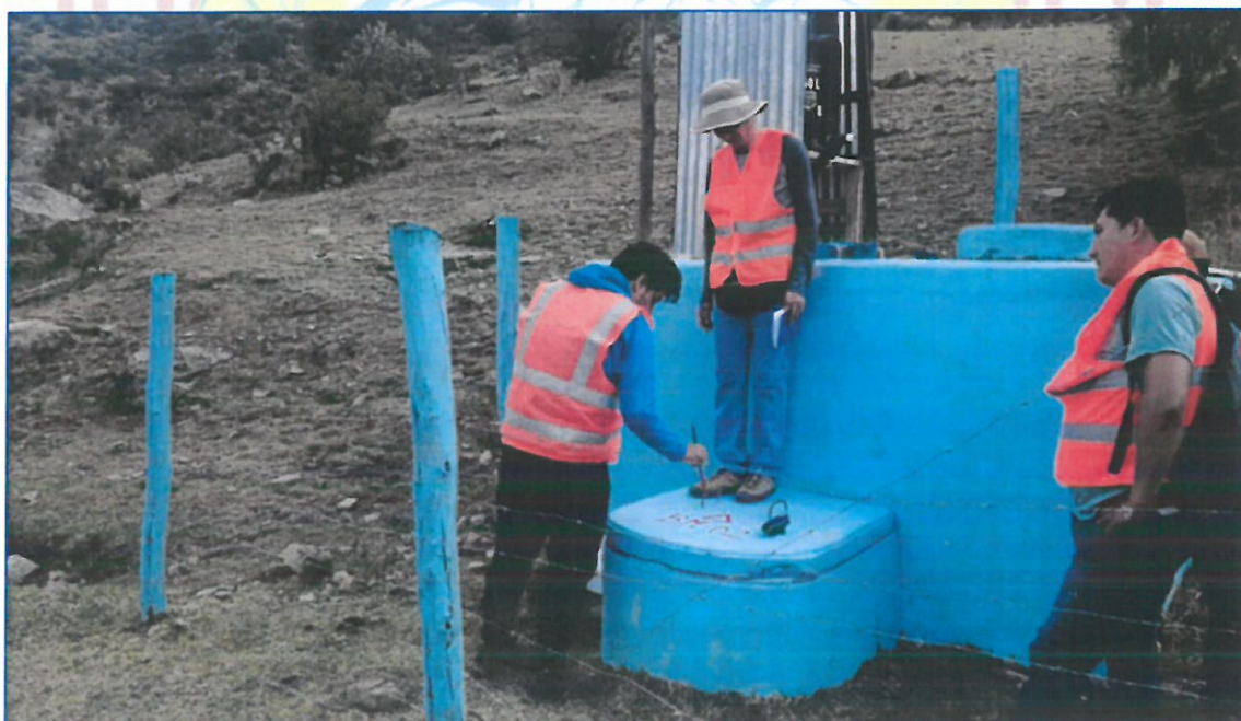
Imagen N° 2.28: Monumentado de BM's en reservorio existente V=5.0 m3 sistema I localidad de Ccochanccay.
