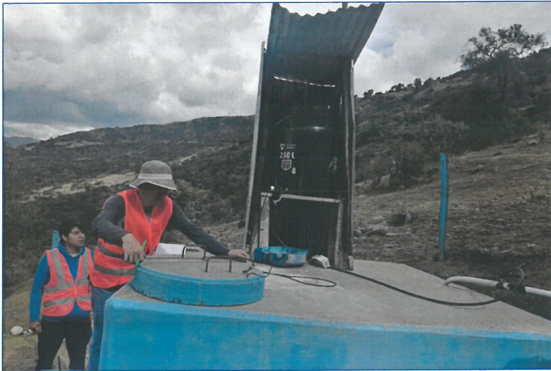
Imagen N° 2.29: Toma de datos del reservorio existente V=5.0 m3 sistema I localidad de Ccochancay.
