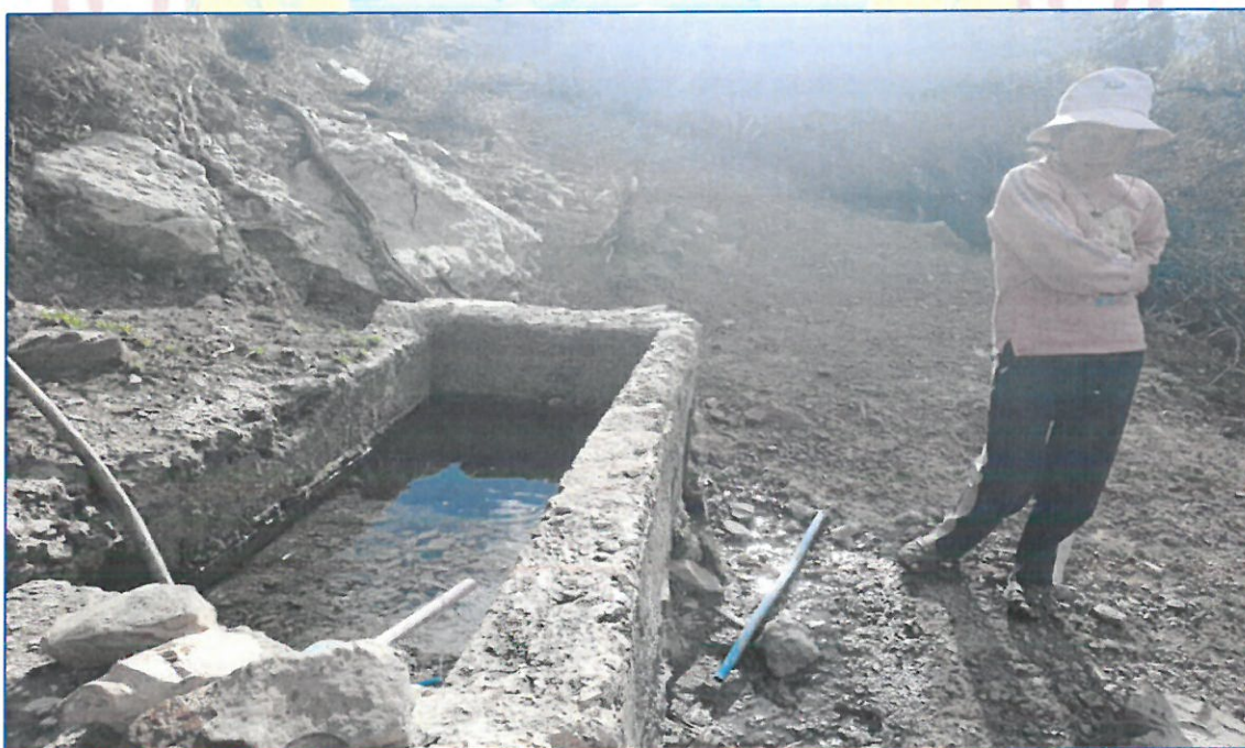
Imagen N° 2.35: Almacenamiento del agua expuesta a la interperie sistema II localidad de Ccochanccay.
