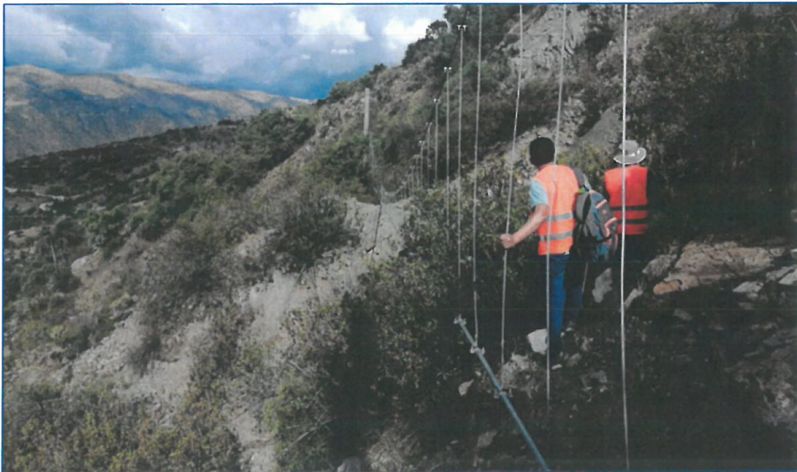
Imagen N° 2.23: Cruce Aéreo existente N° 02 L=60.00m sistema II localidad de Ccochancay.
