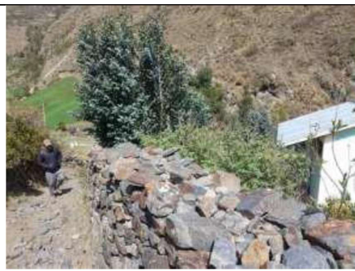
Foto N°02: Vista de un lado del cerco perimétrico construido con pirca de piedras, el cual no es seguro y puede causar accidentes en los niños.
