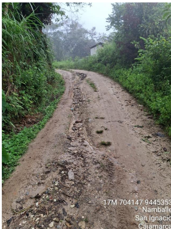
Fotografía N° 02 estado actual de la vía. La vía carece de recubrimiento asfaltado o tratamiento superficial, dejando el suelo expuesto.
