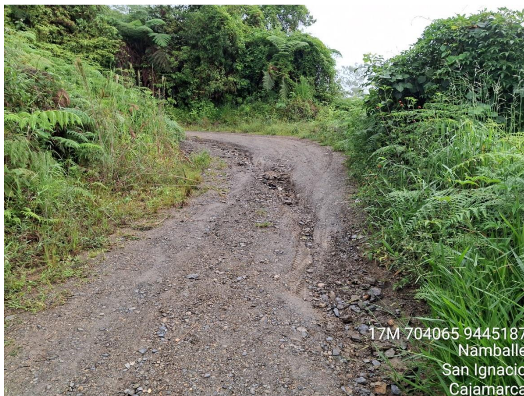
Fotografía N° 01 estado actual de la vía. Se observa la Superficie irregular: Hay surcos profundos y desgaste significativo en la capa de rodadura, probablemente causados por la erosión y el tránsito constante
