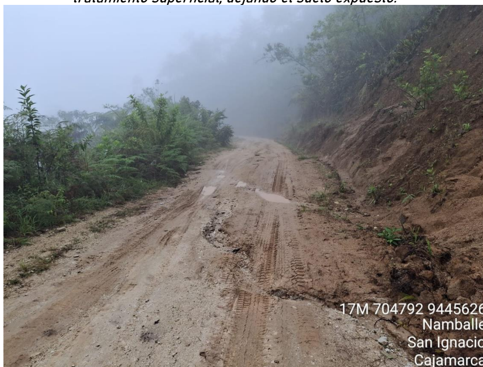
Fotografía N° 03 estado actual de la vía. Parece que no hay un sistema adecuado para el drenaje de agua, lo que puede provocar acumulación y deterioro adicional, especialmente en épocas de lluvias.
