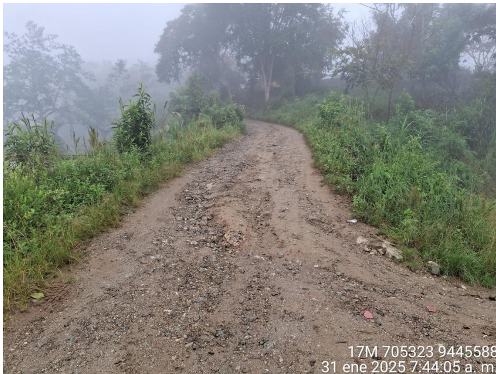
Fotografía N° 04 estado actual de la vía. Se observa la Superficie irregular: Hay surcos profundos y desgaste significativo en la capa de rodadura, probablemente causados por la erosión y el tránsito constante
