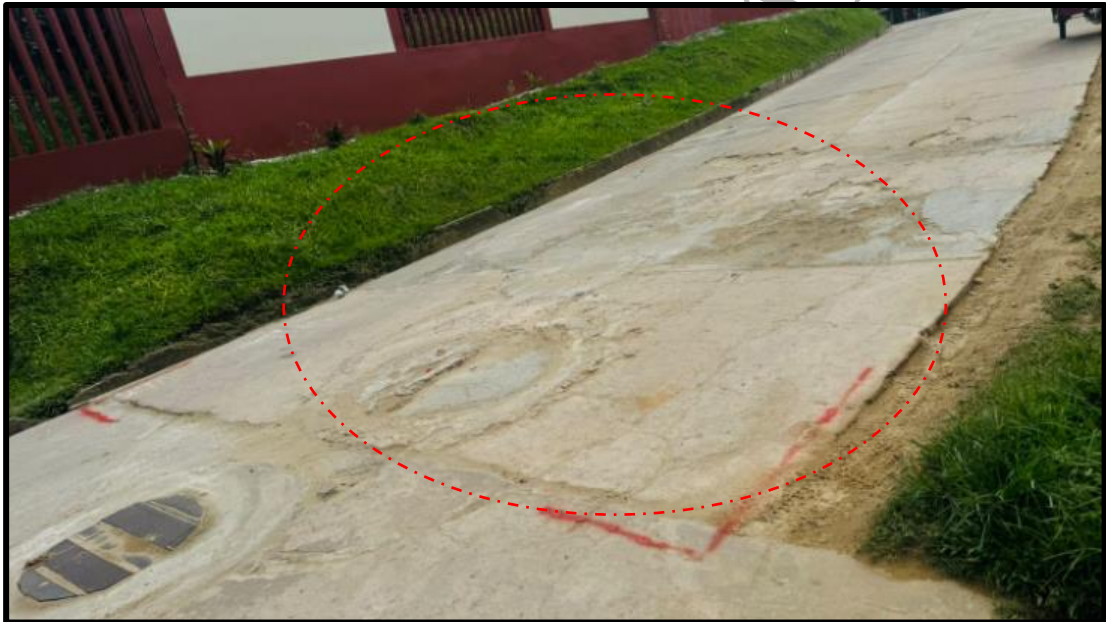
FOTO N°01: Se aprecia la vía colapsado, requiere reparación.
