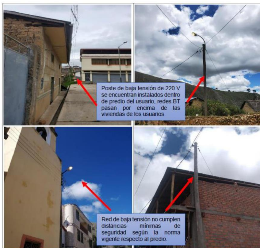
Fig. N° 07 Redes de media y baja tensión incumplimiento distancias mínimas de seguridad
