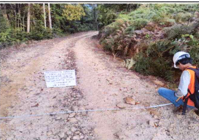
Foto 71: Se observa la topografía del terreno accidentado con una pendiente de 6% en el Km. 17+500
