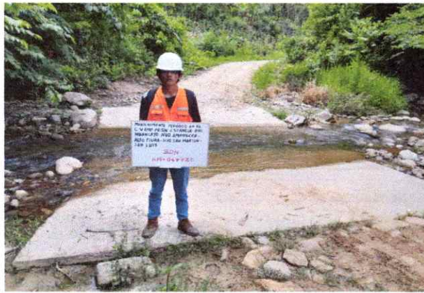
Foto 07: Baden de concreto ubicado en el km 06+720, se encuentra en buen estado de conservación.
