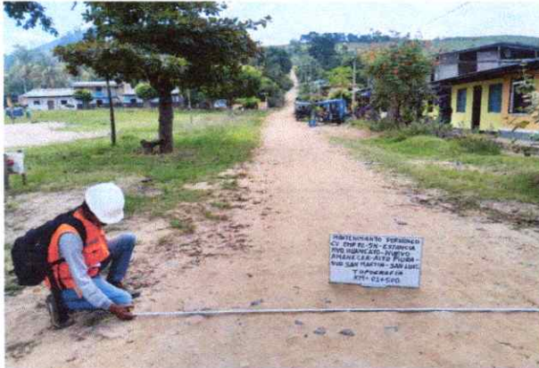
Foto 07: Se observa la topografía del terreno ondulado con una pendiente de 5% en el Km.1+500
