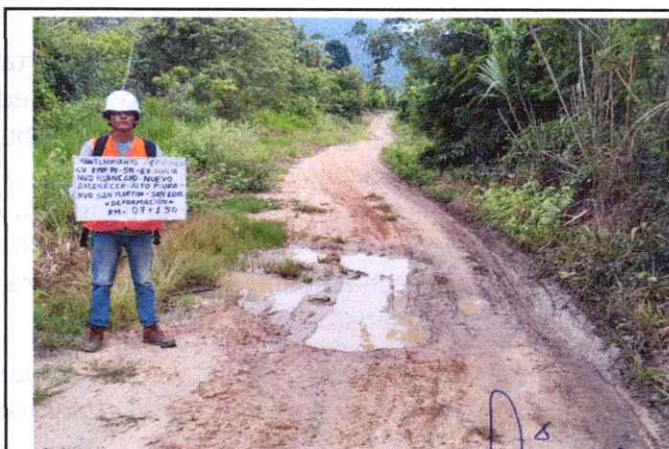
Foto 16: Se observa baches y ahuellamiento de la Plataforma en el Km. 7+150
