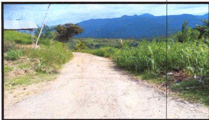
Fig. 01. Se observa el inicio del camino, empalme con la vía departamental PE-5N, donde la topografía del terreno es semiplano, la pendiente es de 3%
