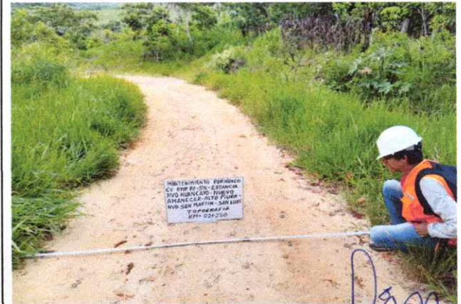
Foto 10: Se observa la topografía del terreno ondulado con una pendiente de 6% en el Km. 02+250
