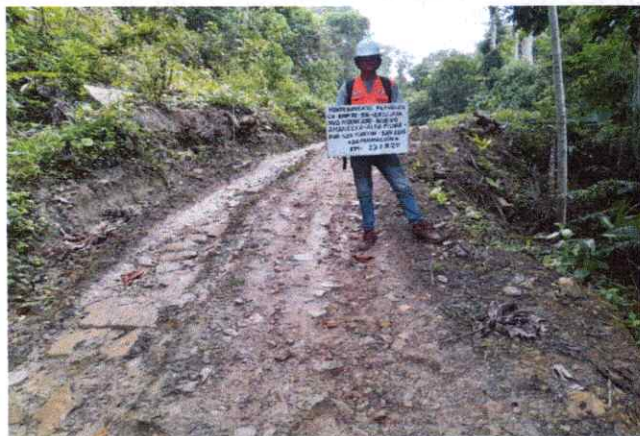
Foto 37: Se observa ahuelamiento de la Plataforma en el Km.13+820
