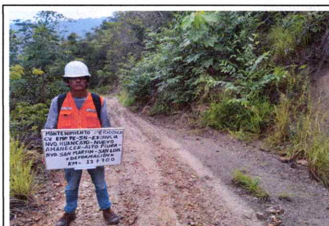
Foto 33: Se observa ahuellamiento de la Plataforma en el Km. 12+700
