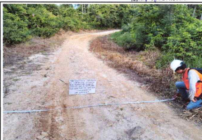
Foto 72: Se observa la topografía del terreno accidentado con una pendiente de 8% en el Km. 17+750
