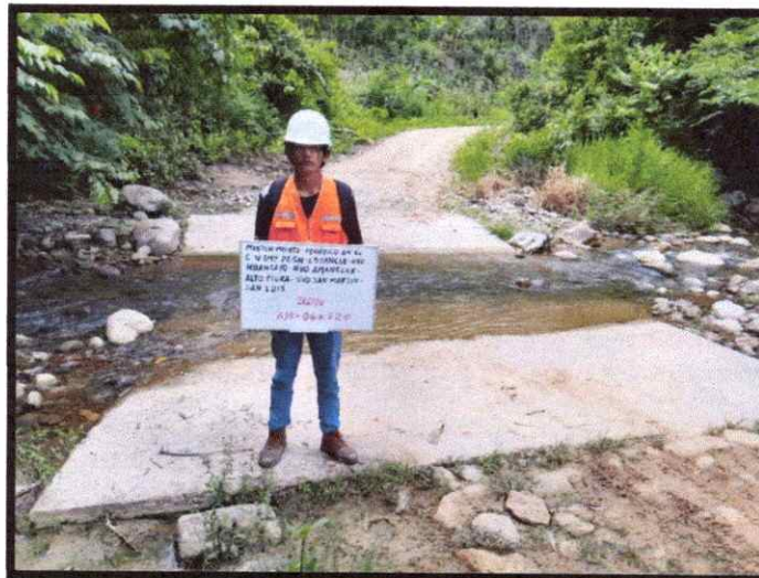
Fig. 07. Se puede ver en la imagen badén de concreto armado de las cuales se ubica en el Km. 6+720 del camino vecinal.
