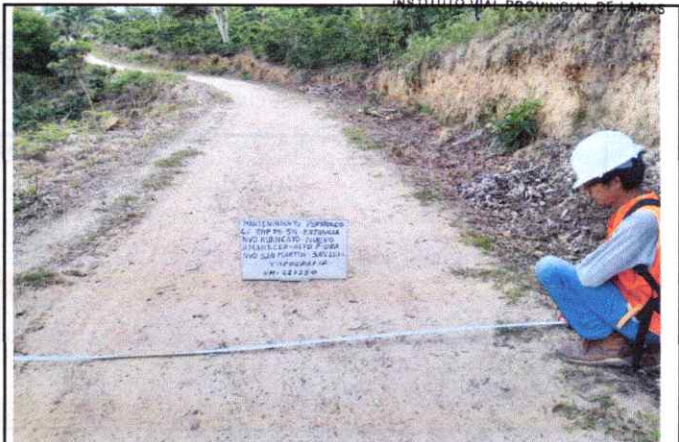
Foto 90: Se observa la topografía del terreno accidentado con una pendiente de 8% en el Km. 22+250
