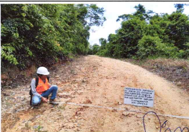
Foto 40: Se observa la topografía del terreno ondulado con una pendiente de 9% en el Km. 09+750 Ing. Marco Tuko Reategui Acuña JEFE DE OPERACIONES CIP.: N° 220015 INSTITUTO VIAL PROVINCIAL DE LAMAS
