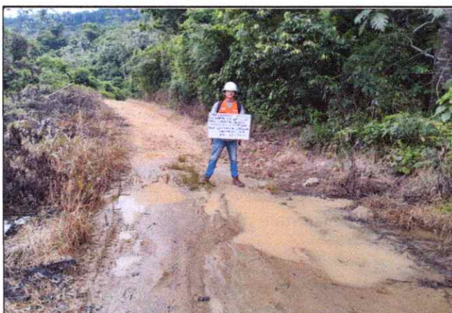
Foto 29: Se observa baches y ahuellamiento de la Plataforma en el Km. 11+900
