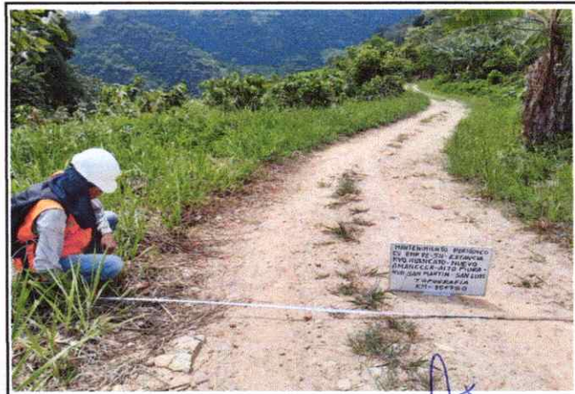
Foto 64: Se observa la topografía del terreno ondulado con una pendiente de 6% en el Km. 15+750
