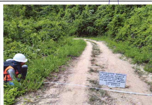
Foto 60: Se observa la topografía del terreno accidentado con una pendiente de 8% en el Km. 14+750
