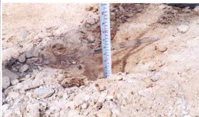
Foto 116: Espesor de la plataforma 0.07 mts. En el Km.28+750
