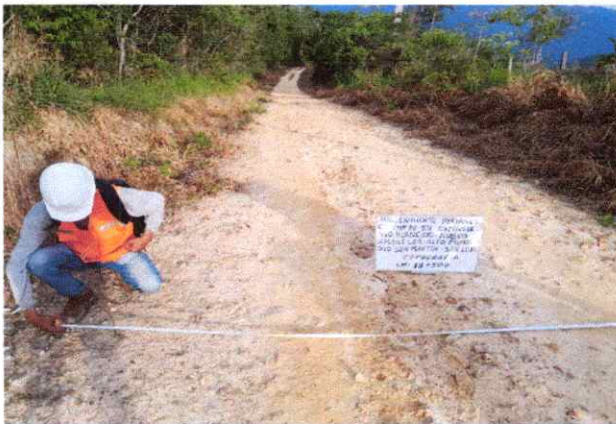
Foto 75: Se observa la topografía del terreno ondulado con una pendiente de 6% en el Km. 18+500
