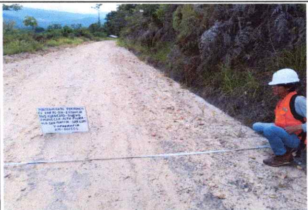
Foto 03: Se observa la topografía del terreno Ondulado con una pendiente de 4% en el Km. 0+500
