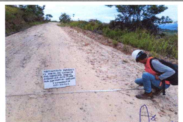
Foto 04: Se observa la topografía del terreno ondulado con una pendiente de 4% en el Km. 0+750
