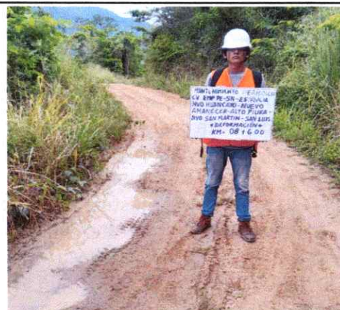
Foto 20: Se observa ahuellamiento de la Plataforma en el Km. 8+600
