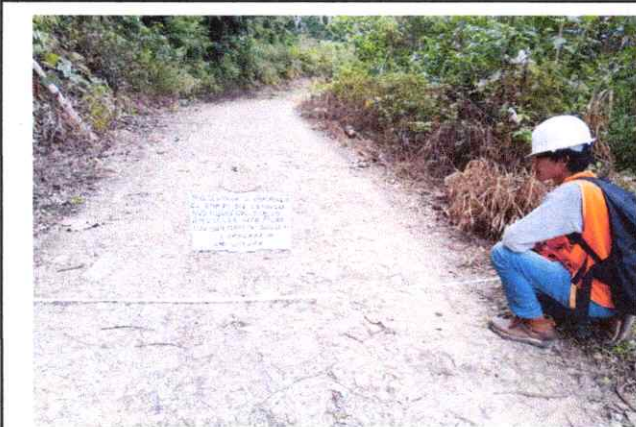
Foto 83: Se observa la topografía del terreno accidentado con una pendiente de 6% en el Km. 20+500
