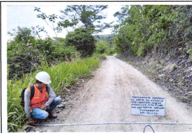
Foto 22: Se observa la topografía del terreno ondulado con una pendiente de 4% en el Km. 05+250
