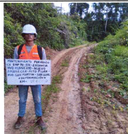
Foto 42: Se observa ahuellamiento de la Plataforma en el Km.15+200
