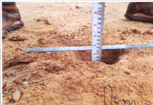
Foto 82: Espesor de la plataforma 0.10 mts. En el Km. 20+250
