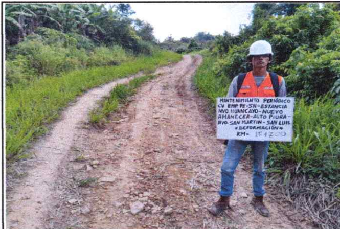
Foto 44: Se observa ahuellamiento y erosión de la Plataforma en el Km. 15+700
