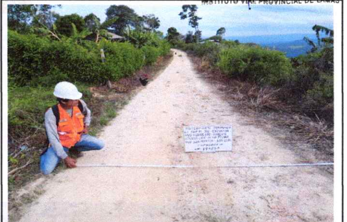
Foto 78: Se observa la topografía del terreno accidentado con una pendiente de 8% en el Km. 19+250
