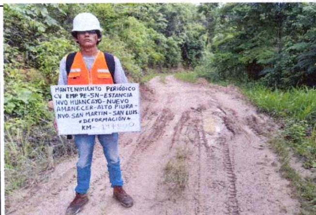
Foto 41: Se observa ahuellamiento de la Plataforma en el Km.14+800
