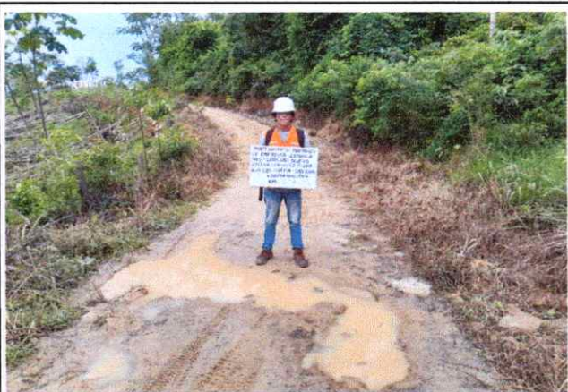
Foto 54: Se observa baches de la Plataforma en el Km.20+120
