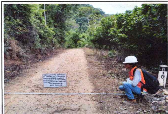
Foto 41: Se observa la topografía del terreno accidentado con una pendiente de 9% en el Km. 10+000
