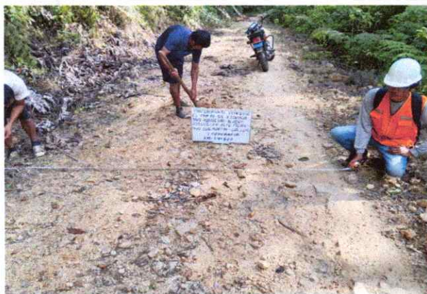
Foto 99: Se observa la topografía del terreno ondulado con una pendiente de 6% en el Km. 24+500
