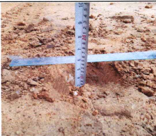
Foto 77: Espesor de la plataforma 0.10 mts. En el Km. 19+000
