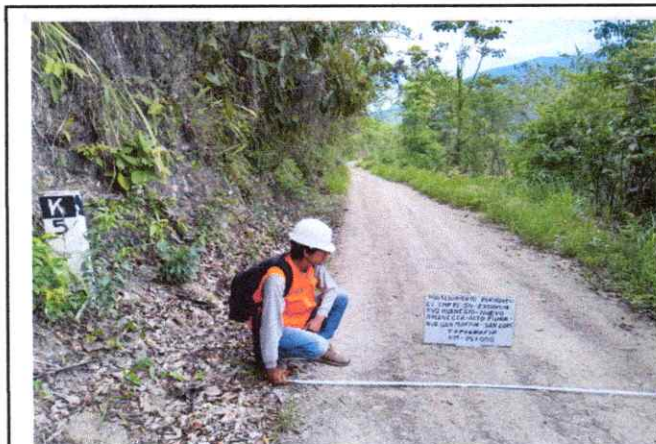
Foto 21: Se observa la topografía del terreno ondulado con una pendiente de 6% en el Km. 05+000
