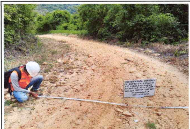
Foto 39: Se observa la topografía del terreno ondulado con una pendiente de 8% en el Km. 09+500
