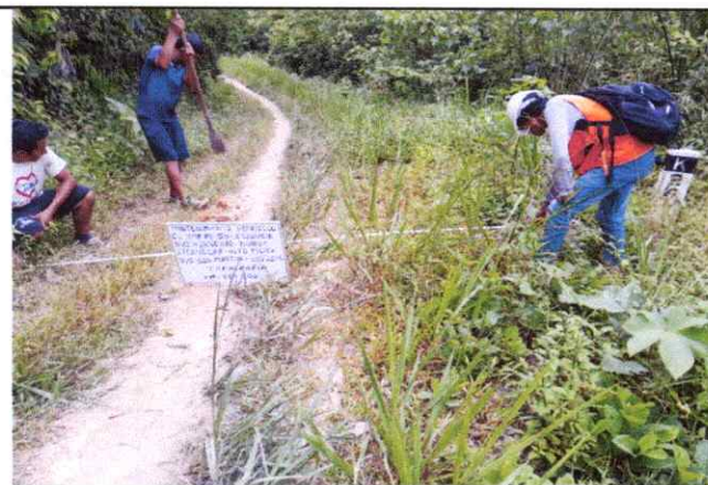
Foto 105: Se observa la topografía del terreno ondulado con una pendiente de 6% en el Km. 26+000
