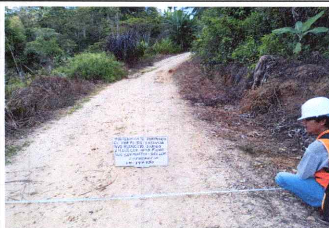
Foto 80: Se observa la topografía del terreno ondulado con una pendiente de 9% en el Km. 19+750
