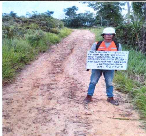
Foto 02: Se observa erosión en la Plataforma en el Km. 1+900
