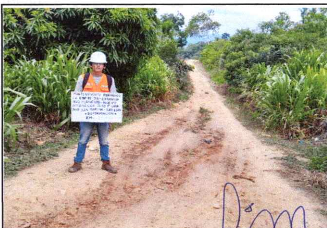
Foto 52: Se observa erosión de la Plataforma en el Km. 19+600
