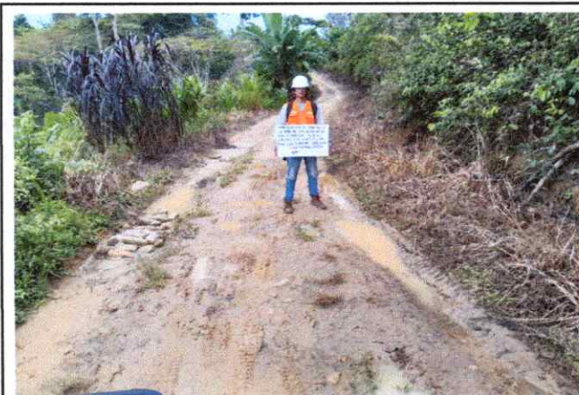
Foto 53: Se observa ahuellamiento de la Plataforma en el Km.19+950
