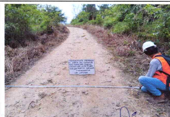
Foto 82: Se observa la topografía del terreno ondulado con una pendiente de 5% en el Km. 20+250
