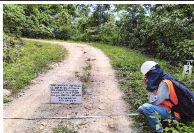
Foto 57: Se observa la topografía del terreno ondulado con una pendiente de 6% en el Km. 14+000
