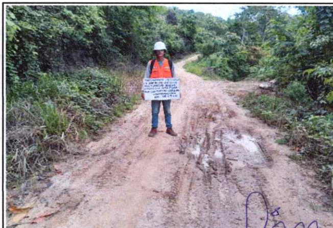
Foto 22: Se observa ahuellamiento de la Plataforma en el Km. 08+900
