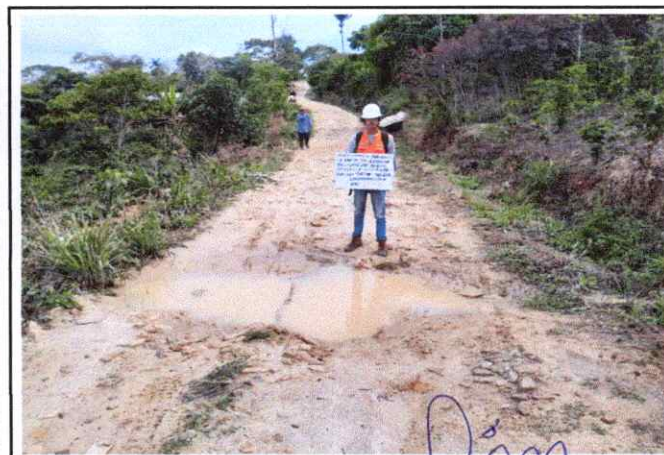
Foto 58: Se observa baches de la Plataforma en el Km. 21+900
