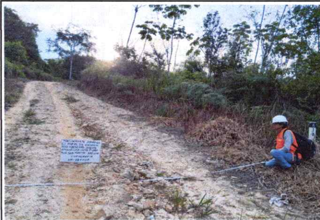
Foto 73: Se observa la topografía del terreno ondulado con una pendiente de 4% en el Km. 18+000
