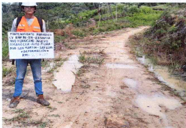
Foto 61: Se observa baches de la Plataforma en el Km.23+600
