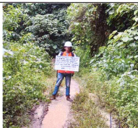
Foto 64: Se observa ahuellamiento de la Plataforma en el Km. 24+650
