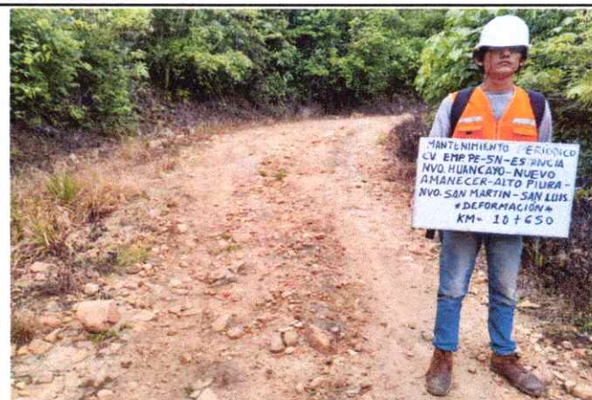
Foto 26: Se observa ahuellamiento de la Plataforma en el Km. 10+650
