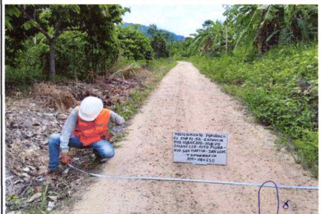
Foto 34: Se observa la topografía del terreno ondulado con una pendiente de 8% en el Km. 08+250
