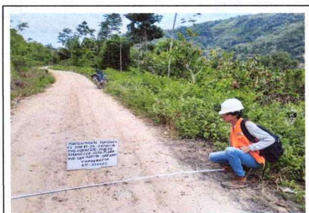
Foto 29: Se observa la topografía del terreno ondulado con una pendiente de 6% en el Km. 07+000
