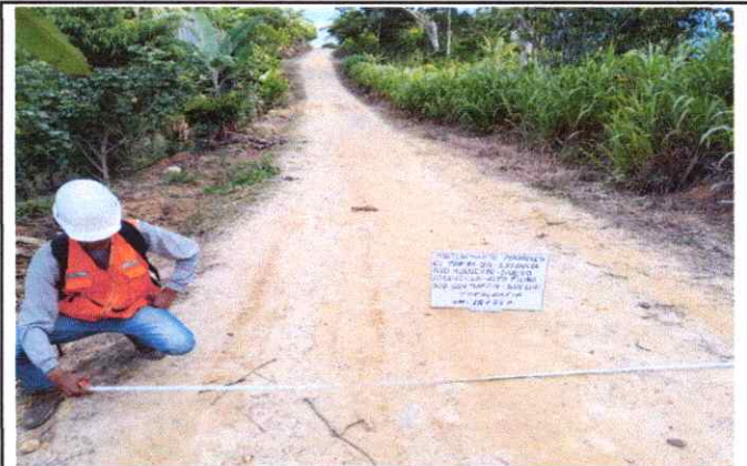
Foto 76: Se observa la topografía del terreno ondulado con una pendiente de 6% en el Km. 18+750
