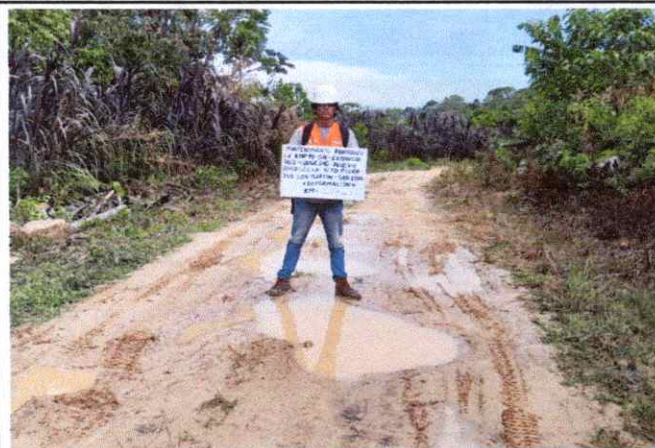
Foto 55: Se observa ahuellamiento y baches de la Plataforma en el Km. 20+650
