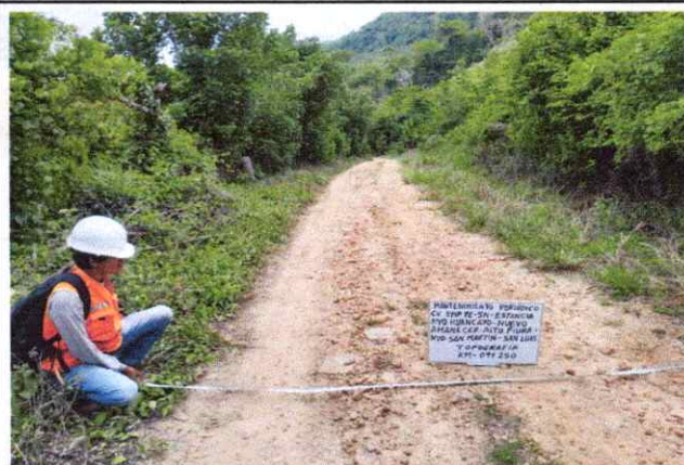
Foto 38: Se observa la topografía del terreno ondulado con una pendiente de 9% en el Km. 09+250
