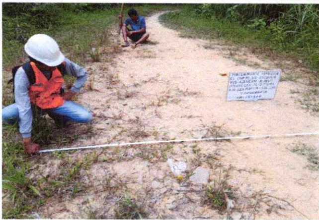
Foto 103: Se observa la topografía del terreno ondulado con una pendiente de 4% en el Km. 25+500
