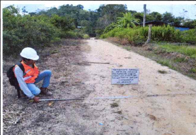
Foto 79: Se observa la topografía del terreno ondulado con una pendiente de 4% en el Km. 19+500
