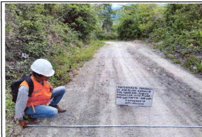
Foto 19: Se observa la topografía del terreno accidentado con una pendiente de 6% en el Km. 04+500
