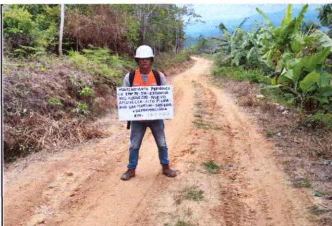
Foto 51: Se observa ahuellamiento de la Plataforma en el Km. 18+700
