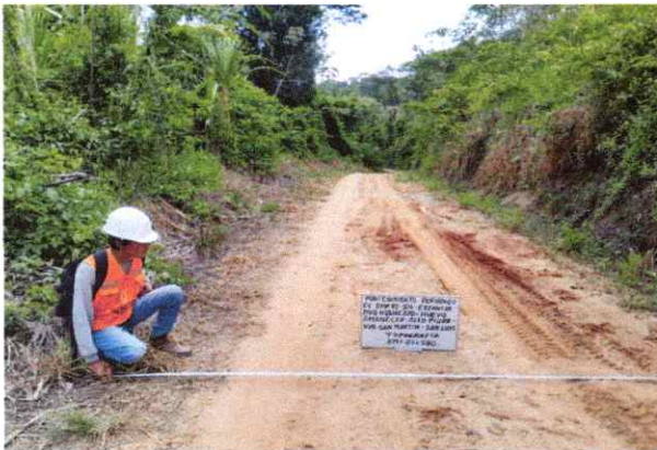
Foto 31: Se observa la topografía del terreno ondulado con una pendiente de 6% en el Km. 07+500
