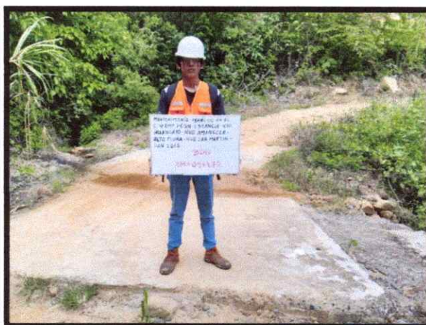
Fig. 11. Se puede observar un badén de concreto armado en el camino vecinal y está ubicada en el Km 9+170.
