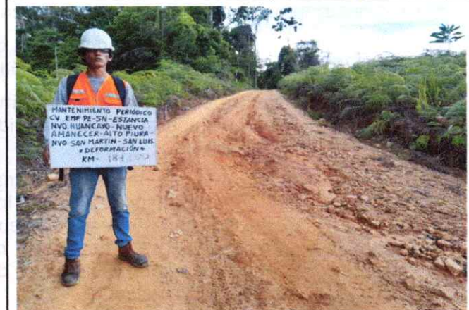
Foto 48: Se observa erosión de la Plataforma en el Km.18+100
