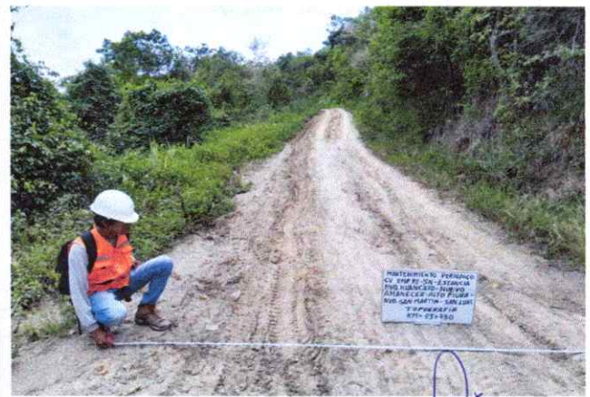
Foto 16: Se observa la topografía del terreno ondulado con una pendiente de 8% en el Km. 03+750
