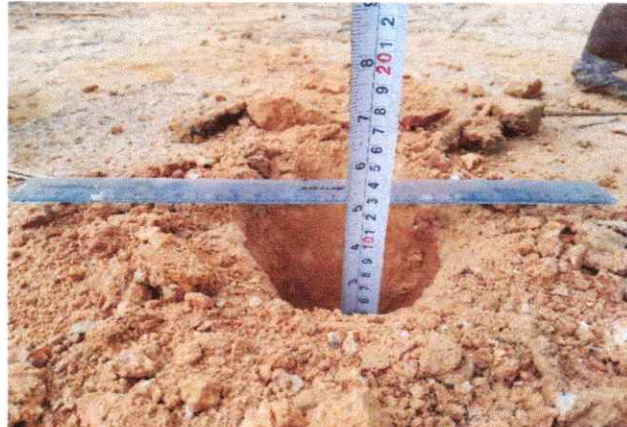
Foto 44: Espesor de la plataforma 0.10 mts. En el Km. 10+750
