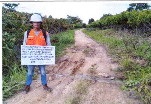
Foto 45: Se observa ahuellamiento de la Plataforma en el Km. 16+300
