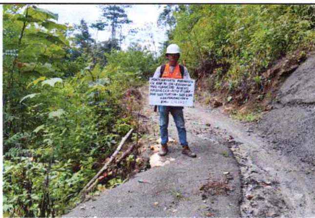
Foto 63: Se observa erosión y ahuellamientos de la Plataforma en el Km. 24+100
