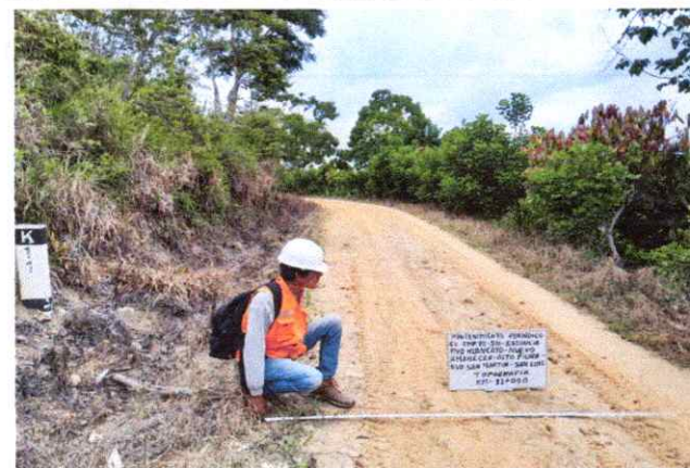
Foto 45: Se observa la topografía del terreno ondulado con una pendiente de 7% en el Km. 11+000
