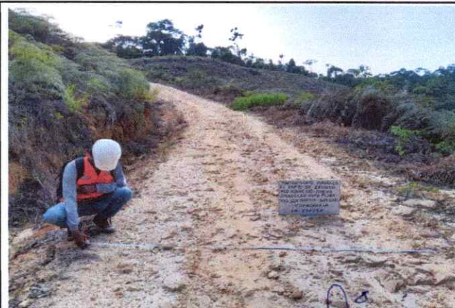
Foto 70: Se observa la topografía del terreno ondulado con una pendiente de 6% en el Km. 17+250
