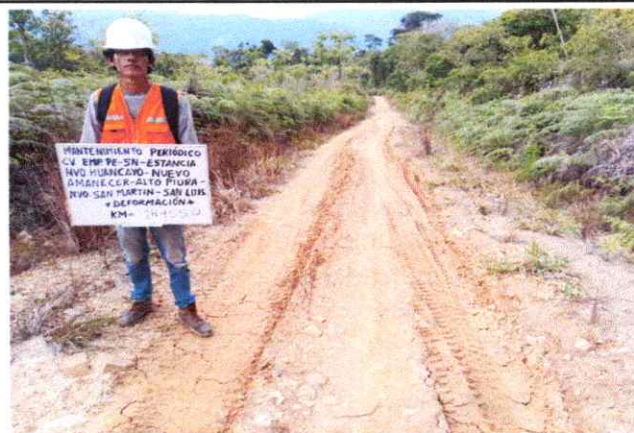
Foto 50: Se observa ahuellamiento de la Plataforma en el Km. 18+550
