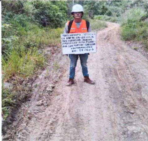
Foto 07: Se observa ahuellamiento de la Plataforma en el Km.3+600
