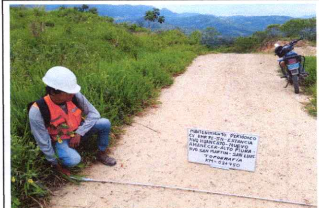
Foto 12: Se observa la topografía del terreno ondulado con una pendiente de 5% en el Km. 02+750
