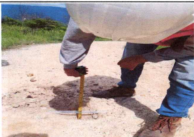
Foto 57: Espesor de la plataforma 0.10 mts. En el Km. 13+500.
