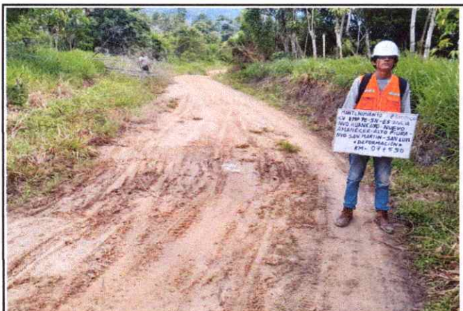
Foto 17: Se observa, ahuellamiento de la Plataforma en el Km. 7+550
