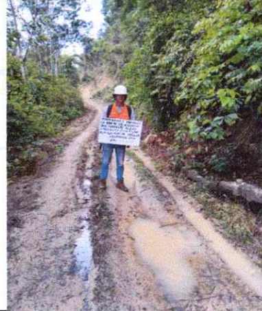
Foto 62: Se observa erosión y ahuellamiento de la Plataforma en el Km. 23+900
