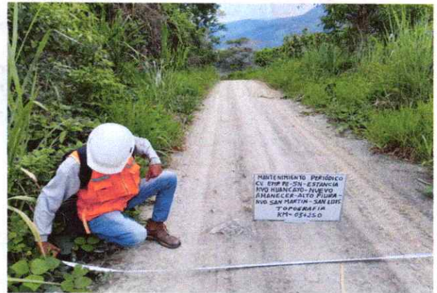
Foto 14: Se observa la topografía del terreno Ondulado con una pendiente de 6% en el Km. 03+250
