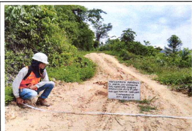
Foto 59: Se observa la topografía del terreno accidentado con una pendiente de 6% en el Km. 14+500
