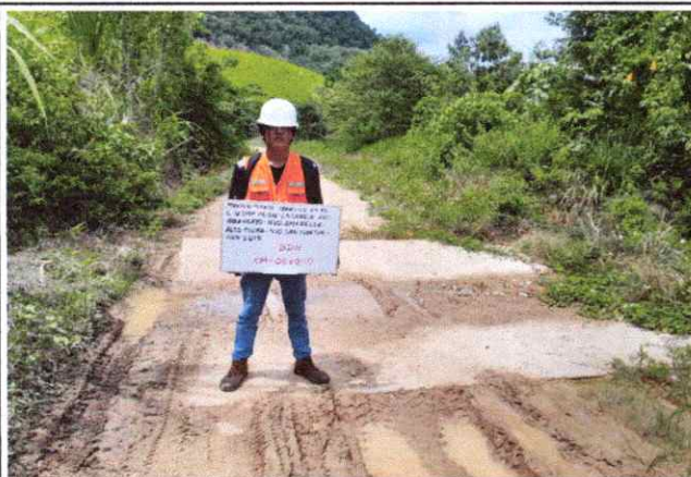
Foto 09: Baden de concreto ubicado en el km 08+040, se encuentra en buen estado de conservación.
