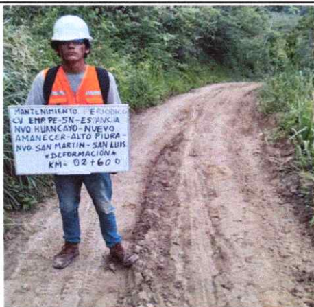
Foto 05: Se observa ahuellamiento y erosión de la Plataforma en el Km. 2+600
