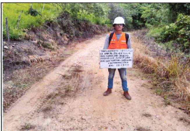
Foto 27: Se observa ahuellamiento de la Plataforma en el Km. 10+800
