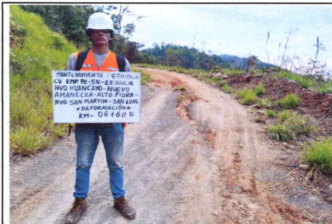
Foto 14: Se observa ahuellamiento de la Plataforma en el Km. 6+600
