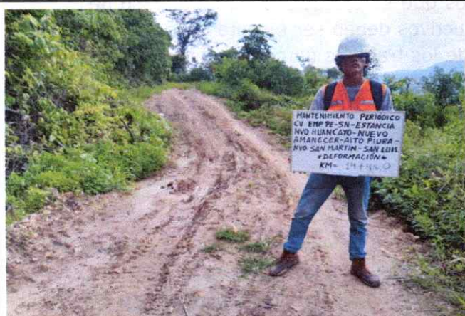
Foto 39: Se observa ahuellamiento de la Plataforma en el Km. 14+450
