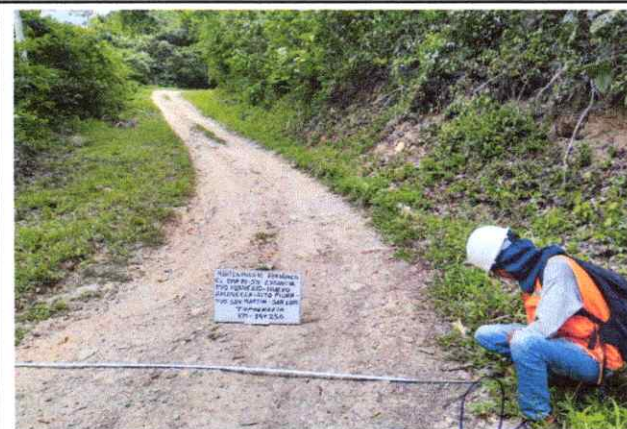
Foto 58: Se observa la topografía del terreno ondulado con una pendiente de 6% en el Km. 14+250
