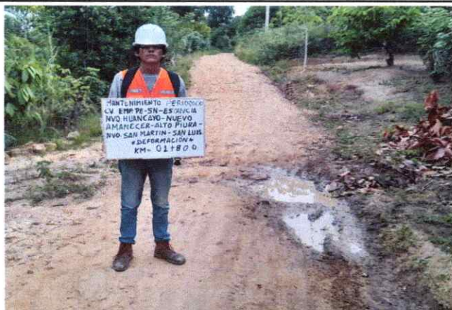
Foto 01: Se observa ahuellamiento en la Plataforma en el Km.1+800
