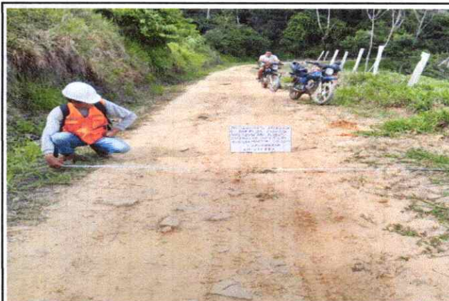
Foto 112: Se observa la topografía del terreno ondulado con una pendiente de 6% en el Km. 27+750
