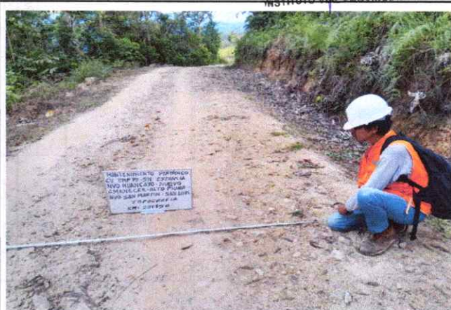
Foto 84: Se observa la topografía del terreno accidentado con una pendiente de 6% en el Km. 20+750
