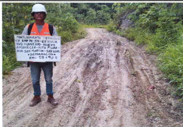
Foto 08: Se observa ahuellamiento y erosión en la Plataforma Km. 3+900
