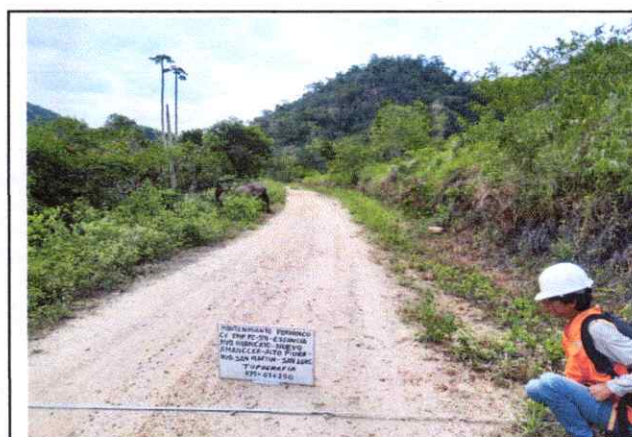
Foto 30: Se observa la topografía del terreno ondulado con una pendiente de 4% en el Km. 07+250
