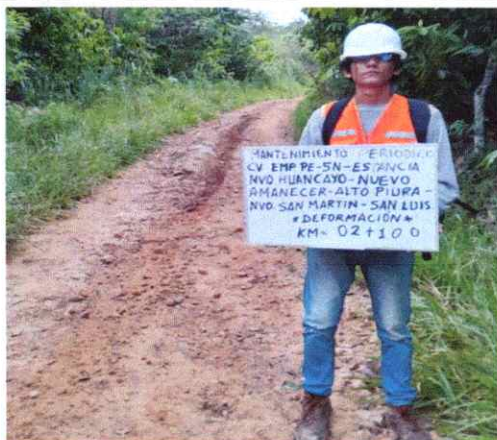
Foto 03: Se observa erosión en la Plataforma en el Km. 2+100
