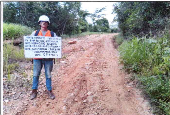
Foto 13: Se observa erosión de la Plataforma en el Km. 6+400
