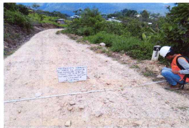
Foto 89: Se observa la topografía del terreno accidentado con una pendiente de 6% en el Km. 22+000
