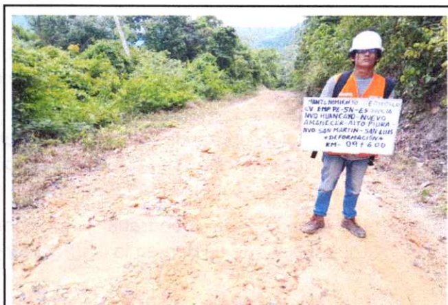
Foto 24: Se observa ahuellamiento de la Plataforma en el Km. 09+600
