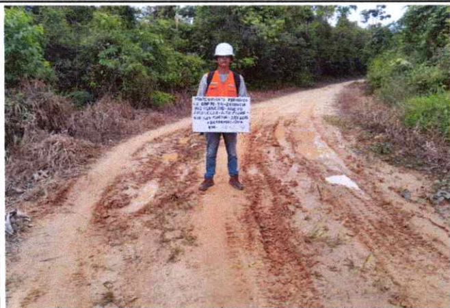
Foto 49: Se observa ahuellamiento de la Plataforma en el Km.18+200
