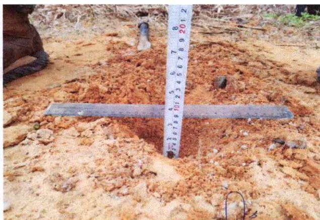
Foto 28: Espesor de la plataforma 0.10 mts. EJE En el Km. 6+750
