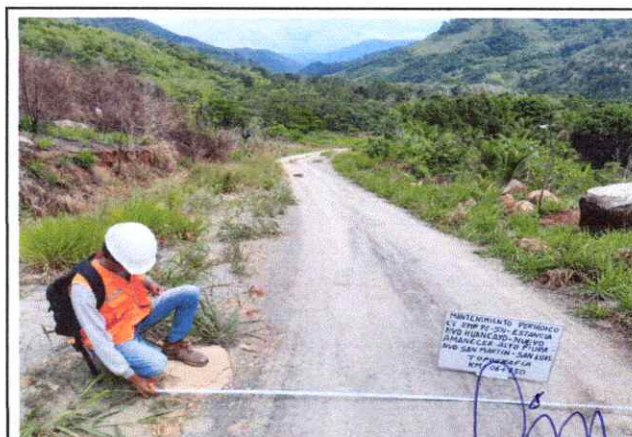
Foto 28: Se observa la topografía del terreno accidentado ... con una pendiente de 6% en el Km. 06+750 Ing. Marco Tulio Reátegui Acedo JEFE DE OPERACIONES CIP.: N° 220015 INSTITUTO VIAL PROVINCIAL DE LAMAS
