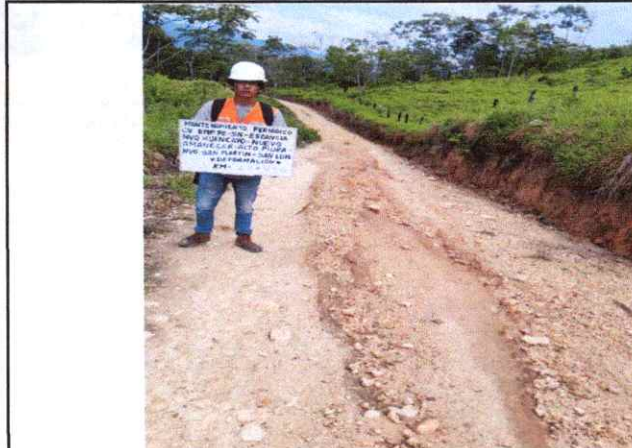
Foto 56: Se observa erosión de la Plataforma en el Km. 20+850
