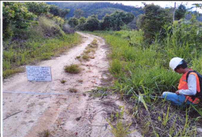
Foto 68: Se observa la topografía del terreno ondulado con una pendiente de 3% en el Km. 16+750
