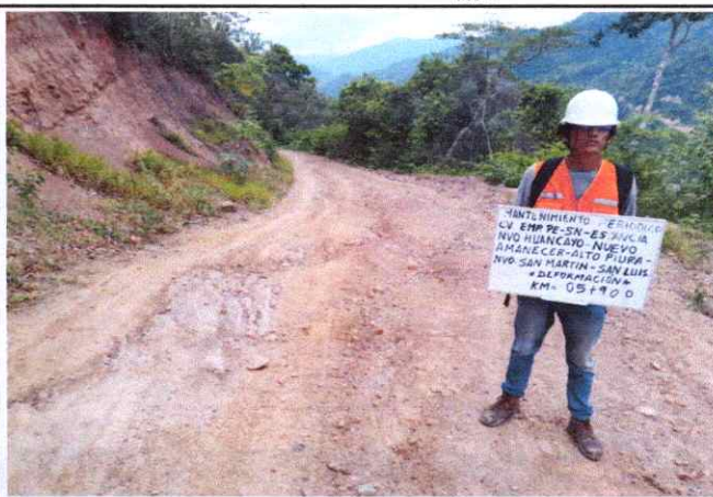
Foto 12: Se observa erosión de la Plataforma en el Km.5+900
