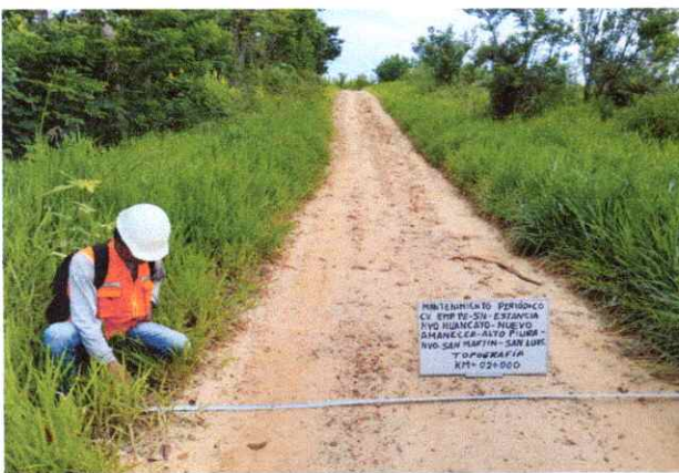
Foto 09: Se observa la topografía del terreno ondulado con una pendiente de 6% en el Km. 02+000
