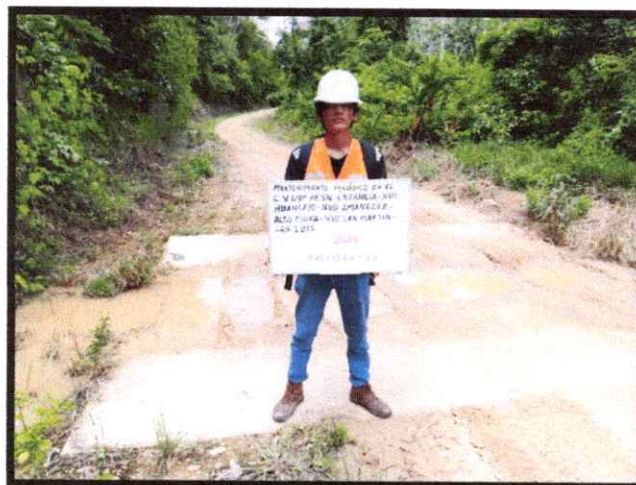
Fig. 08. En la imagen se observa badén de concreto armado ubicado en el Km. 7+470 del camino vecinal.
