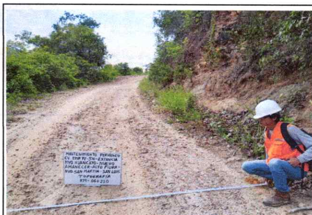
Foto 26: Se observa la topografía del terreno accidentado con una pendiente de 6% en el Km. 06+250
