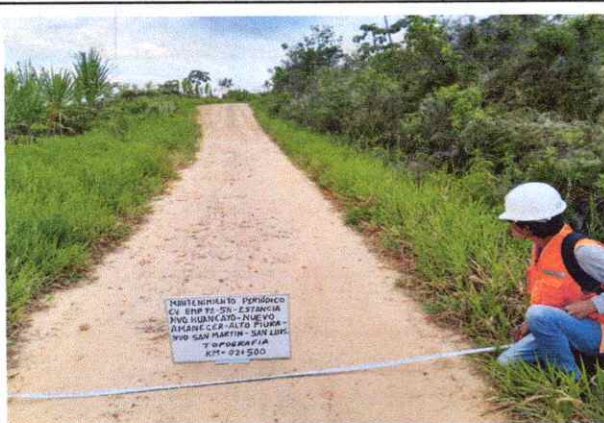
Foto 11: Se observa la topografía del terreno ondulado con una pendiente de 4% en el Km. 02+500
