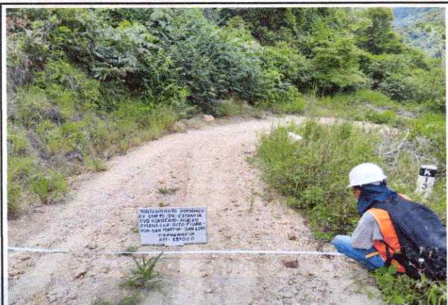
Foto 53: Se observa la topografía del terreno accidentado con una pendiente de 6% en el Km. 13+000
