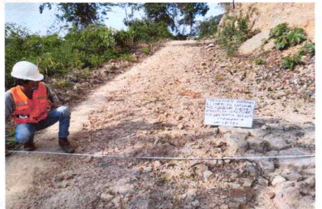
Foto 96: Se observa la topografía del terreno accidentado con una pendiente de 8% en el Km. 23+750
