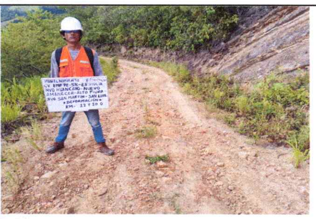
Foto 30: Se observa ahuellamiento en la Plataforma en el Km. 12+100
