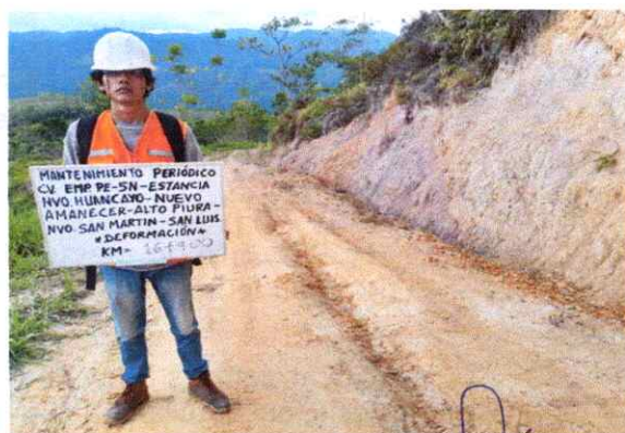
Foto 46: Se observa ahuellamiento de la Plataforma en el Km. 16+900
