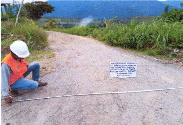
Foto 01: Se observa la topografía del terreno accidentado con una pendiente de 3% en el Km.0+000
