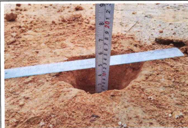
Foto 41: Espesor de la plataforma 0.10 mts. En el Km. 10+000
