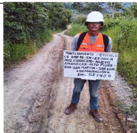
Foto 04: Se observa erosión y ahuellamiento en la Plataforma en el Km. 2+400
