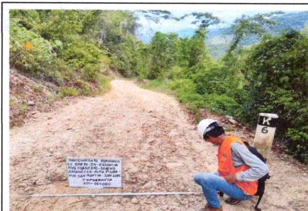
Foto 25: Se observa la topografía del terreno ondulado con una pendiente de 4% en el Km. 06+000
