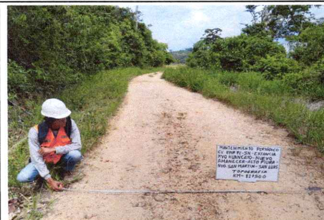
Foto 51: Se observa la topografía del terreno ondulado con una pendiente de 6% en el Km. 12+500
