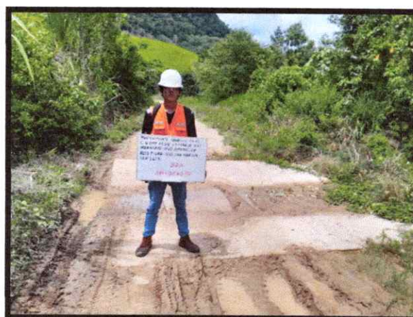
Fig. 09. En la imagen se observa badén de concreto armado ubicado en el Km. 8+040 del camino vecinal.
