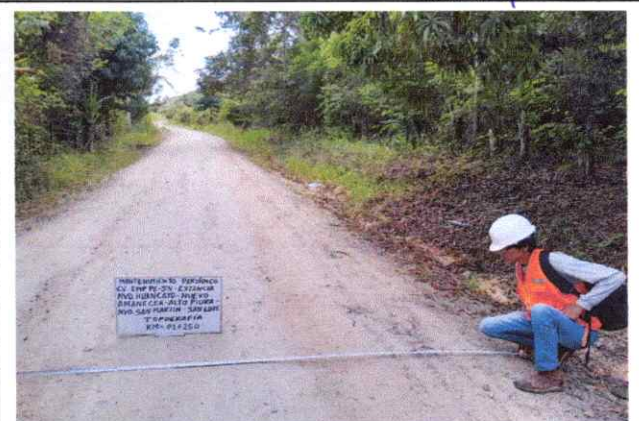
Foto 06: Se observa la topografía del terreno ondulado con una pendiente de 6% en el Km. 1+250
