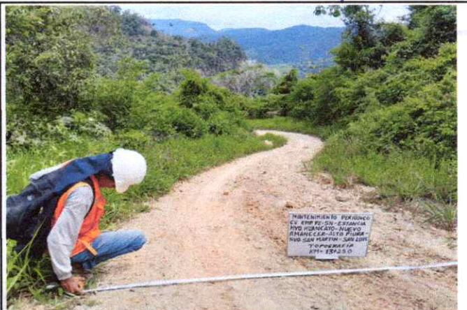
Foto 54: Se observa la topografía del terreno accidentado con una pendiente de 6% en el Km. 13+250
