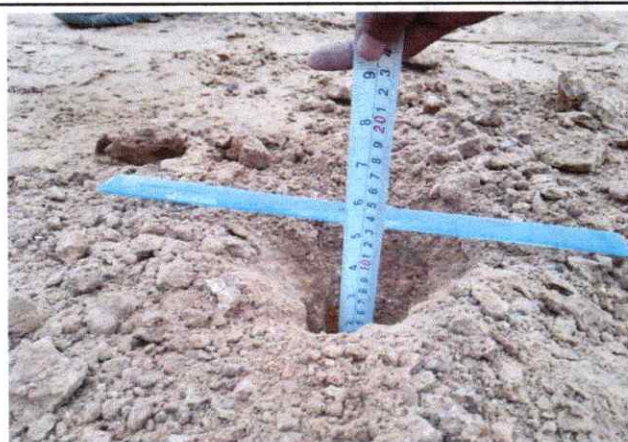
Foto 21: Espesor de la plataforma 0.10 mts. LD En el Km. 5+000
