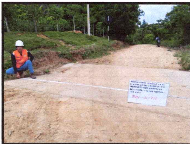
Fig. 01. Badén de concreto armado ubicado en la progresiva Km 01+700. Estado regular, operatividad semilimpio.
