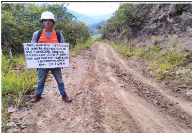
Foto 31: Se observa ahuellamiento de la Plataforma en el Km.12+280
