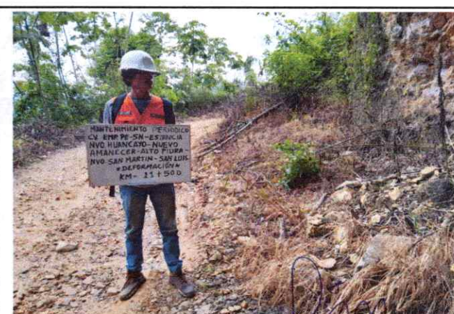
Foto 28: Se observa ahuellamiento de la Plataforma en el Km. 11+500
