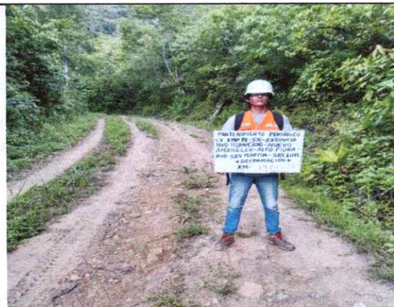
Foto 40: Se observa ahuellamiento de la Plataforma en el Km. 14+700
