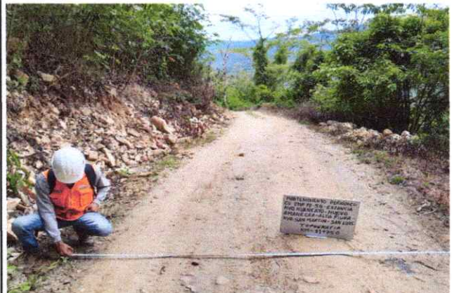
Foto 48: Se observa la topografía del terreno accidentado con una pendiente de 8% en el Km. 11+750
