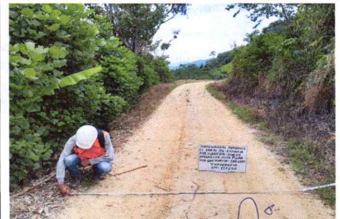
Foto 46: Se observa la topografía del terreno ondulado con una pendiente de 9% en el Km. 11+250
