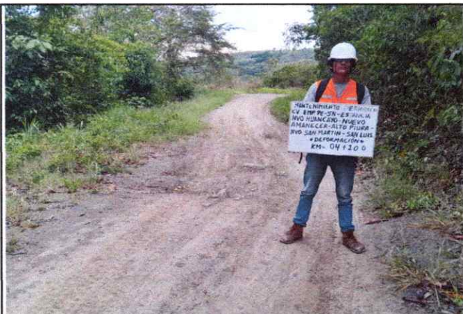
Foto 09: Se observa ahuellamiento de la Plataforma en el Km. 4+100
