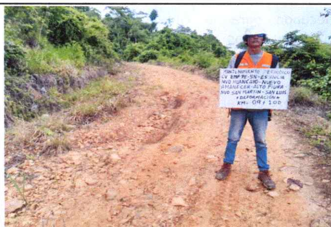
Foto 23: Se observa ahuellamiento de la Plataforma en el Km. 09+100
