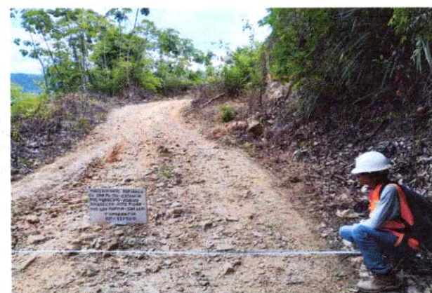
Foto 47: Se observa la topografía del terreno accidentado con una pendiente de 8% en el Km. 11+500
