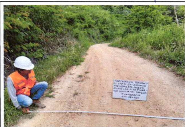
Foto 36: Se observa la topografía del terreno accidentado con una pendiente de 8% en el Km. 08+750
