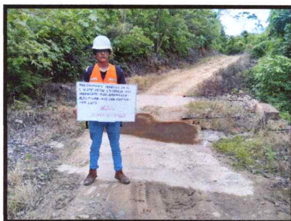
Fig. 12. Badén de concreto armado en regular estado y que se encuentra ubicado en el Km 10+460.
