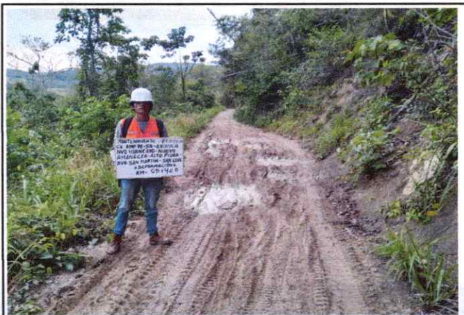
Foto 11: Se observa ahuellamiento y baches de la Plataforma en el Km.5+400
