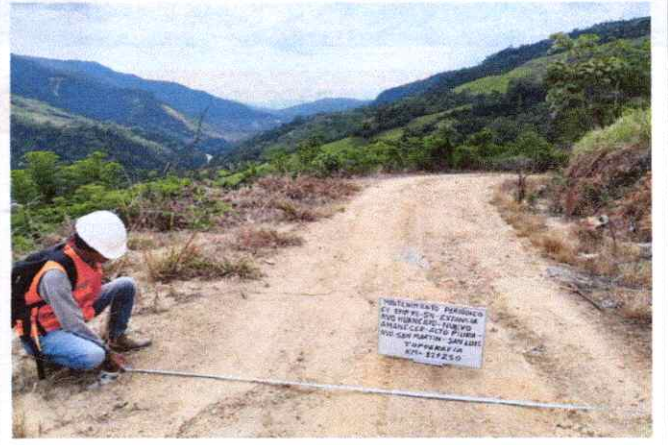
Foto 50: Se observa la topografía del terreno ondulado con una pendiente de 9% en el Km. 12+250
