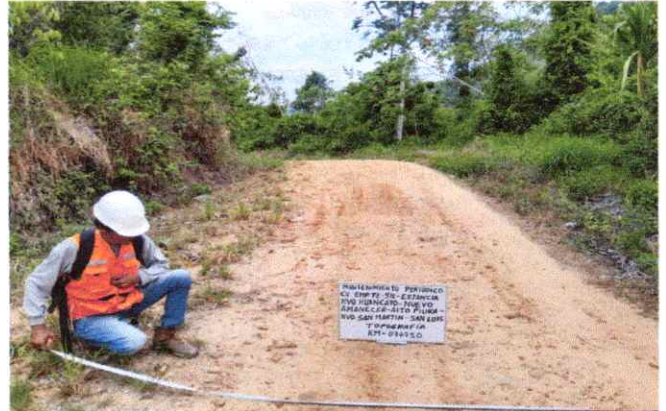
Foto 32: Se observa la topografía del terreno ondulado con una pendiente de 9% en el Km. 07+750
