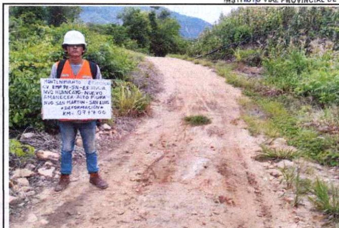
Foto 18: Se observa ahuellamiento de la Plataforma en el Km. 07+700
