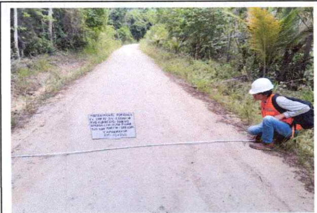
Foto 05: Se observa la topografía del terreno accidentado con una pendiente de 6% en el Km.1+000
