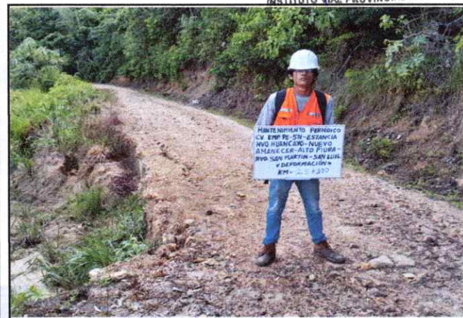
Foto 60: Se observa erosión de la Plataforma en el Km. 23+300
