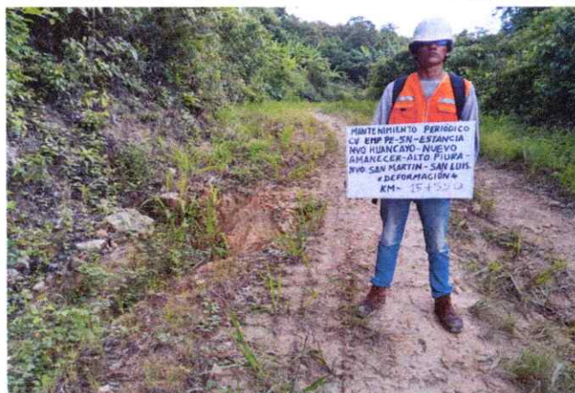
Foto 43: Se observa erosión de la Plataforma en el Km.15+550
