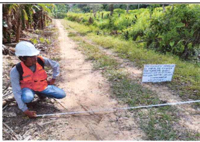
Foto 110: Se observa la topografía del terreno ondulado con una pendiente de 3% en el Km. 27+250
