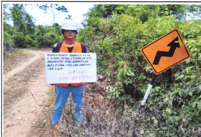
Foto 19: Señal preventiva 10+490, se observa que tiene una inclinación, pero en un estado regular de conservación.
