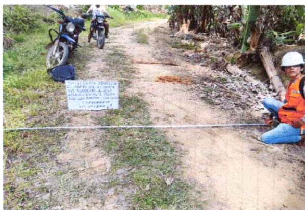
Foto 111: Se observa la topografía del terreno ondulado con una pendiente de 6% en el Km. 27+500
