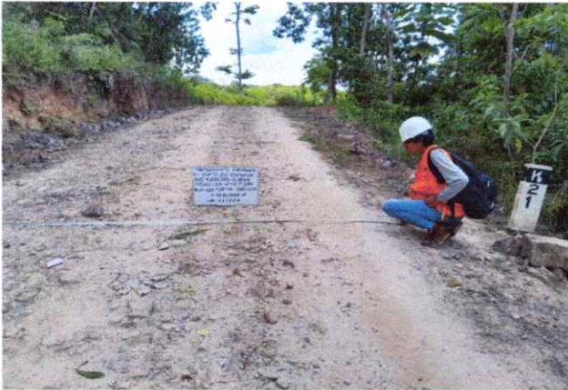
Foto 85: Se observa la topografía del terreno ondulado con una pendiente de 4% en el Km. 21+000
