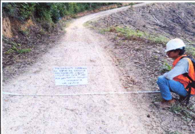
Foto 91: Se observa la topografía del terreno ondulado con una pendiente de 4% en el Km. 22+500
