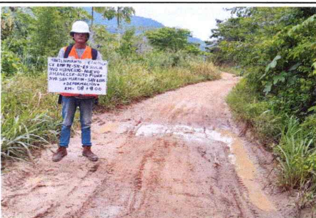
Foto 21: Se observa ahuellamiento de la Plataforma en el Km. 08+800
