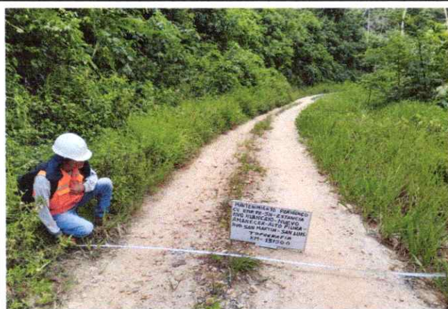
Foto 55: Se observa la topografía del terreno ondulado con una pendiente de 4% en el Km. 13+500
