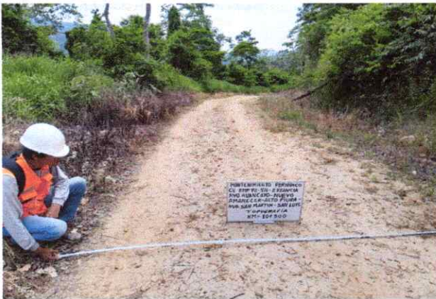
Foto 43: Se observa la topografía del terreno ondulado con una pendiente de 6% en el Km. 10+500
