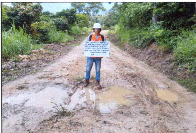
Foto 57: Se observa baches de la Plataforma en el Km. 21+600
