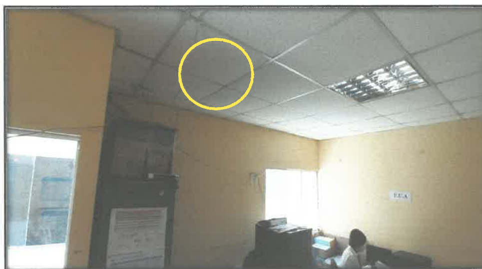
49. Cables de DATA sostenidos en el falso cielo raso causando deterioro en la estructura.
