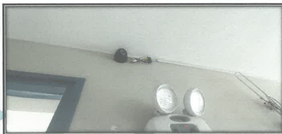
FOTO N°29: Cámara de vigilancia mal ubicada, el cual no cubre todo el enfoque de visualización en el área colocada.
