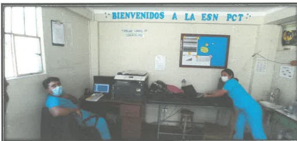
FOTO N°02: La falta de puntos de data para el trabajo en el área de PCT, tiene una red existente pero la cantidad de equipos que funcionan en el ambiente requiere aumentar.
