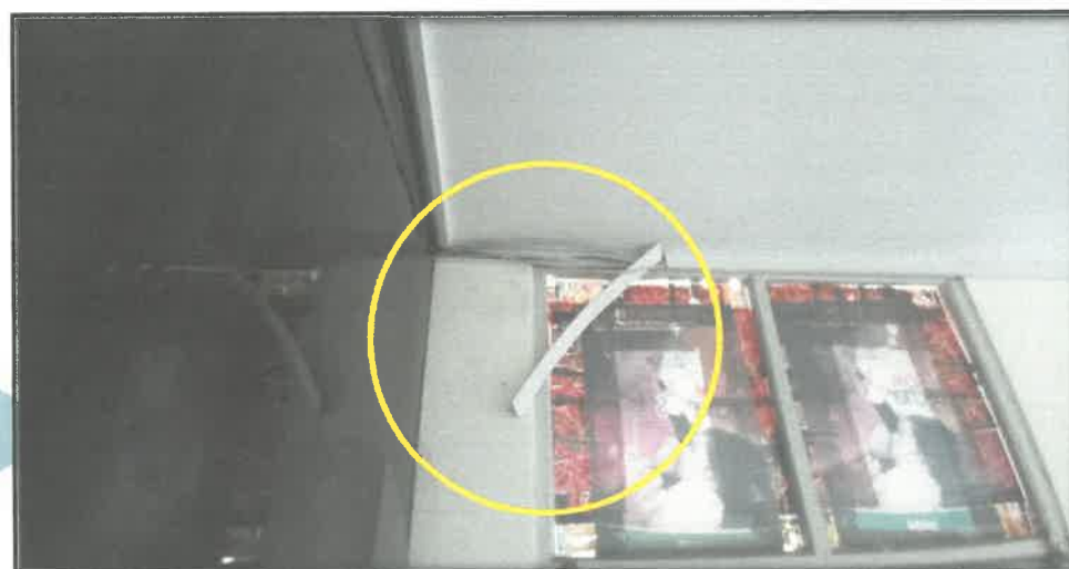
22. Canaletas en pésimas condiciones.
