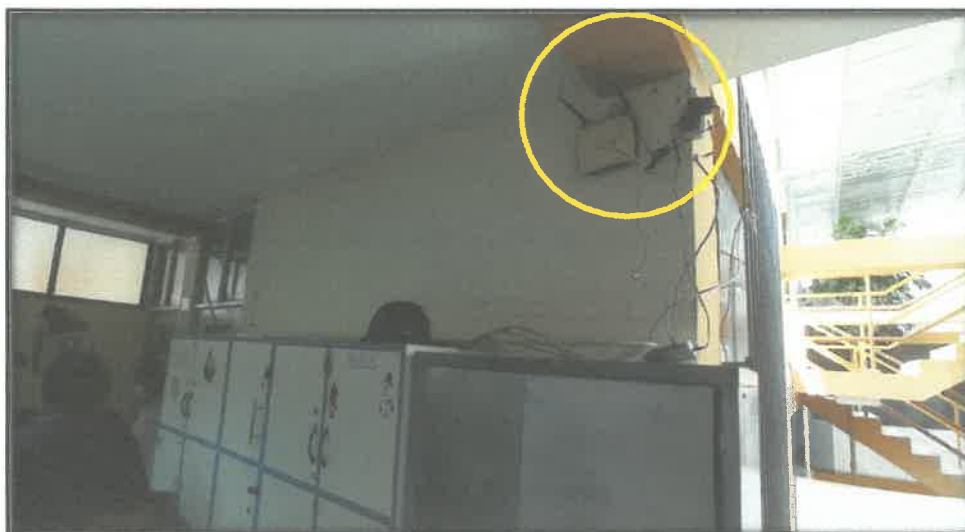
45. Router y cables DATA mal ubicados y en pésimas condiciones.
