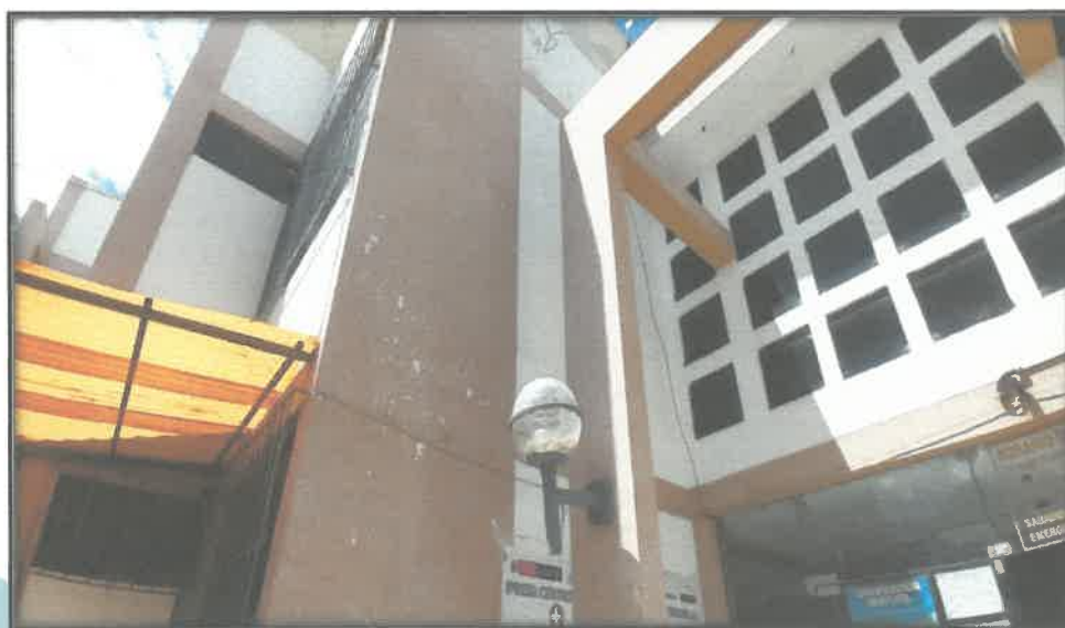
26. Cables de DATA expuesto a las condiciones climáticas.
