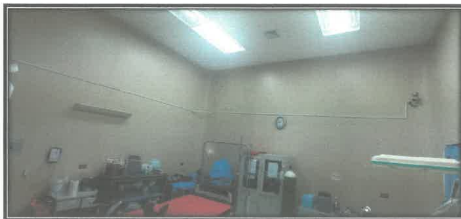
FOTO N°24: canaletas no aptas para el tipo de infraestructura, debido a que las existentes canaletas son inflamables siento considerado como un riesgo, así mismo no se encuentran los ángulos para un mejora estética visual .
