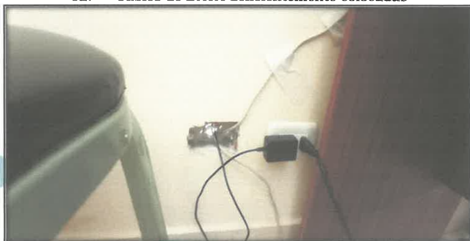
53. Cables de DATA deficientemente colocadas
