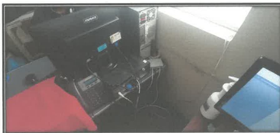
FOTO N°44: Se puede apreciar puntos de salida expuesto el cual no se encuentra empotrado a la pared, como también se ve cables sin canalizar.
