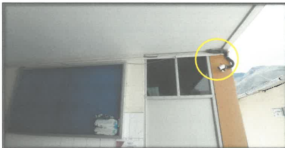
55. Cables de DATA expuestos por causa de canaletas deterioradas.
