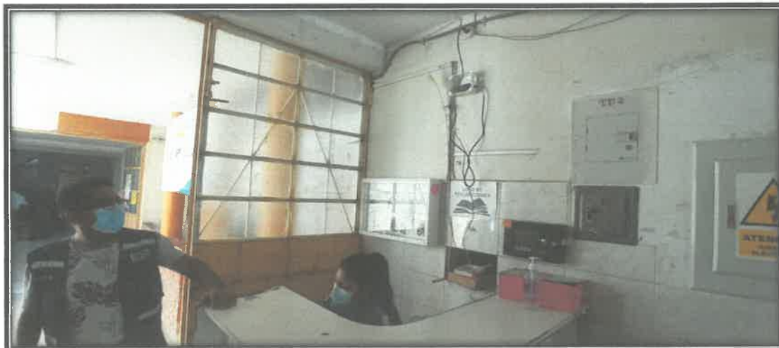
FOTO N°04: La falta de una correcta canalización en el corredor donde funciona un modulo de asistencia donde requieren adicionar una salida de data .
