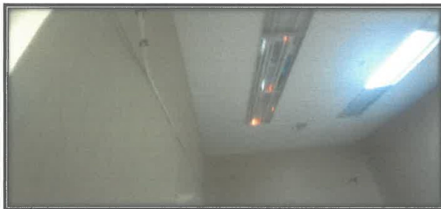
FOTO N°25: Canaleta en mal estado el cual, no se encuentra bien empotra hacia la pared.
