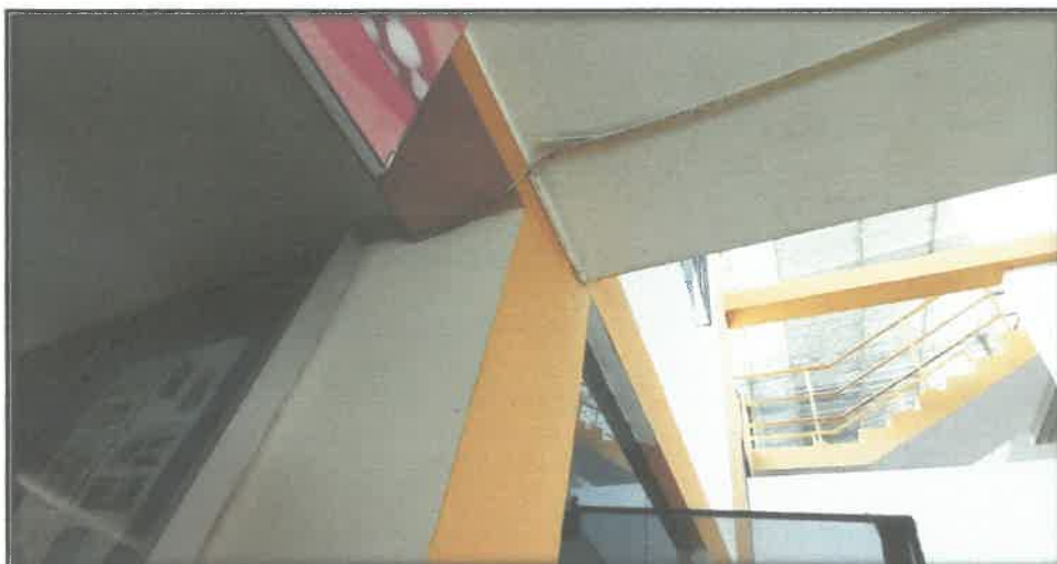
42. Cables expuestos por causa de canaletas deterioradas.
