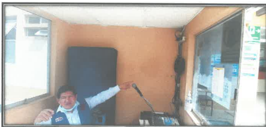
FOTO N°08: No se encuentra bien distribuidos los cables de data y comunicaciones el cual genera un peligro para el personal que labora en dicho lugar.
