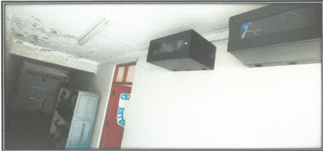
FOTO N°28: Los gabinetes en el tercer nivel para la distribución de redes en los ambientes continuos para la ampliación de puntos.
