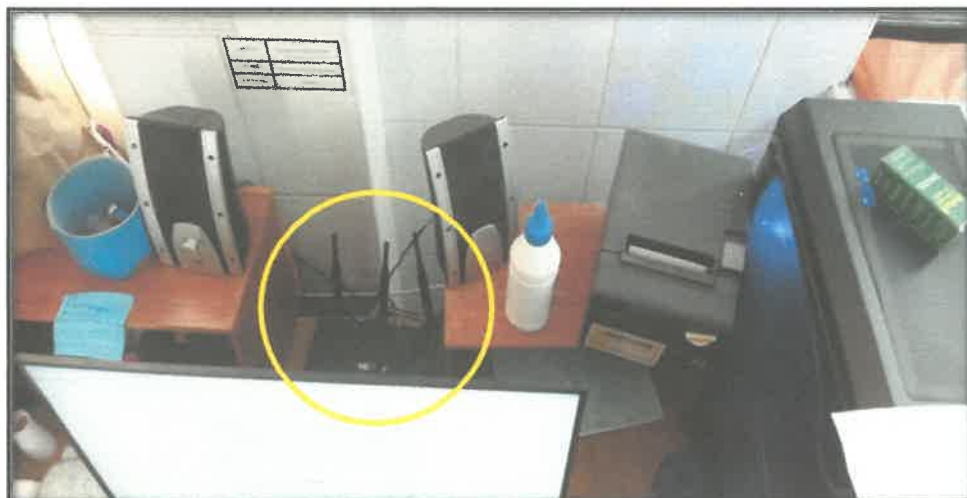
23. Router y cables expuestos y mal ubicados
