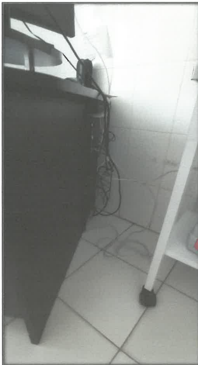
30. Cables de DATA sueltos siendo peligroso para el personal
