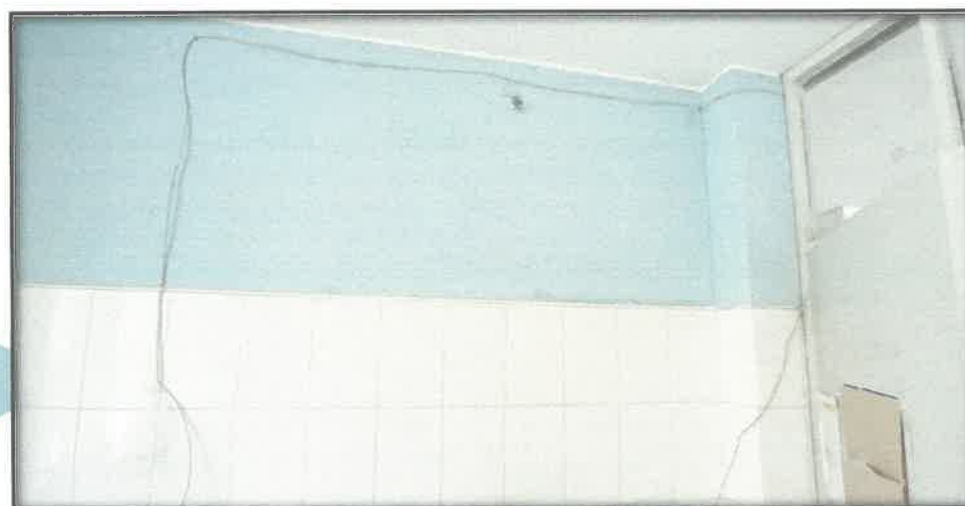
29. Falta de canaletas para Cables de DATA.
