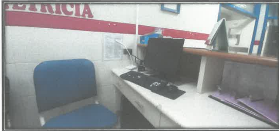
FOTO N°52: Se encuentra expuesto el cable sin una canalización respectiva.
