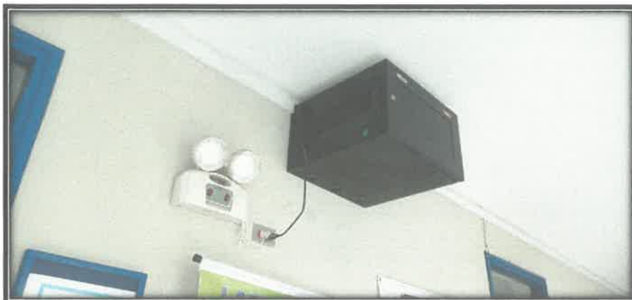
FOTO N°18: Gabinetes no requerido para la cantidad de puntos y distribución de data y comunicaciones.
