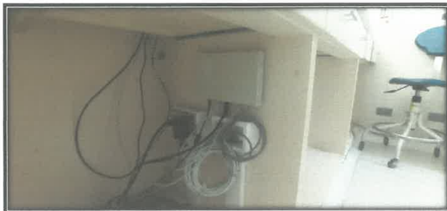
FOTO N° 33: Se aprecia cables enredados sin canalizar, el cual es peligroso para los trabajadores de dicha área de trabajo.
