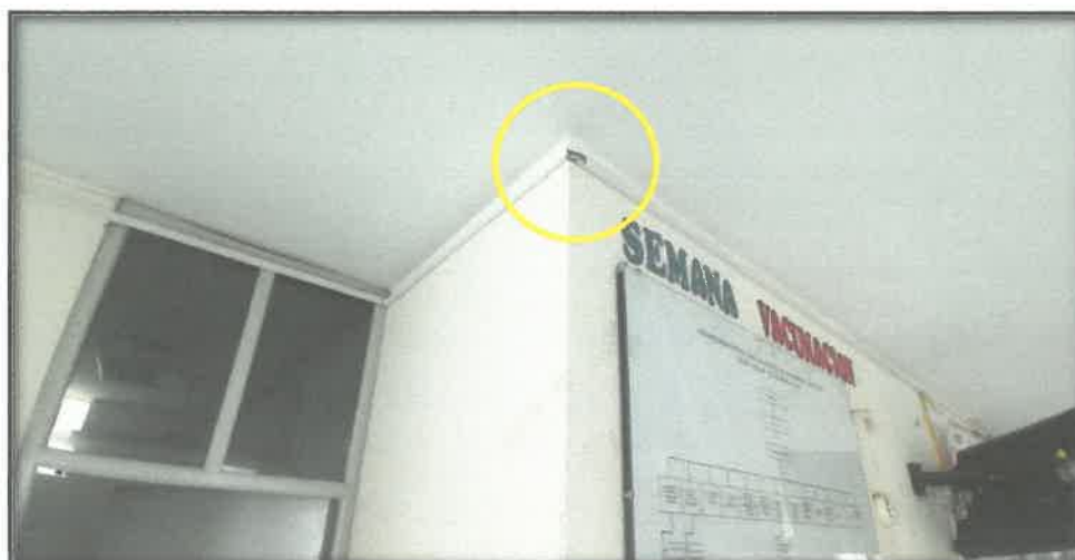
57. Canaletas deterioradas en la esquina del consultorio, generando cables expuestos.
