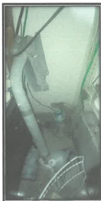
FOTO N° 35 y 36: cables enredados y deteriorados sienten esta un verdadero peligro.
