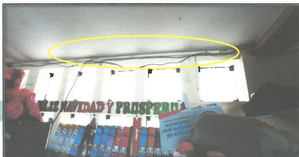
59. Pésima instalación de los cables de DATA
