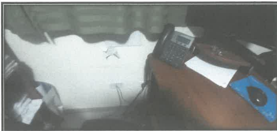
FOTO N°55: canaletas no aptas para el tipo de infraestructura, debido a que las existentes canaletas son inflamables siento considerado como un riesgo, así mismo no se encuentran los ángulos para un mejora estética visual .
