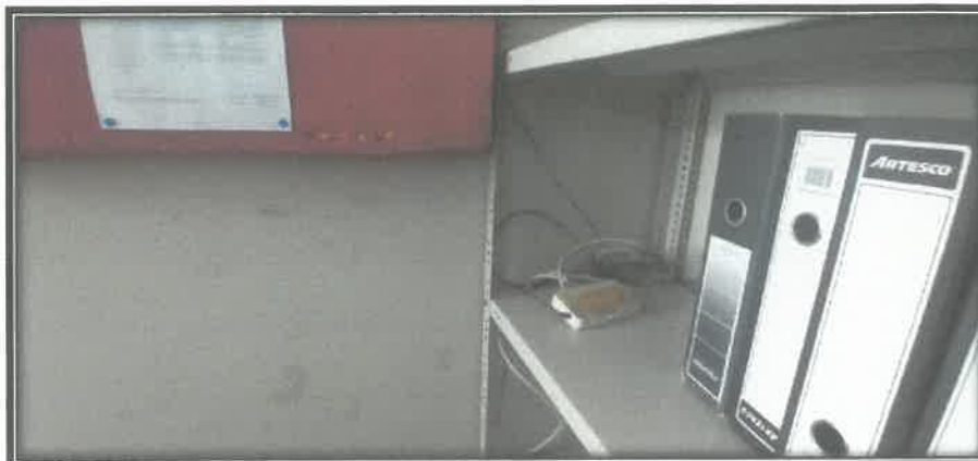
FOTO N°43: Se puede apreciar puntos de salida expuesto el cual no se encuentra empotrado a la pared, como también se ve cables sin canalizar.
