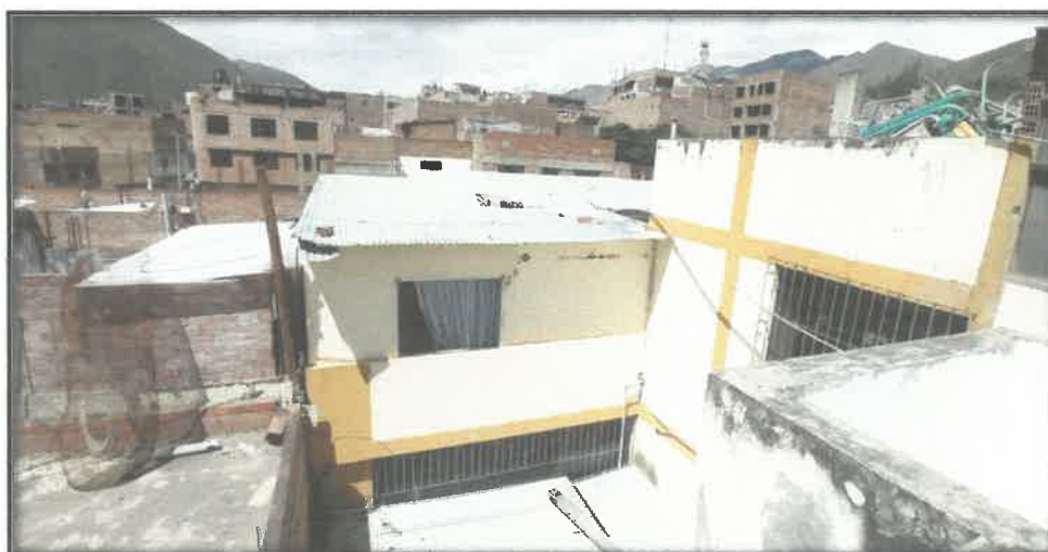
46. Cables expuestos al exterior dañándose por las condiciones climatológicas.
