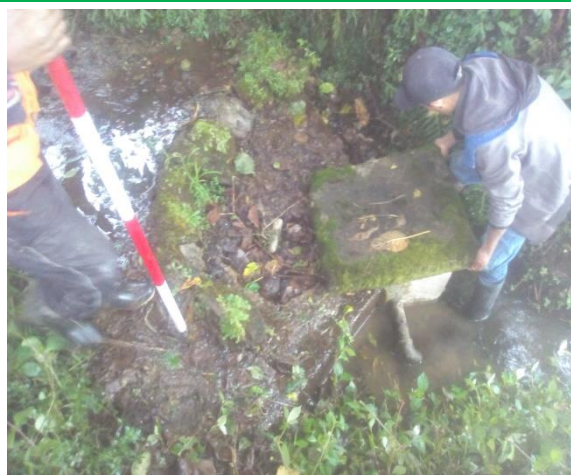
Se aprecia la captacion AGUA DULCE N° 03 llena de algas y sin cerco perimetrico IMAGEN N° 13 CAPTACION ACTUAL.
