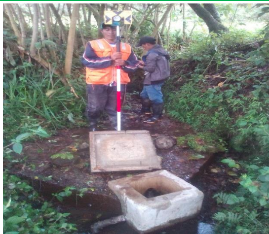
IMAGEN N° 12 CAPTACION ACTUAL. Se aprecia la captacion AGUA DULCE N° 03 en mal estado y sin mantenimiento.
