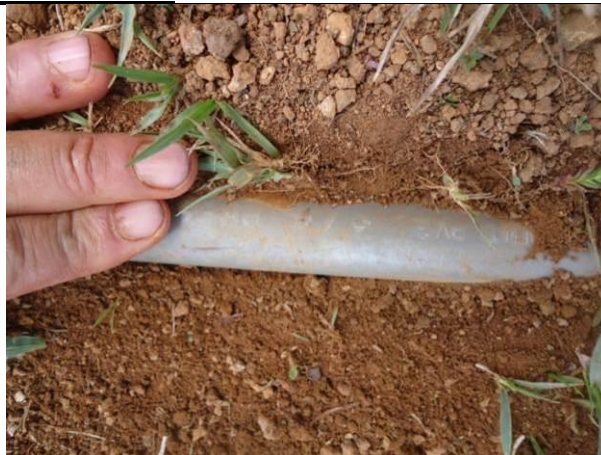
IMAGEN N° 20 Se constata que las tuberías no se encuentran enterrada a una profundidad adecuada, estando instaladas de forma muy superficial en casi todo su recorrido.
