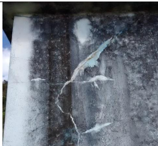
IMAGEN N° 18 Fisuras al exterior del reservorio
