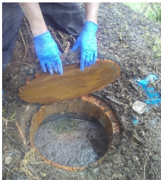
IMAGEN N° 26 Buzones colmatados y con fisuras
