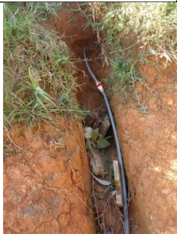
IMAGEN N° 19 Tubería PVC 3/4" C-10 expuesta a roturas, instalada en forma superficial.
