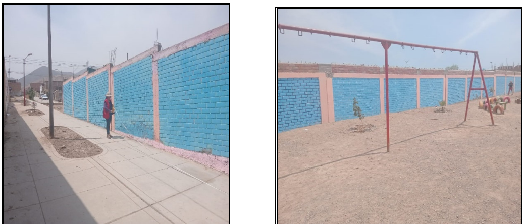
Figura 6,7,8. Cerco perimétrico en mal estado de conservación, en algunas zonas se encuentra el acero de refuerzo expuesto.
