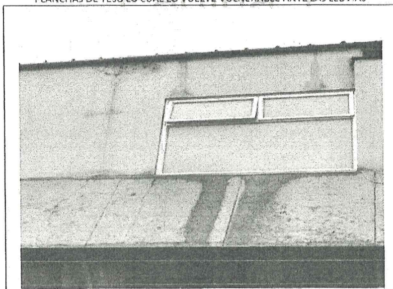
Foto 02: PARTES AFECTADAS DE PAREDES DE DRYWALL LAS CUALES SON DE PLANCHAS DE YESO LO CUAL LO VUELVE VULNERABLE ANTE LAS LLUVIAS
