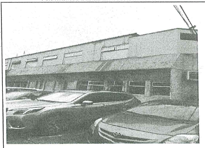
Foto 03: LAS FILTRACIONES OCURREN DEBIDO A LA FALTA DE AUN ADECUADO ALERO Y UNA FALTA DE CANALIZACIÓN DE AGUAS PLUVIALES
