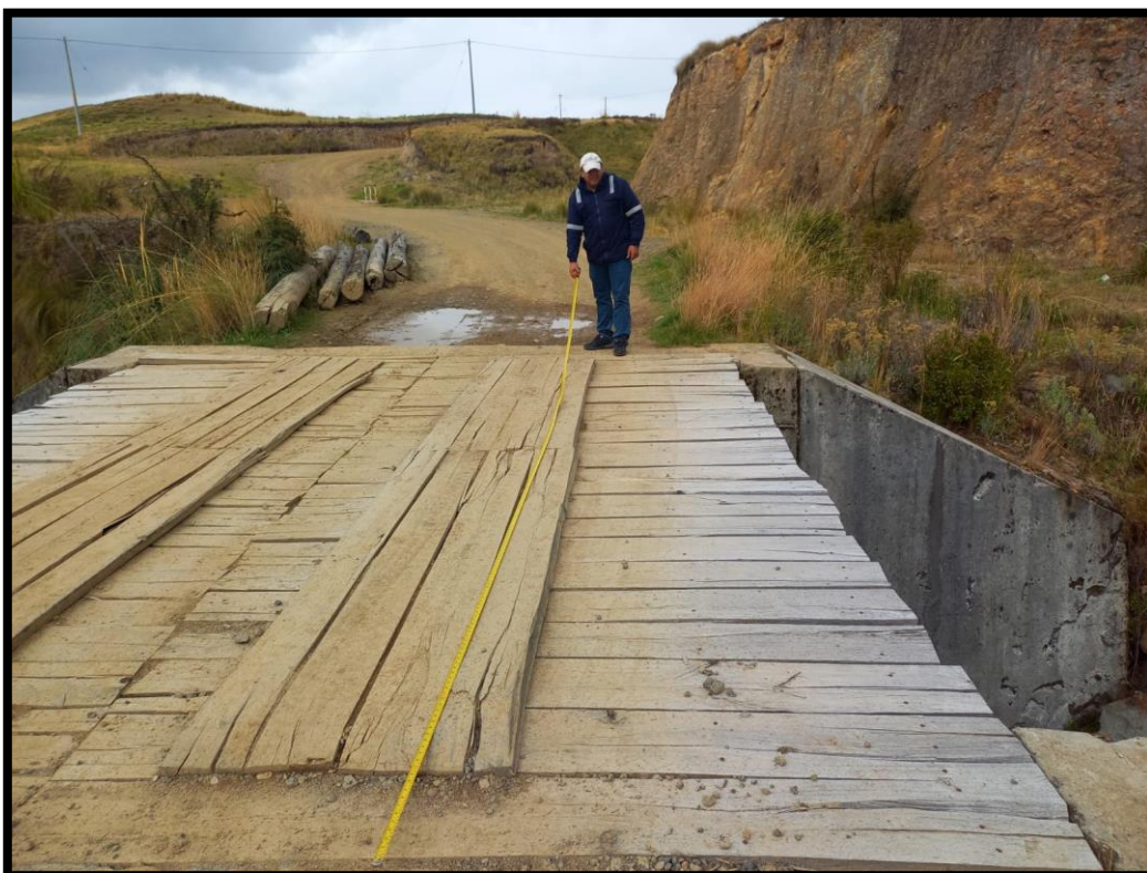
FOTO N°2: Se observa estribos de concreto y plataforma de madera en mal estado (se proyecta losa de concreto)
