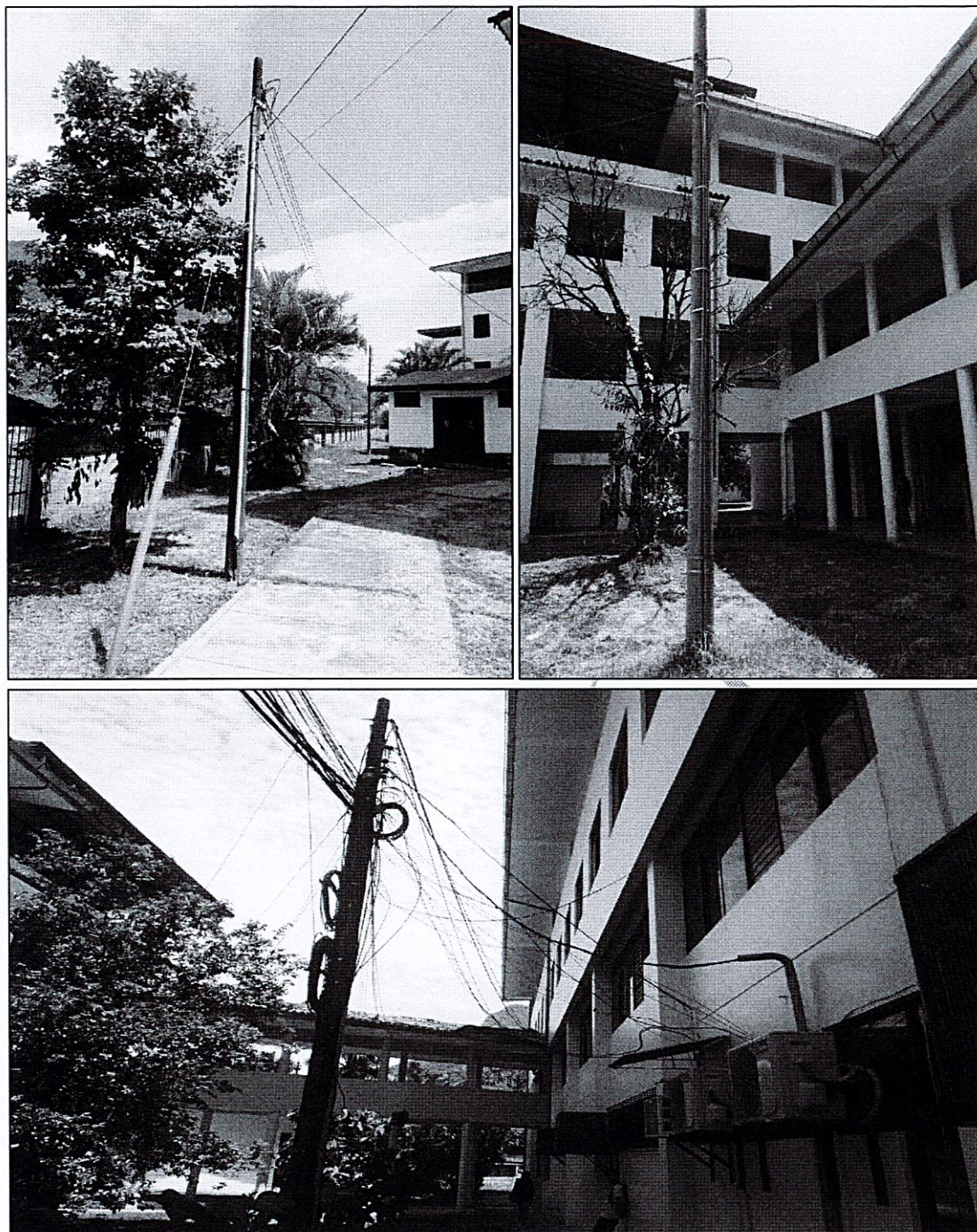
Algunas de las conexiones hacia los tableros generales de las edificaciones, con cables unipolares del tipo convencional, acometidas del tipo aéreo y/o subterráneo.
