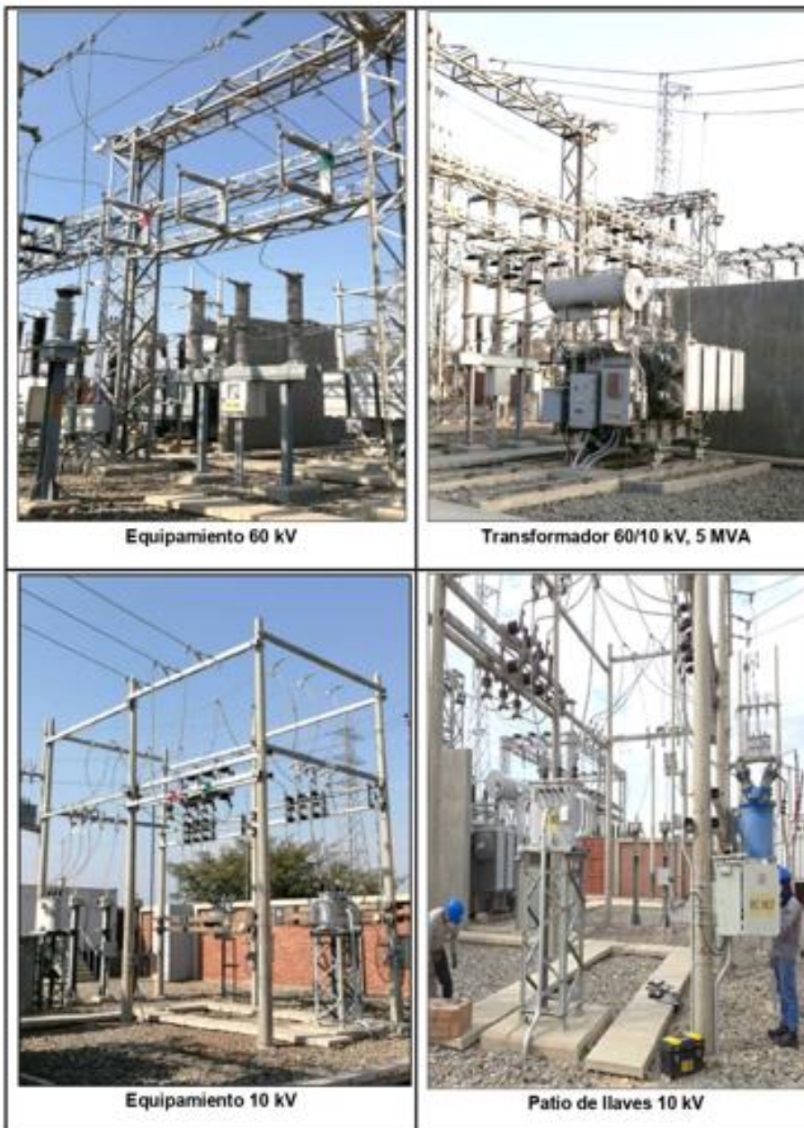
ANEXO N° 06 EQUIPAMIENTO EN SUBESTACIÓN OCCIDENTE
