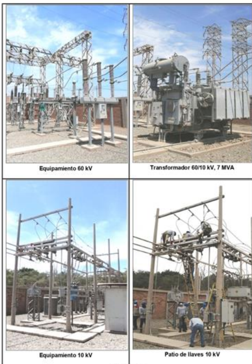
ANEXO N° 04 EQUIPAMIENTO DE SUBESTACIÓN ILLIMO
