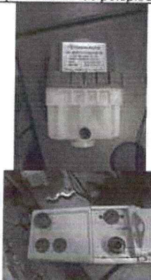
Foto 17: Cambio y suministro de los anillos de centrado de la bomba de vacío del microscopio electrónico
