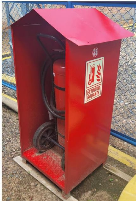
Fotografía N°01: Diseño de la caseta para los extintores PQS-50 Kg.
