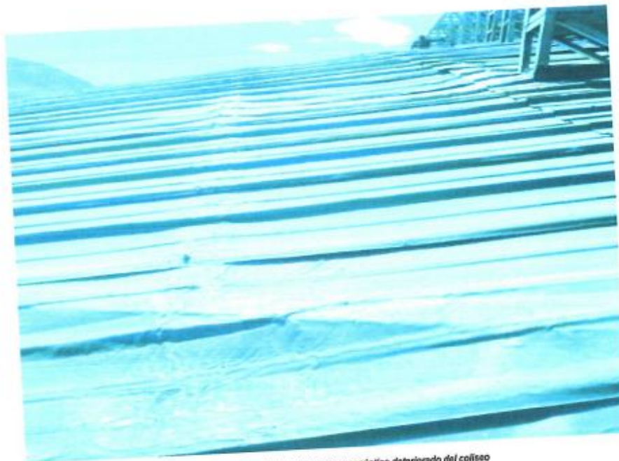
Imagen 05: vista superior de la cobertura termoacústico deteriorado del coliseo
