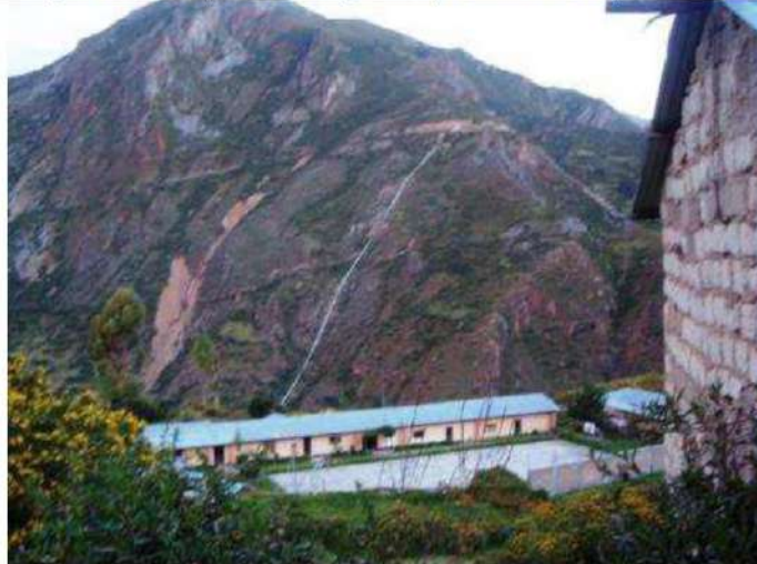
Tubería de presión de 572 m longitud x 0.45 m de diámetro de la CH Lluisita
