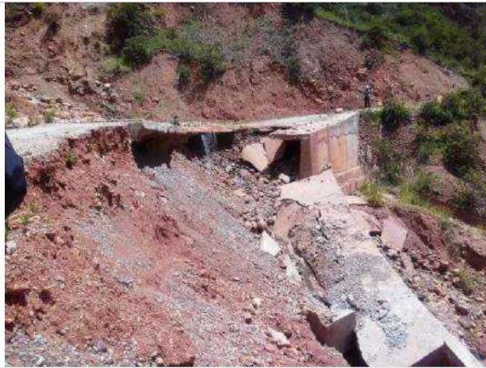
Acceso vehicular colapsada cerca al ingreso de la CH Llusita
