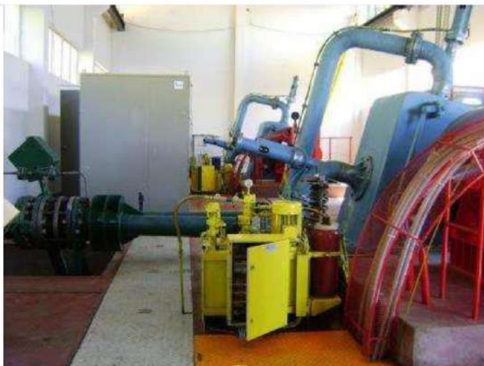
Tuberías de distribución de ingreso a los inyectores de dos (2) turbinas Pelton
