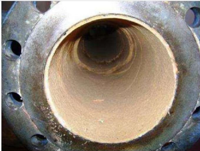
Formación del espesor de material calcáreo al interior de la tubería
