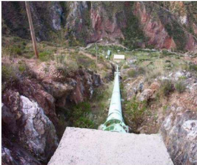
Tubería forzada, desde la cámara de carga
