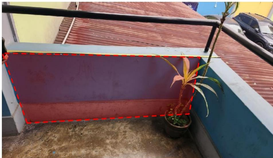
IMAGEN N° 02: Se observa el área de demolición y/o corte de parapetos para generar acceso al elevador para personas con discapacidad.
