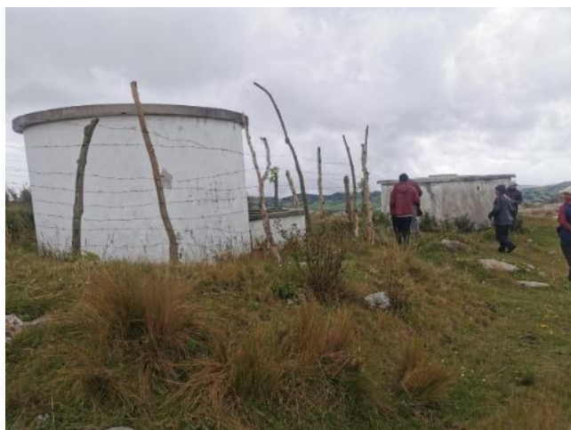
1.3. Sistema de agua Picachillo.- cuenta con 1 captación y un reservorio de 10 m3, para 52 usuarios
