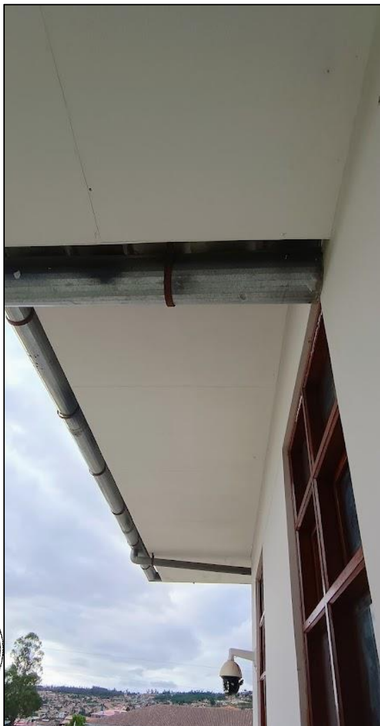
Imagen N°48: Vista de desgaste de masilla de relleno en juntas de planchas y tornillos de fijación en falso cielorraso exterior de planchas de fibrocemento.
