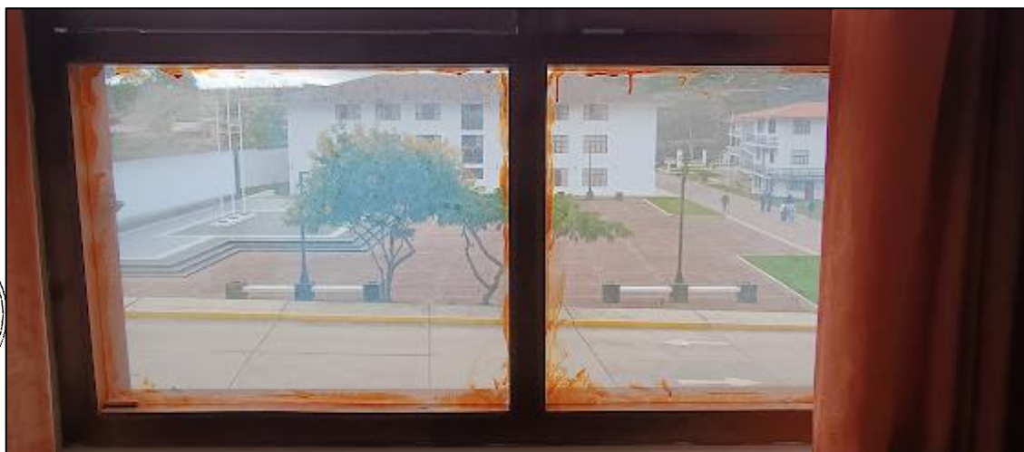
Imagen N°12: Vista de ventana fija y oscilante, con marco de madera y vidrio crudo 3mm. Se aprecia las manchas de barniz en el vidrio.
