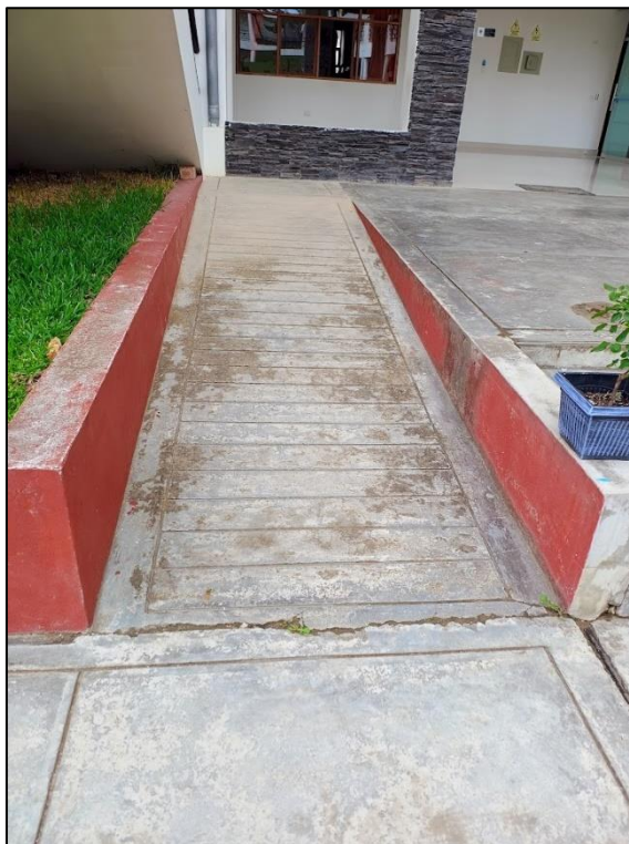
Imagen N°15: Vista de rampa de ingreso de acabado cemento pulido y bruñado, con desgaste y rasgos de humedad. Desprendimiento de pintura en sardineles de concreto.
