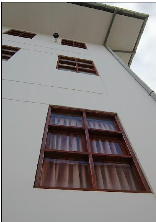
Imagen N°14: Vista de ventanas fijas y oscilantes en fachada oeste, con marco de madera y vidrio crudo 3mm. Se aprecia la rugosidad del acabado, el cual no se adherido bien y no se encuentra uniforme.
