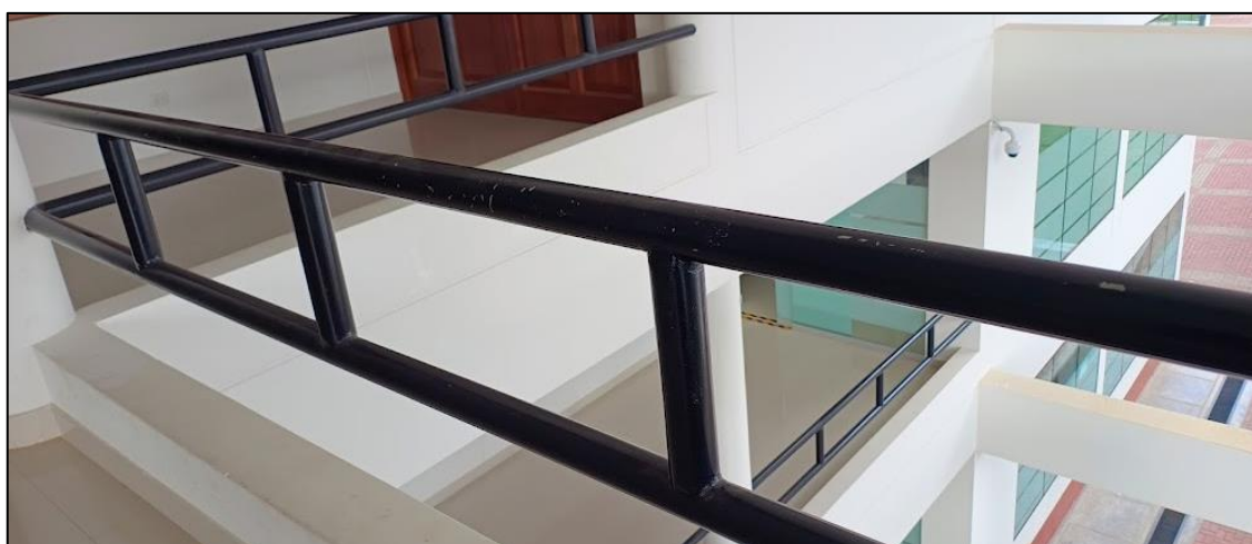
Imagen N°32: Vista de desprendimiento de pintura en barandas y muretes de escalera.
