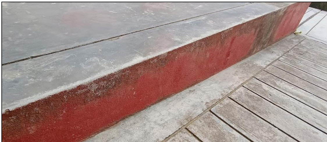
Imagen N°23: Vista de desprendimiento de pintura y humedad en sardineles de concreto.
