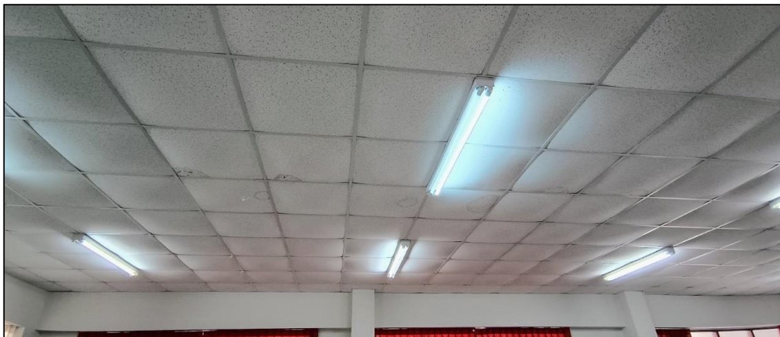
Imagen N°42: Vista de falso cielorraso de baldosas de fibra mineral en auditorio del tercer nivel. Se aprecia baldosas deformadas y presencia de humedad y moho, debido a filtración de agua de lluvia por cobertura.
