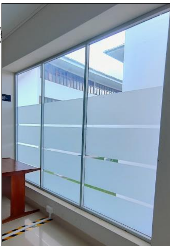
Imagen N°6: Vista de ventana de marco de aluminio y vidrio templado en buen estado en segundo nivel.
