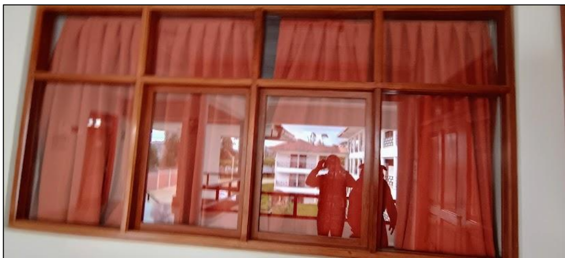
Imagen N°11: Vista de ventana fija y batiente con marco de madera y vidrio crudo 3mm en tercer nivel. Se aprecia decoloración del acabado de la madera por paso del tiempo.
