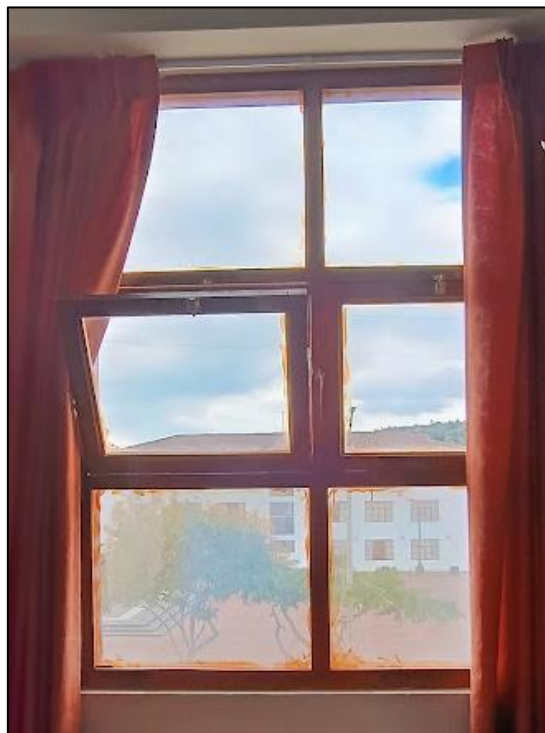
Imagen N°10: Vista de ventana fija y oscilante en fachada oeste, con marco de madera y vidrio crudo 3mm. Se aprecia las manchas de barniz en el vidrio.
