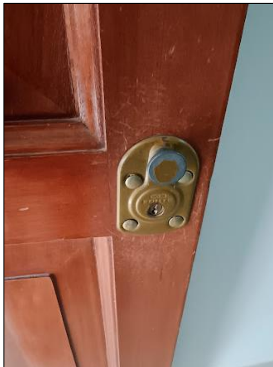
Imagen N°5: Vista de cerradura desgastada en oficina.
