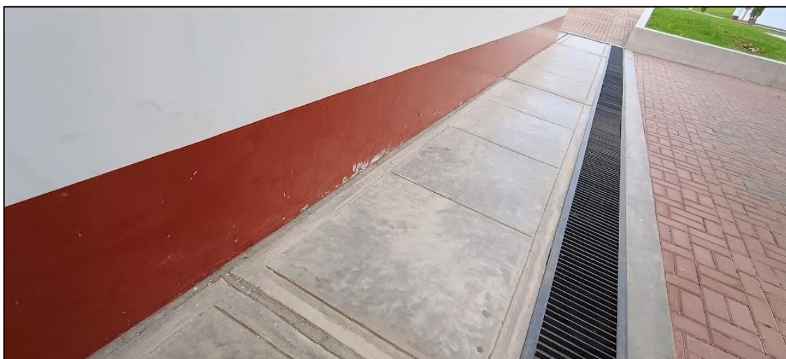
Imagen N°25 Vista de desprendimiento de pintura en sardineles de concreto.
