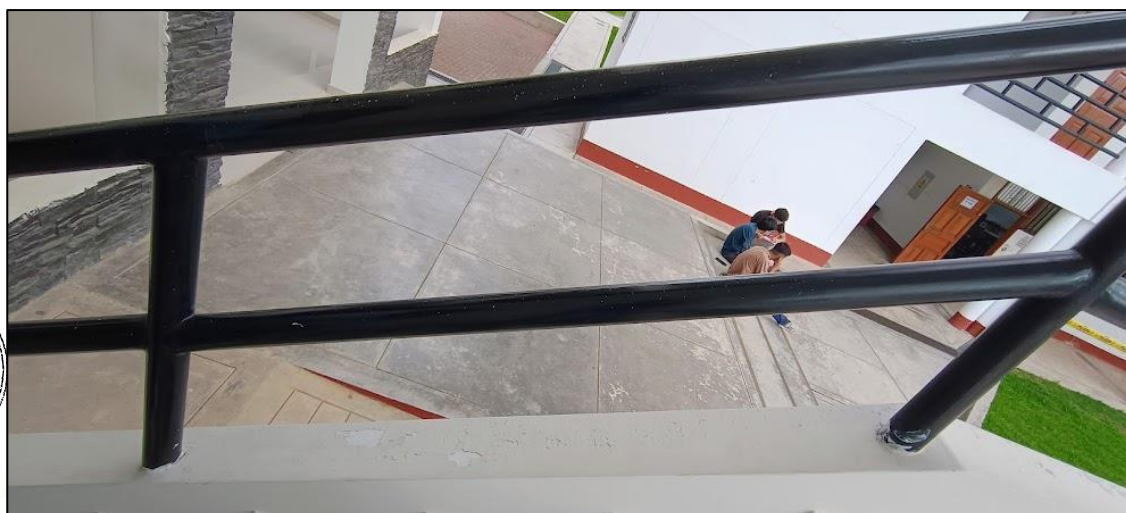
Imagen N°31: Vista de desprendimiento de pintura en barandas.
