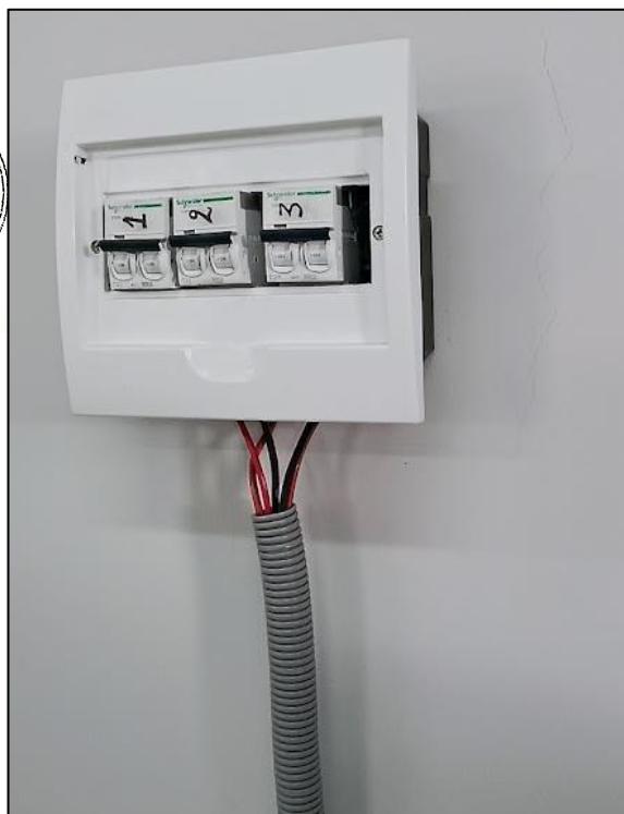
Imagen N°52: Tablero de distribución en 3er nivel (sala de cómputo) con caja expuesta y con cables expuestos.
