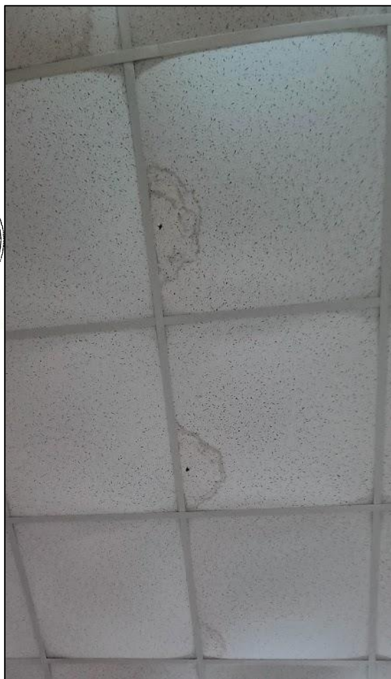
Imagen N°43: Desprendimiento de baldosas de fibra mineral por filtración de agua de lluvia.
