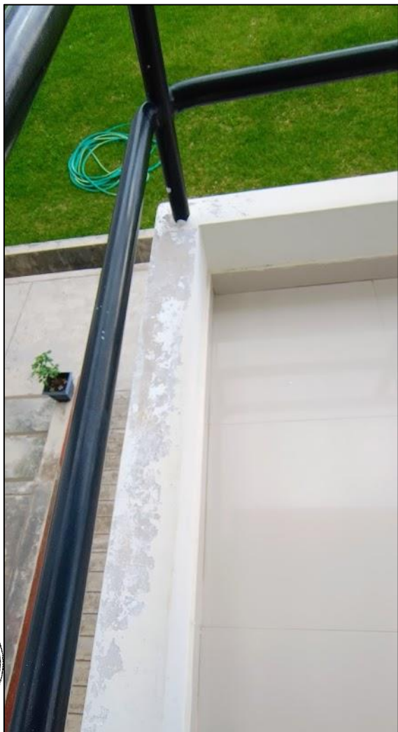
Imagen N°33: Vista de desprendimiento de pintura en barandas y muretes de escalera.
