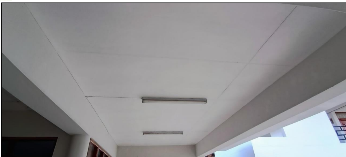
Imagen N°47: Vista de desgaste de masilla de relleno en juntas de planchas y tornillos de fijación en falso cielorraso exterior de plancha de fibrocemento.
