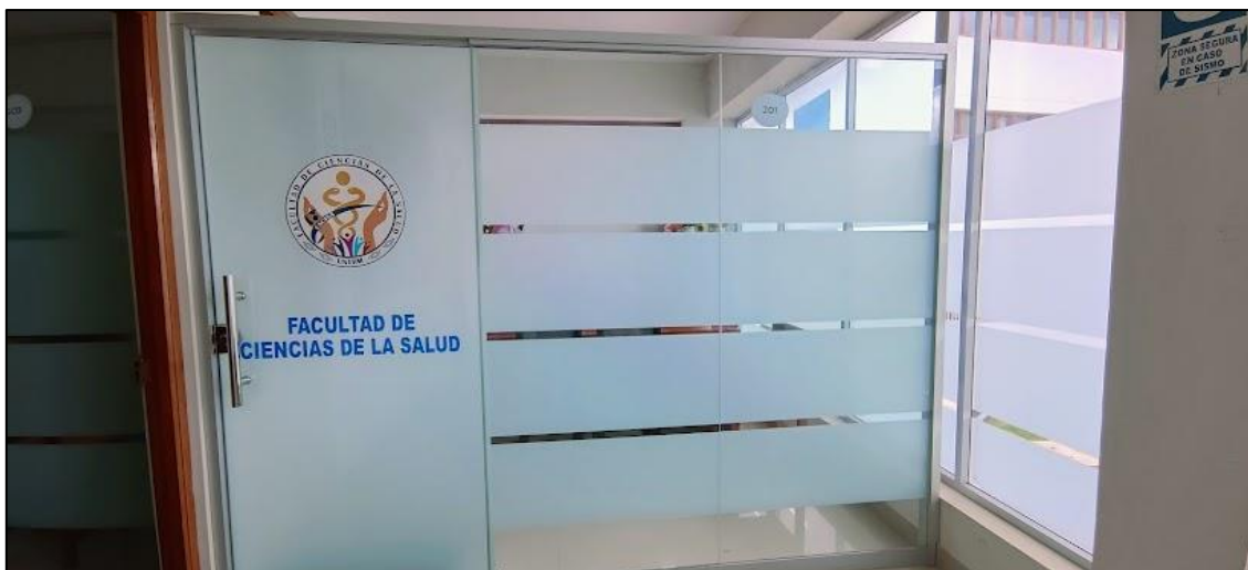
Imagen N°3: Vista de mamparas de marco de aluminio y vidrio templado en primer nivel en buen estado de conservación.
