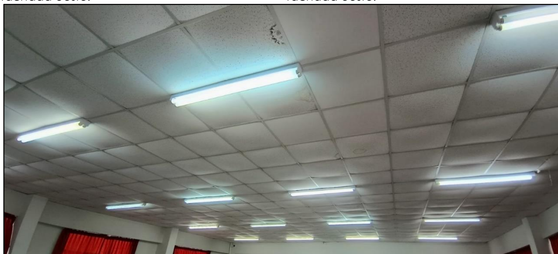
Imagen N°41: Vista de falso cielorraso de baldosas de fibra mineral auditorio del tercer nivel. Se aprecia baldosas deformadas y presencia de humedad y moho, debido a filtración de agua de lluvia por cobertura.
