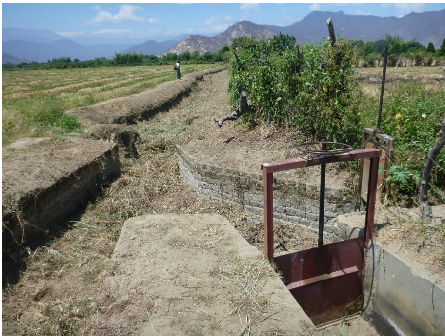
Fotografía 05: El partidor el tamarindo deteriorado en mal estado.
