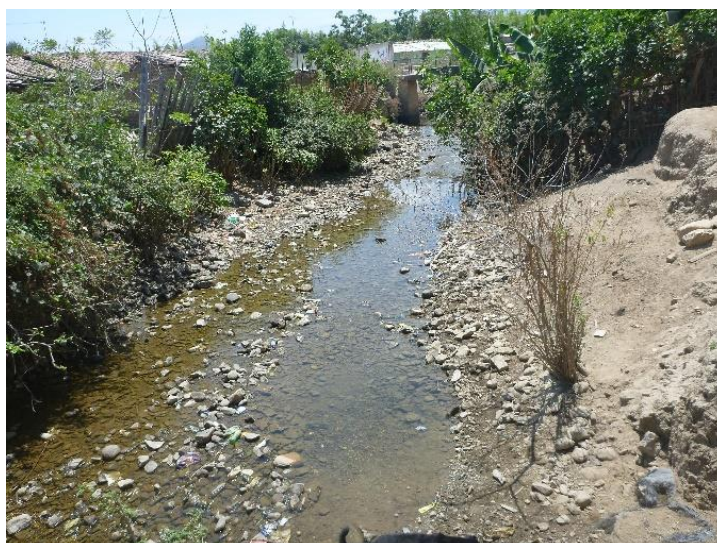
Fotografía 02: El canal presenta sedimentos, maleza y sin revestir.
