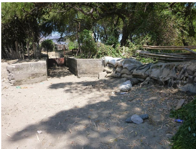
PARTIDOR LA PILCA COLAPSADO
