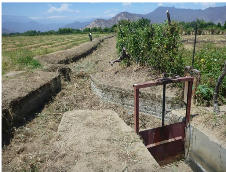
PARTIDOR TAMARINDO DETERIORADO
