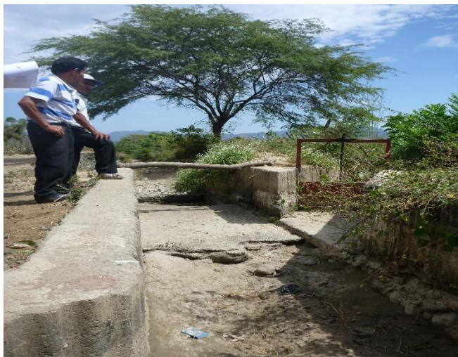
Fotografía 07: Retención y toma acosta en mal estado.
