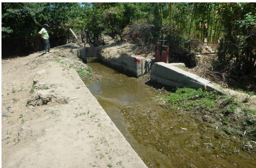
PARTIDOR EL GUAYABO DETERIORADO
