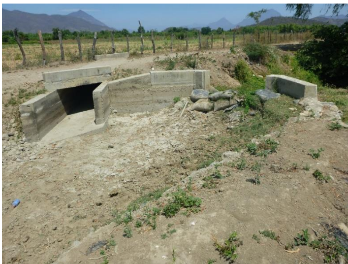
Fotografía 08: Aliviadero en mal estado para realizar su rehabilitación.
