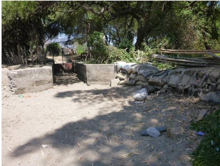
Fotografía 03: El partidor la pilca colapsada en mal estado.
