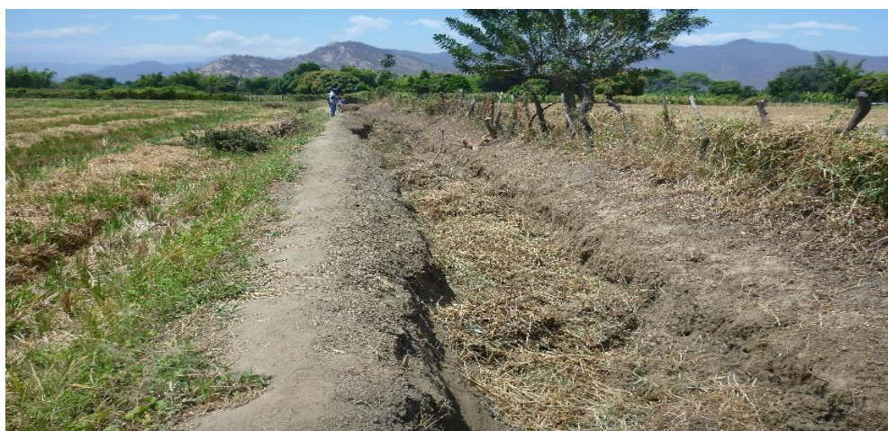
Fotografía 01: El canal presenta maleza y sin revestir.
