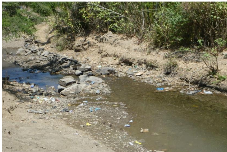
Fotografía 04: El canal presenta sedimentos, maleza, sin revestir y toma lateral rustica.
