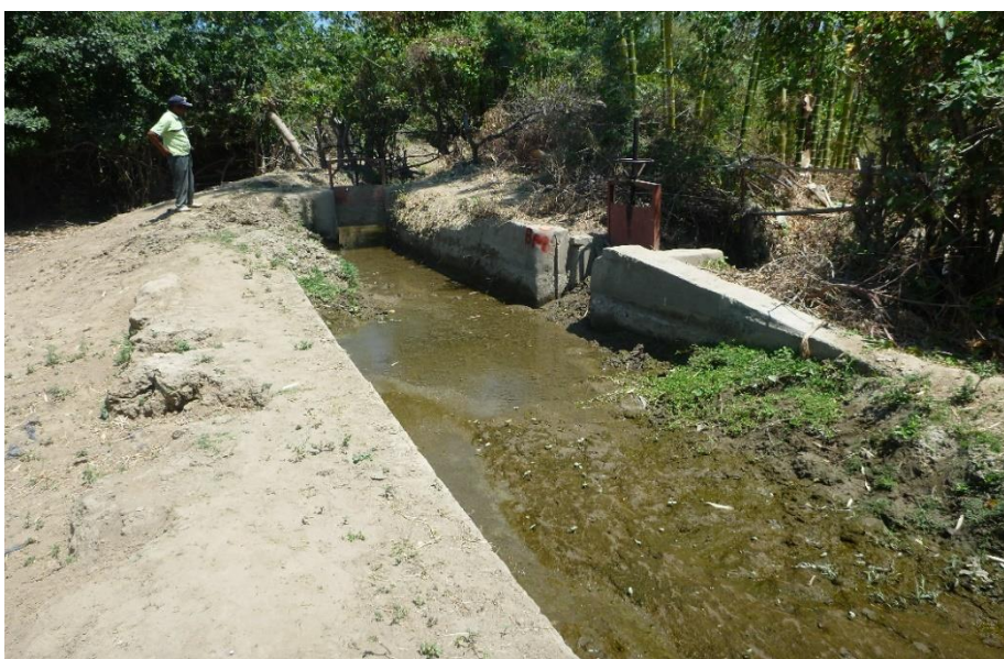
Fotografía 06: El partidor el guayabo deteriorado en mal estado.
