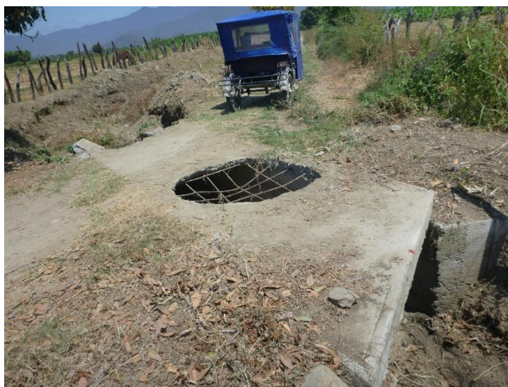
Fotografía 09: Puente alcantarilla en mal estado.
