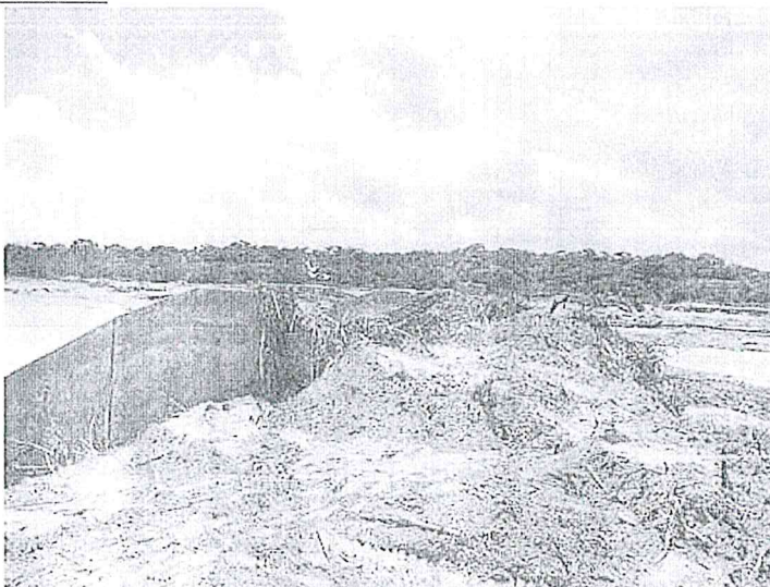
Presencia de material sólido a la altura de la bocatoma Huaca de la Cruz.
