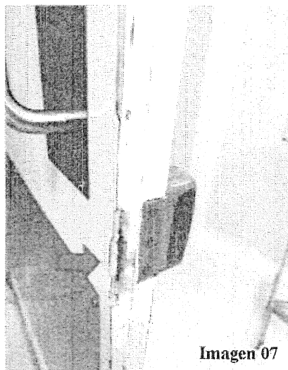
Imagen 07 y 08: Canto de hoja de la puerta con abolladura.
