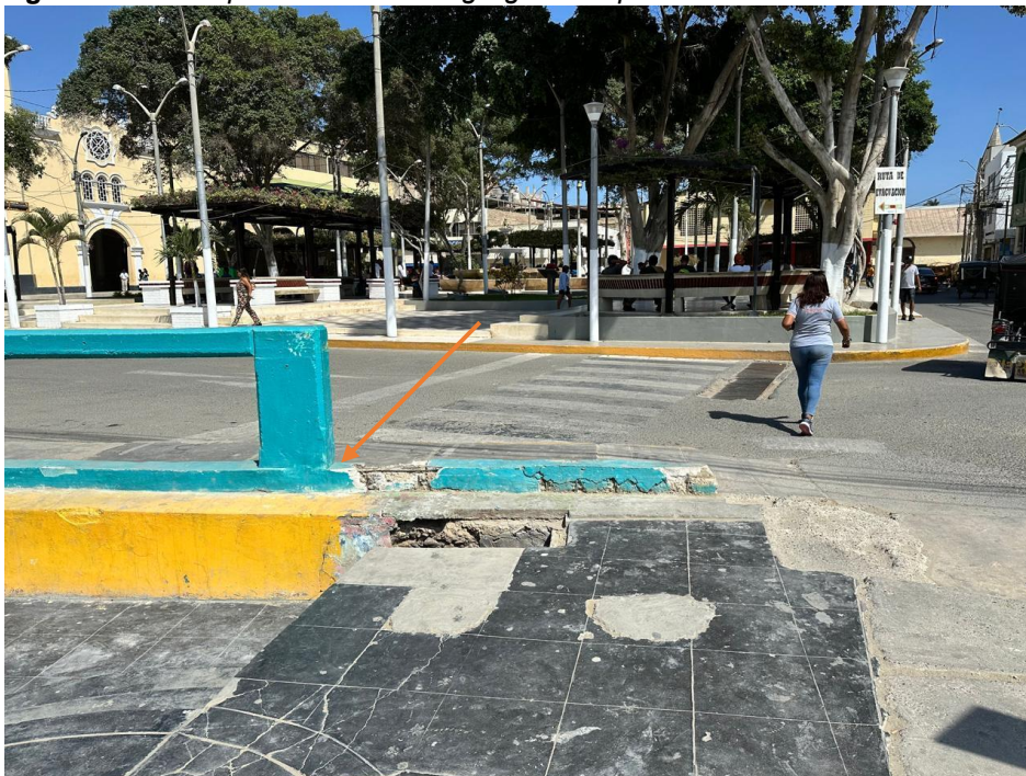
Imagen N°03: Gradas agrietadas Zona Zanjón.
