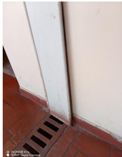
Piso pasadizos exteriores. Zócalos y junta constructiva entre bloques
