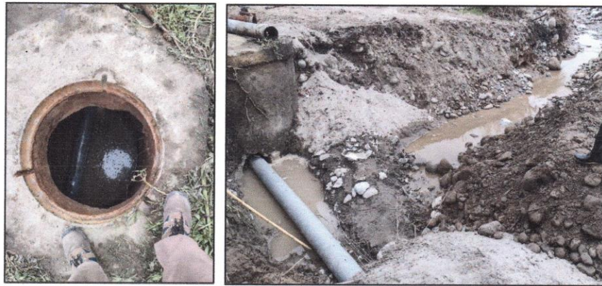
Imagen N°02: Afectación a la línea de conducción (Red de agua Potable)
