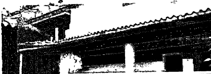
PARTI INTERNA DE LA COBERTURA EXISTENTE DE TERMOCLIMA POR EL PASO DE LOS AÑOS
