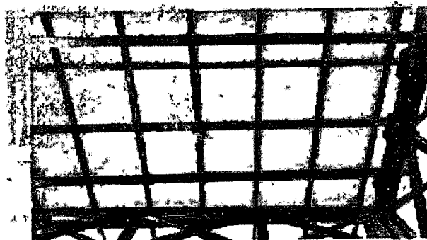
REJILLA DE MALLA AFECTADA POR RUSTO, DUELO A LA COBERTURA EN MAL ESTADO
